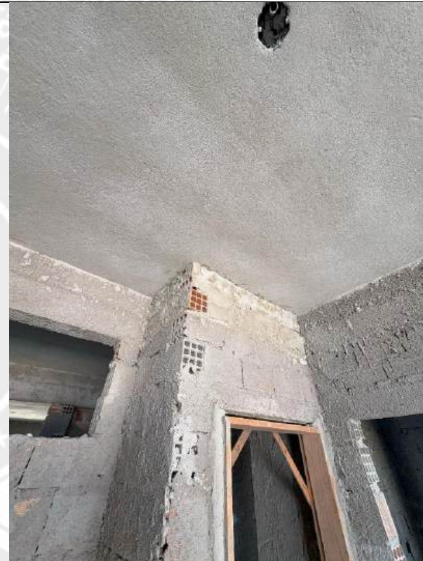
Foto 46 - Encunhamento de alvenaria
