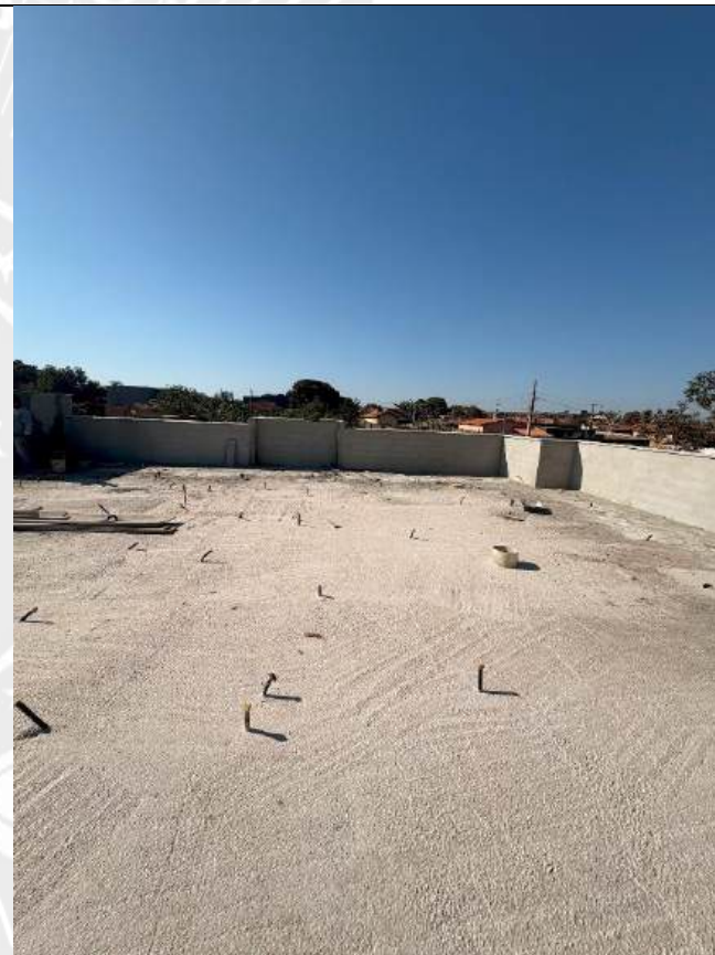
Foto 20 – Reboco e execução de pingadeiras
