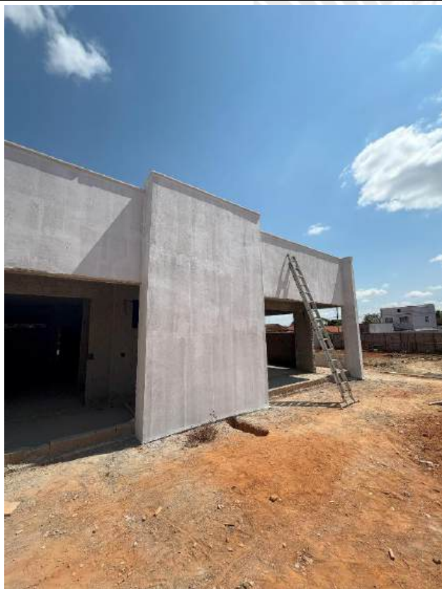
Foto 49 – Preparação de alvenaria e aplicação de selador
