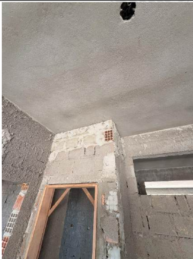
Foto 41 – Encunhamento de alvenaria
