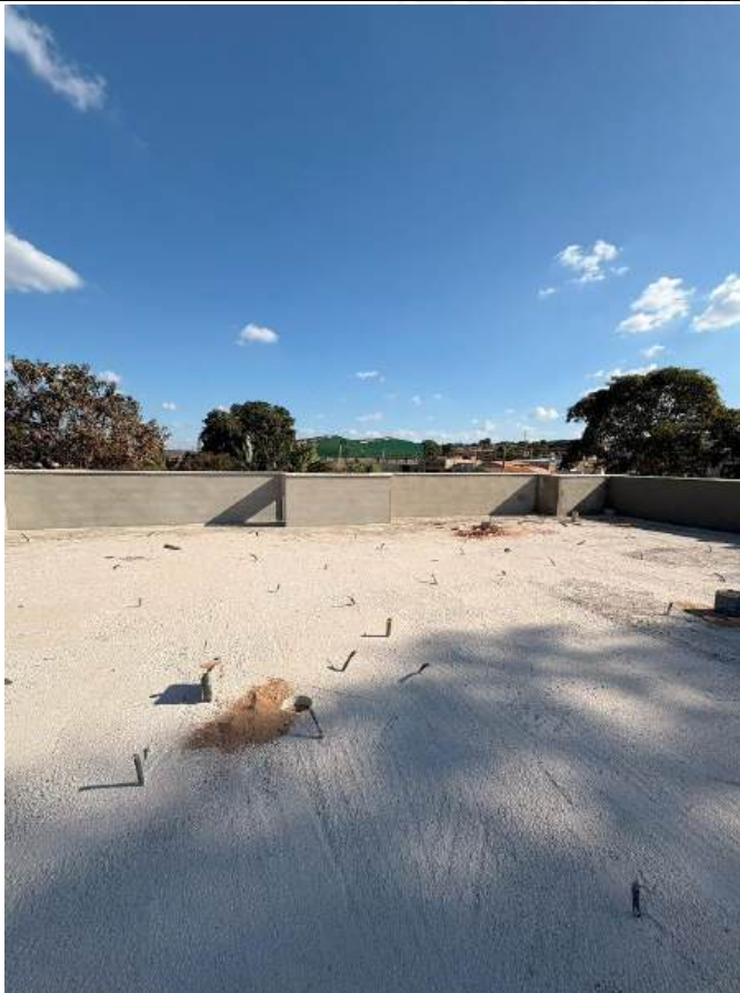
Foto 11 – Reboco e execução de pingadeiras
