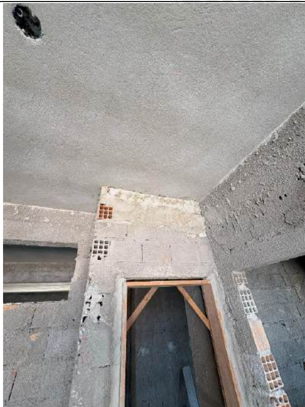
Foto 45 - Encunhamento de alvenaria
