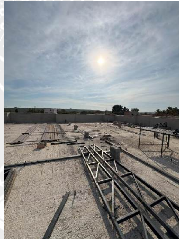
Foto 30 - Execução estrutura telhado
