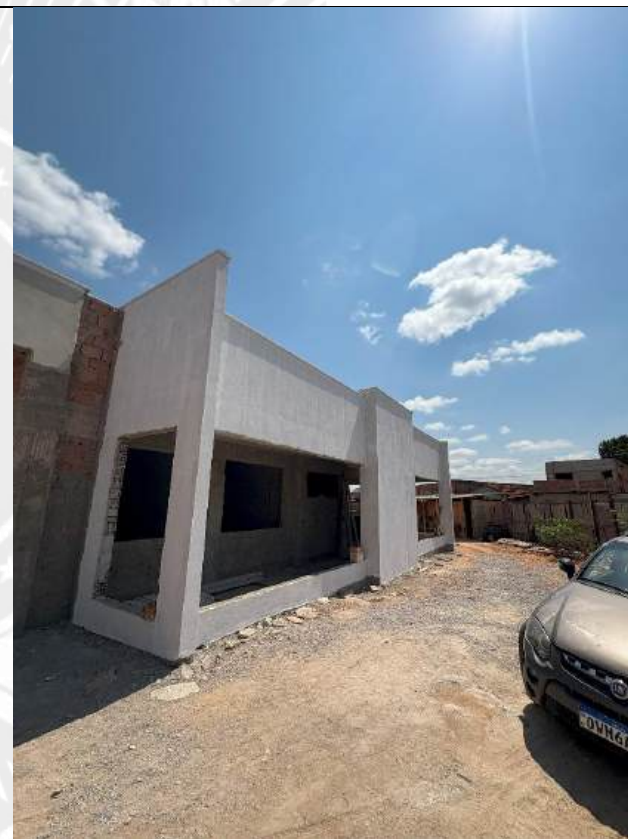
Foto 68 – Preparação, lixamento e aplicação de selador em alvenaria
