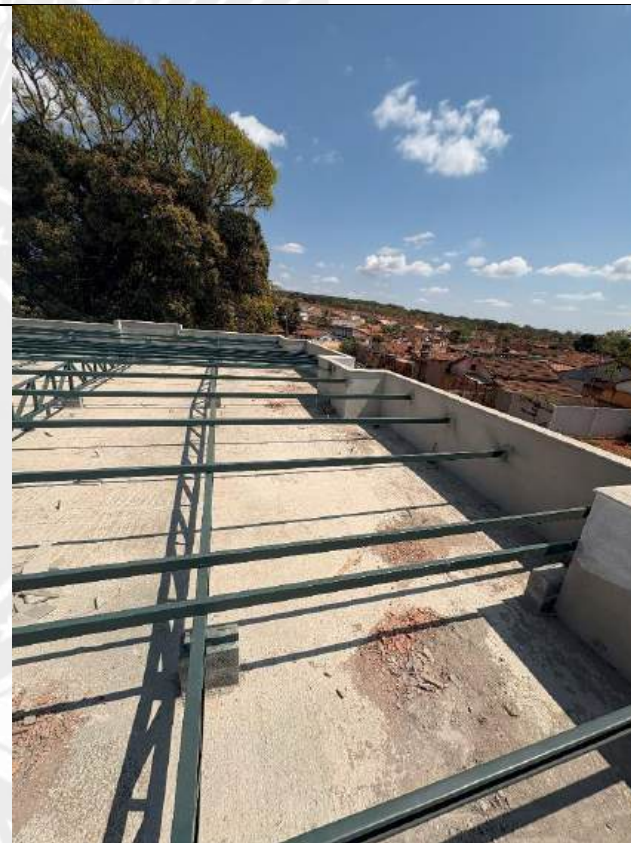
Foto 50 – Execução de estrutura do telhado
