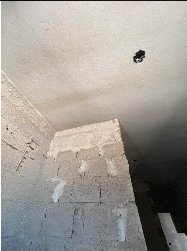
Foto 57 – Encunhamento de alvenaria
