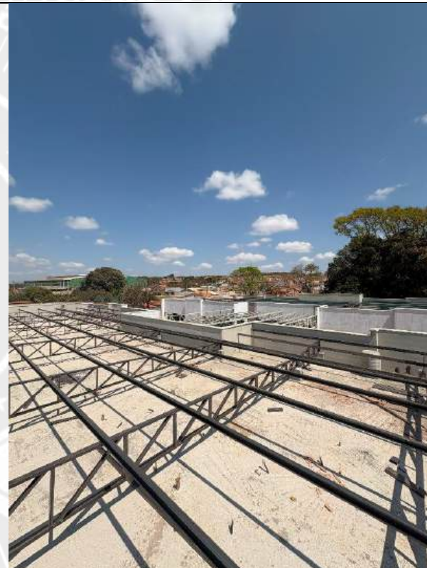
Foto 62 – Execução de estrutura do telhado
