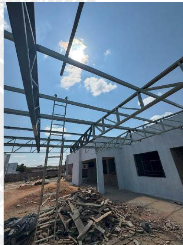
Foto 34 – Execução estrutura telhado
