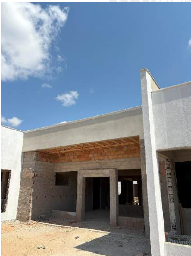
Foto 67 – Preparação, lixamento e aplicação de selador em alvenaria
