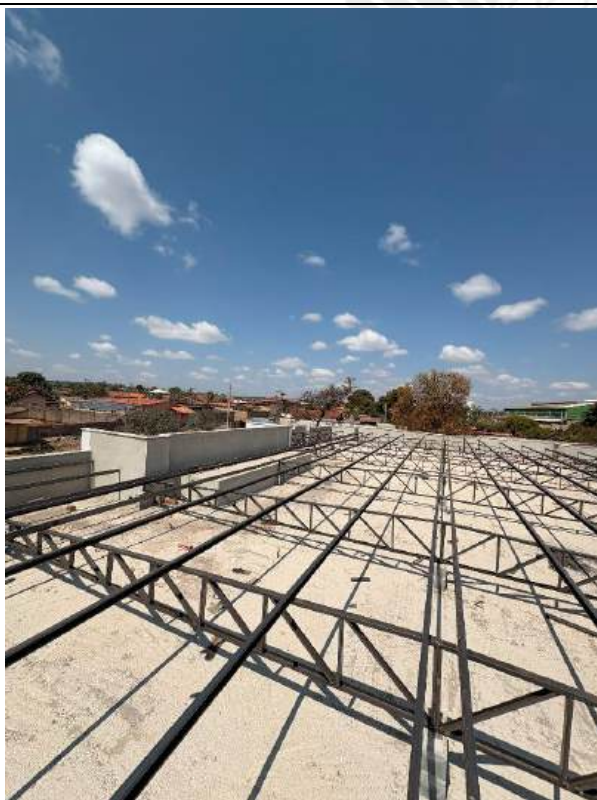
Foto 61 – Execução de estrutura do telhado
