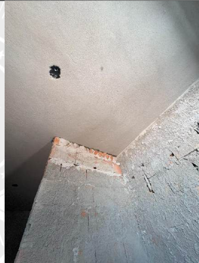
Foto 58 – Encunhamento de alvenaria
