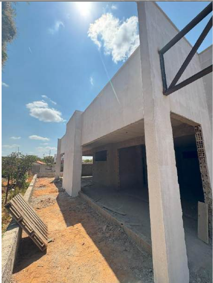
Foto 39 – Preparação de alvenaria e aplicação de selador
