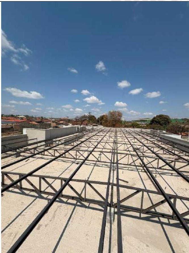
Foto 59 – Execução de estrutura do telhado
