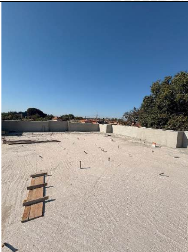
Foto 19 – Reboco e execução de pingadeiras
