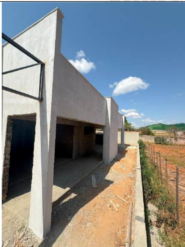
Foto 37 – Preparação de alvenaria e aplicação de selador
