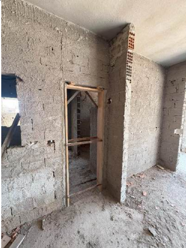
Foto 47 - Encunhamento de alvenaria
