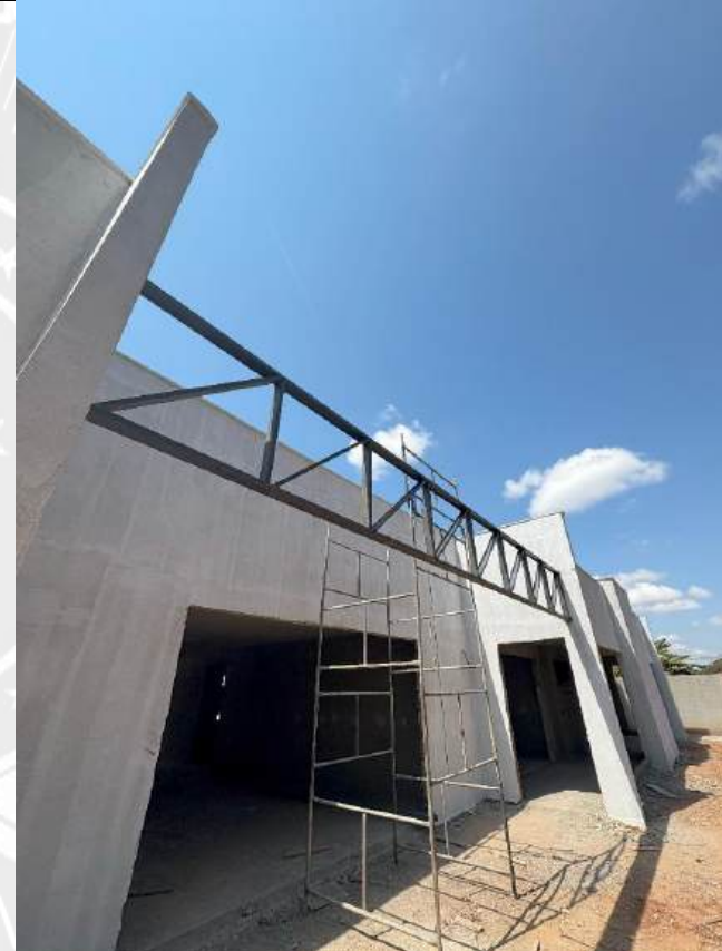
Foto 36 - Execução estrutura telhado, preparação de alvenaria e aplicação de selador
