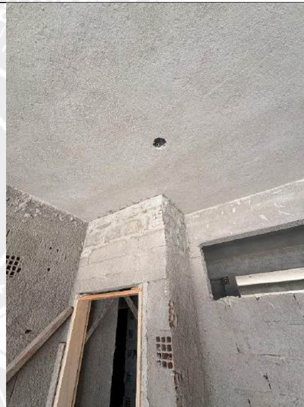
Foto 56 – Encunhamento de alvenaria
