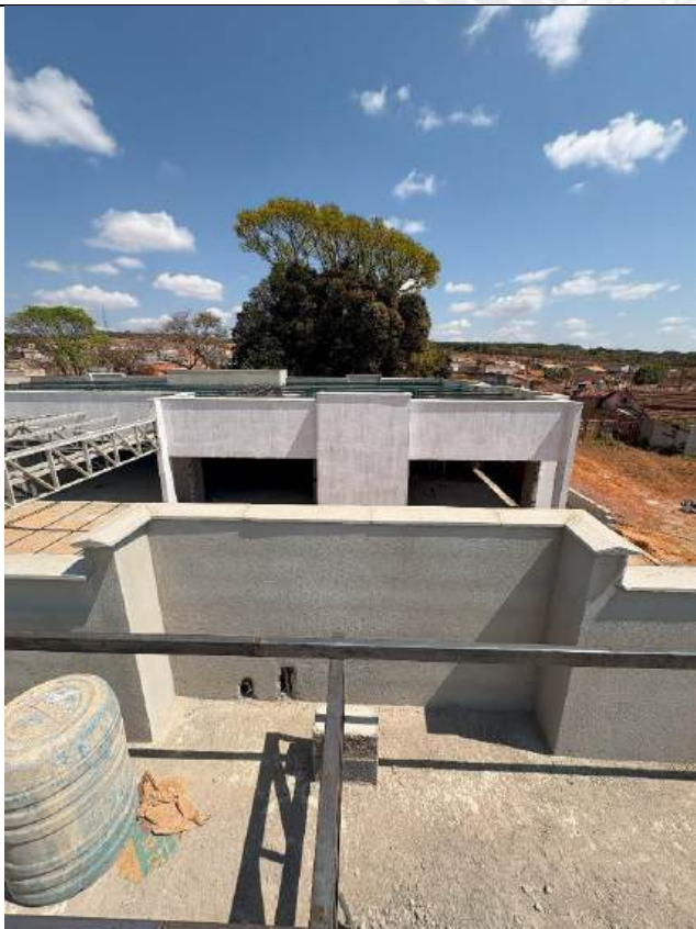
Foto 63 – Execução de pingadeira
