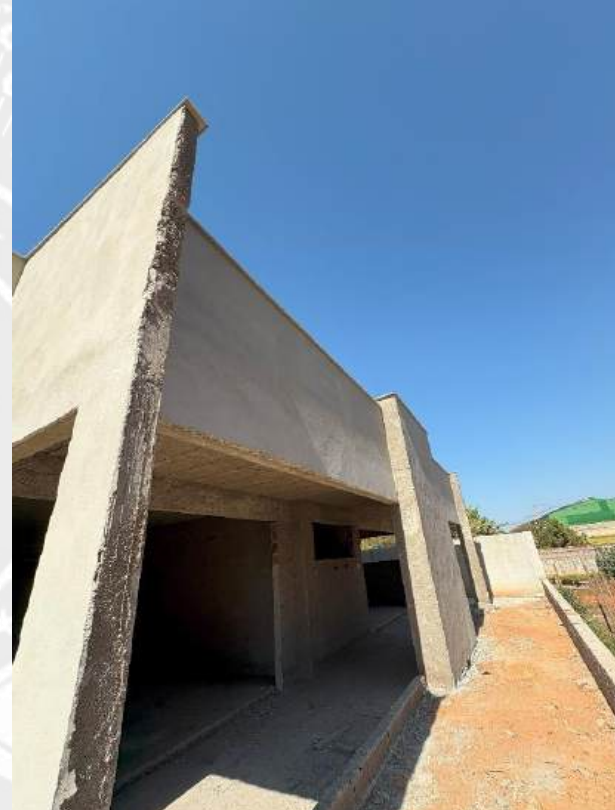
Foto 26 – Reboco e execução de pingadeiras
