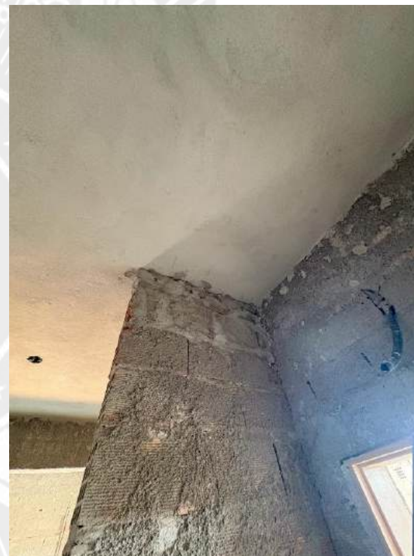
Foto 42 - Encunhamento de alvenaria
