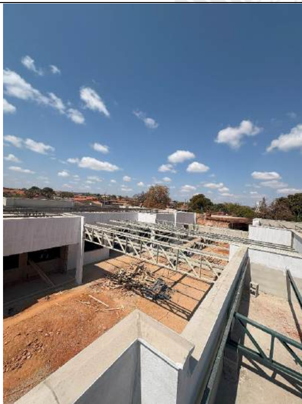
Foto 55 – Execução de estrutura do telhado
