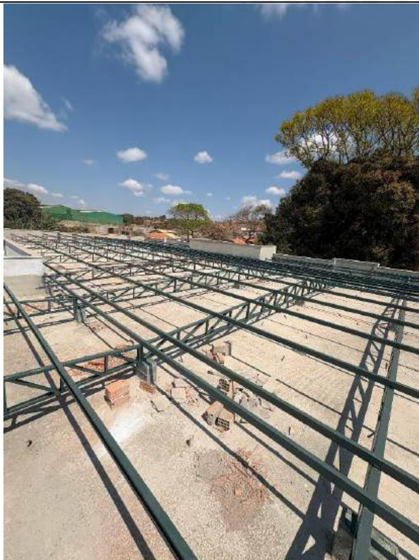
Foto 51 – Execução de estrutura do telhado
