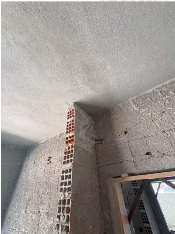
Foto 43 - Encunhamento de alvenaria
