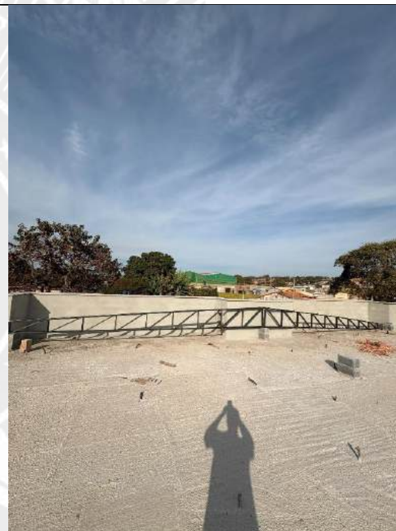
Foto 28 – Execução estrutura telhado
