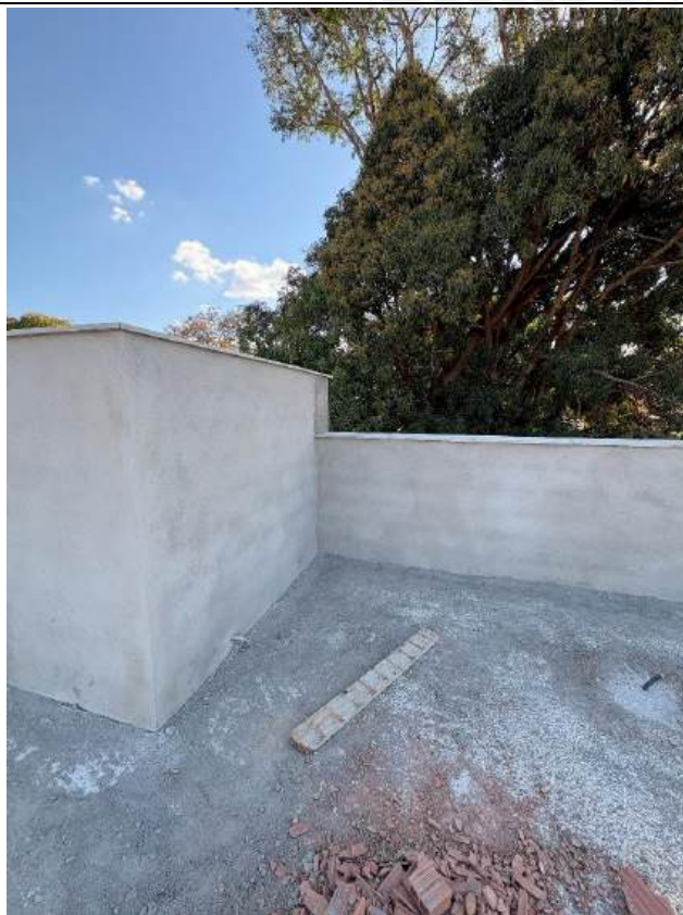
Foto 5 - Reboco e execução de pingadeiras
