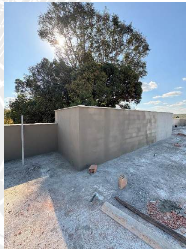
Foto 4 – Reboco e execução de pingadeiras
