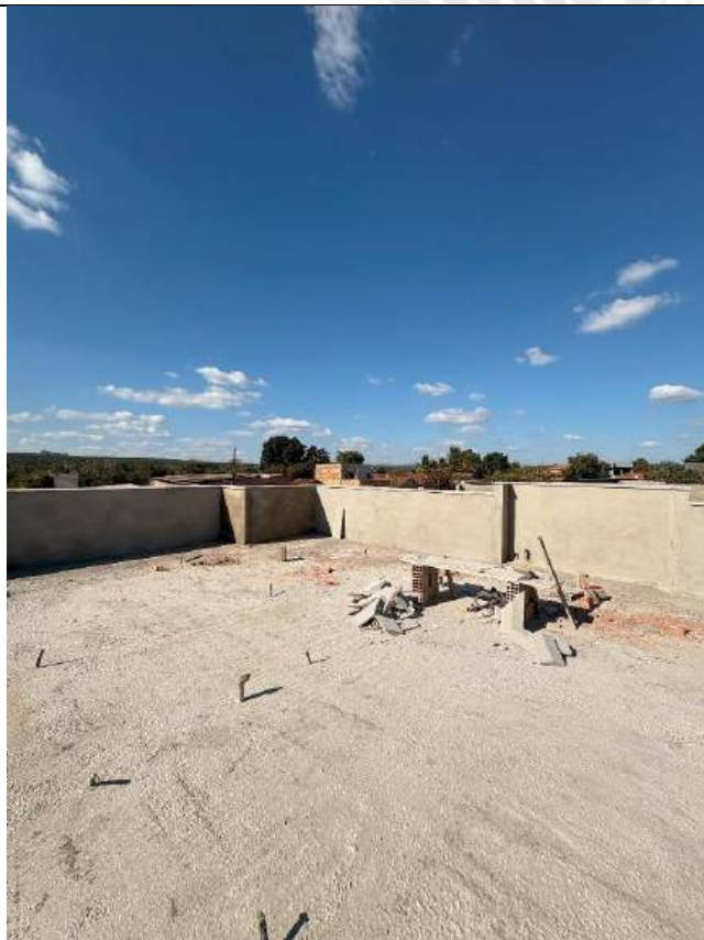
Foto 9 – Reboco e execução de pingadeiras
