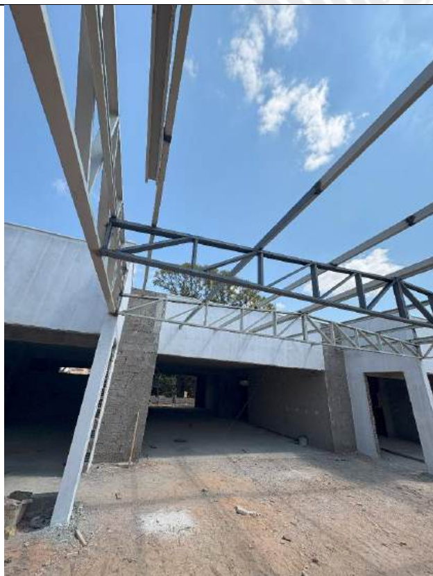
Foto 33 – Execução estrutura telhado
