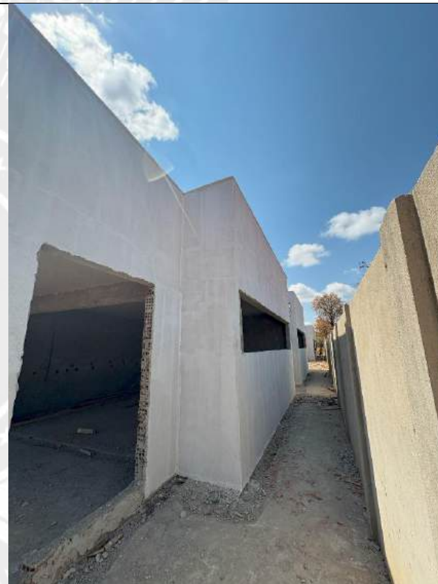
Foto 38 - Preparação de alvenaria e aplicação de selador
