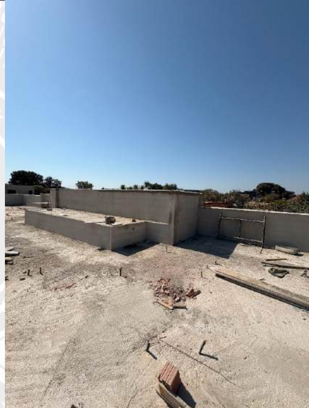
Foto 22 – Reboco e execução de pingadeiras
