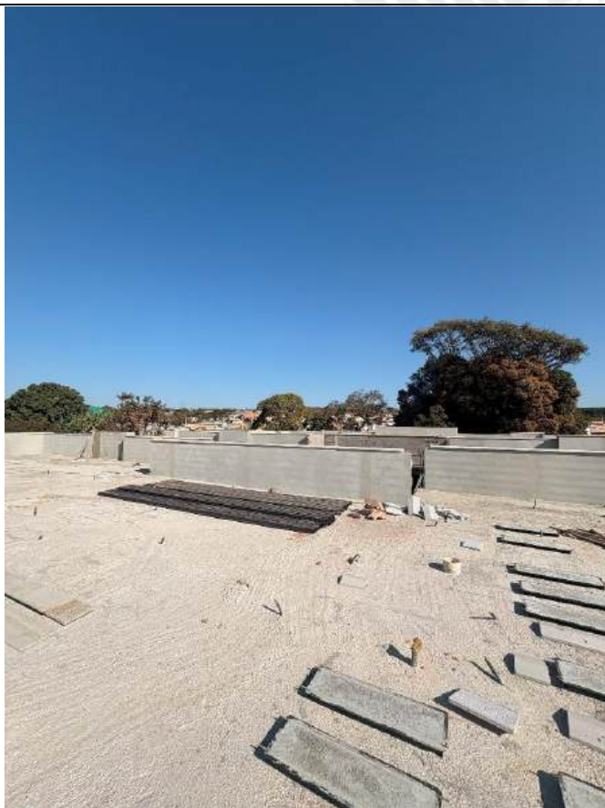
Foto 17 – Reboco e execução de pingadeiras
