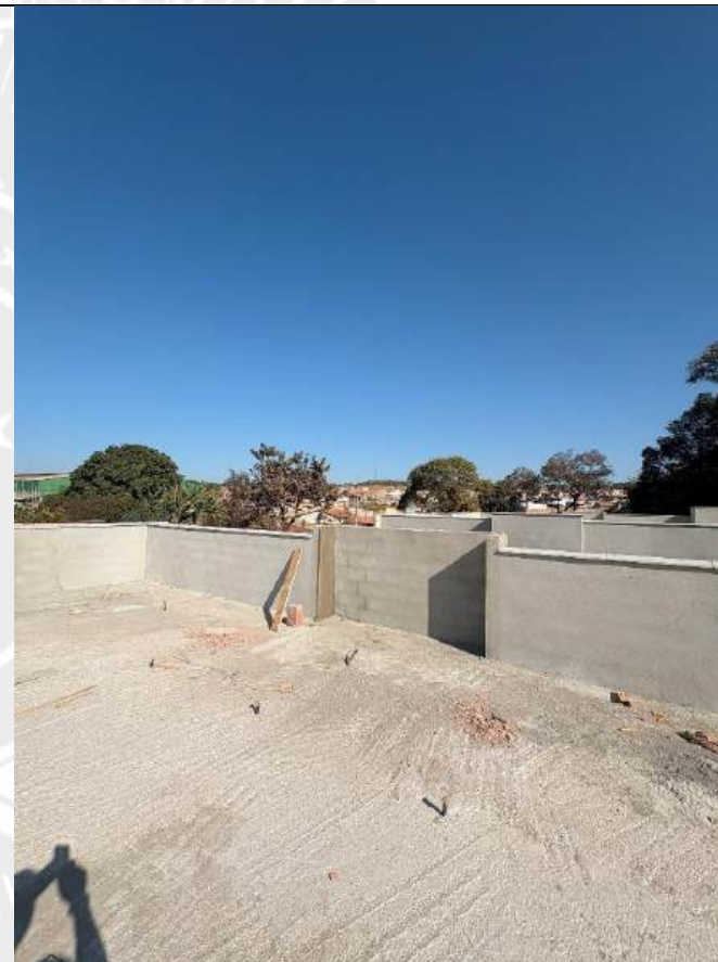
Foto 18 – Reboco e execução de pingadeiras
