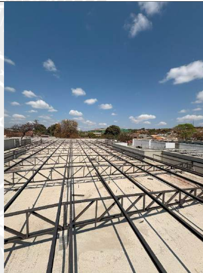
Foto 60 – Execução de estrutura do telhado
