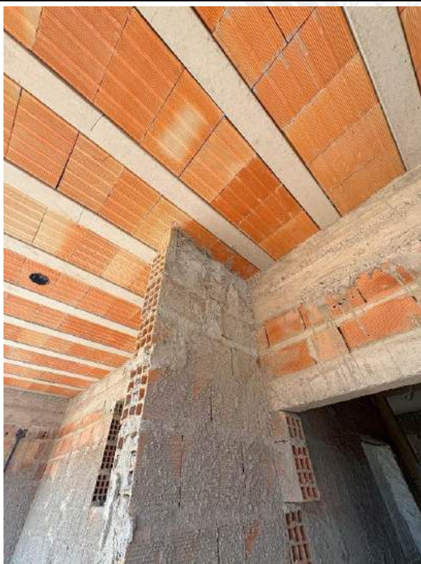
Foto 65 – Encunhamento de alvenaria
