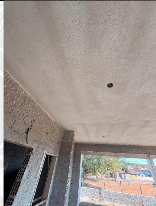
Foto 44 – Encunhamento de alvenaria
