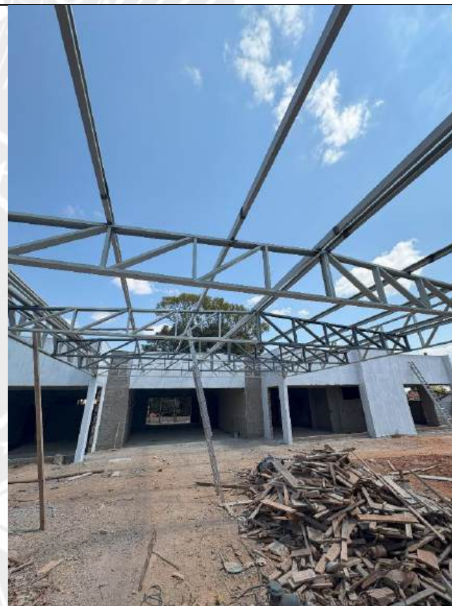
Foto 32 – Execução estrutura telhado
