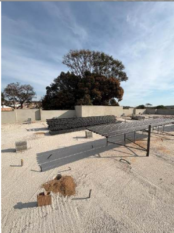
Foto 29 – Execução estrutura telhado
