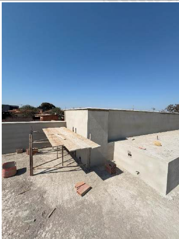
Foto 21 – Reboco e execução de pingadeiras
