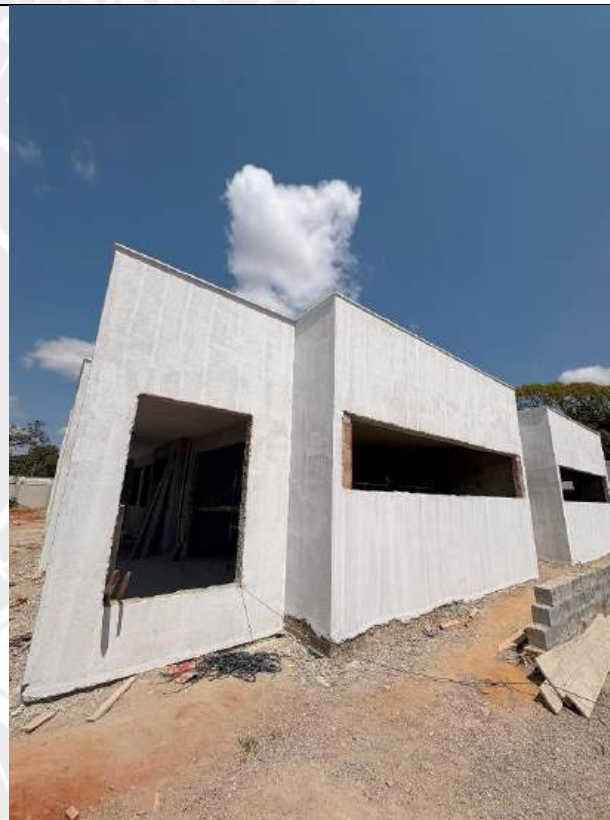
Foto 66 – Preparação, lixamento e aplicação de selador em alvenaria
