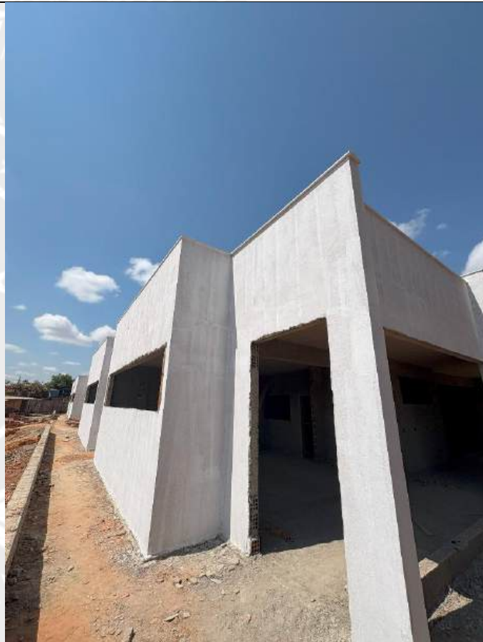
Foto 40 – Preparação de alvenaria e aplicação de selador
