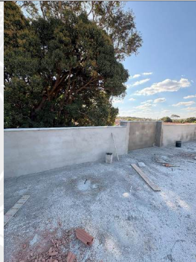
Foto 6 - Reboco e execução de pingadeiras
