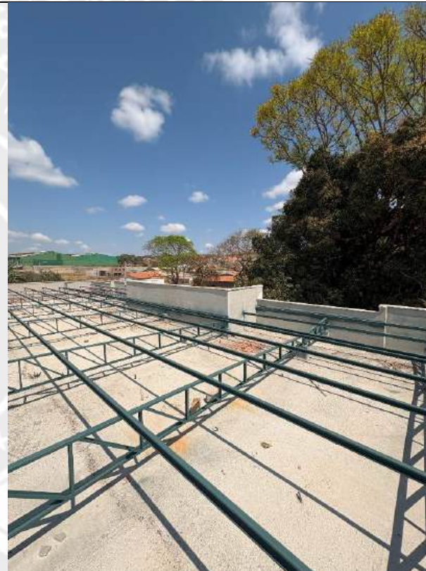
Foto 54 – Execução de estrutura do telhado
