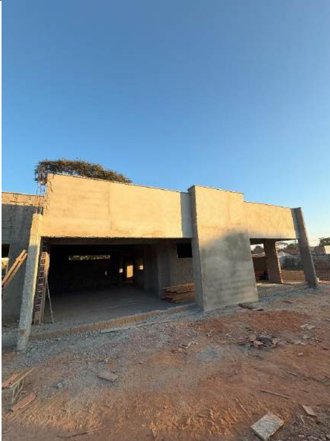
Foto 15 - Reboco e execução de pingadeiras
