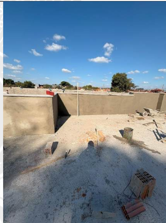
Foto 10 – Reboco e execução de pingadeiras
