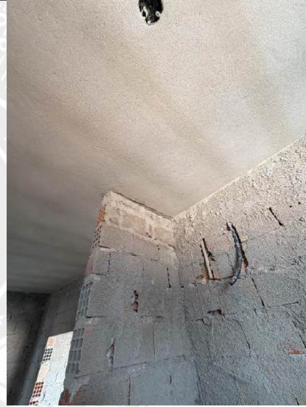
Foto 48 – Encunhamento de alvenaria
