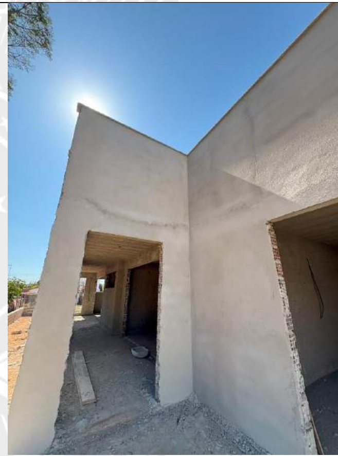
Foto 24 - Reboco e execução de pingadeiras
