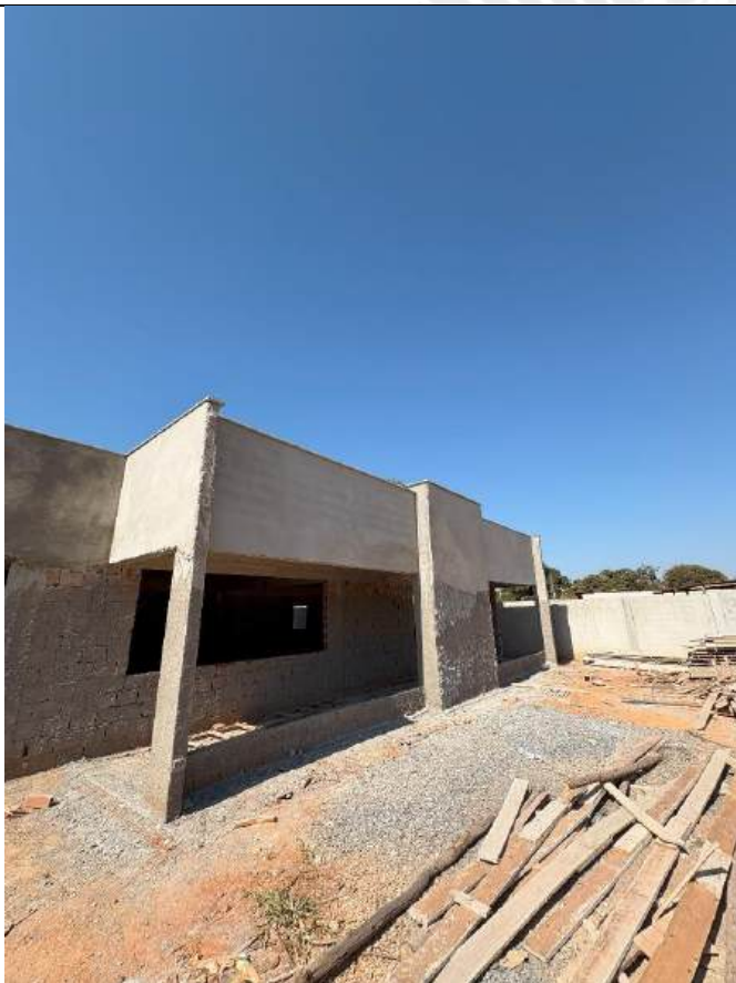
Foto 23 - Reboco e execução de pingadeiras
