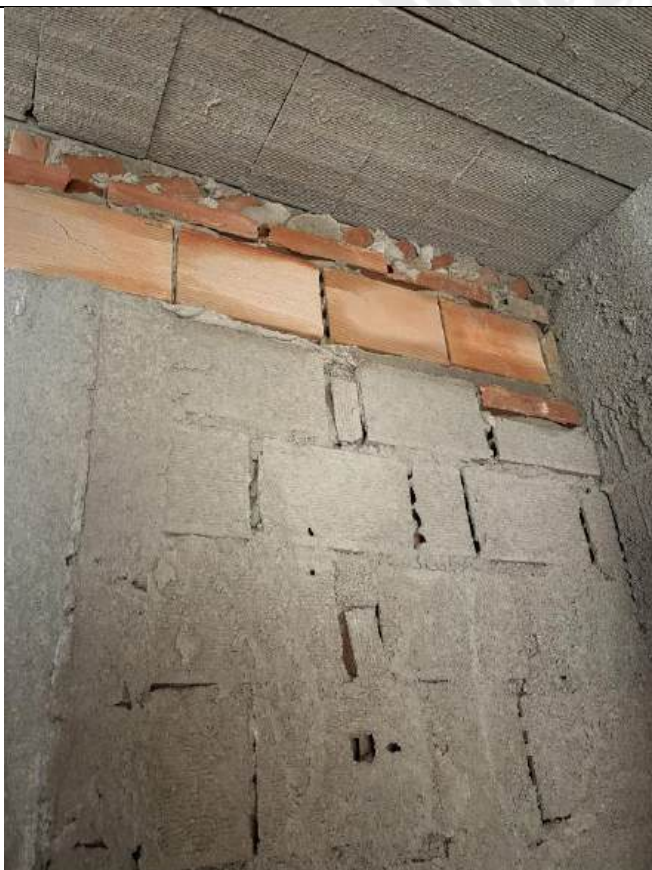
Foto 31 – Encunhamento de alvenaria
