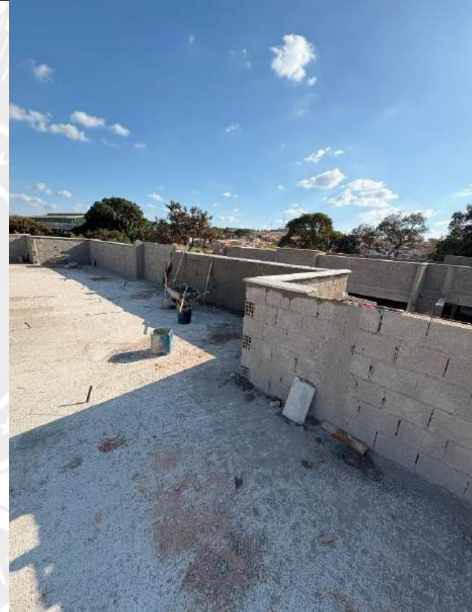
Foto 12 – Reboco e execução de pingadeiras
