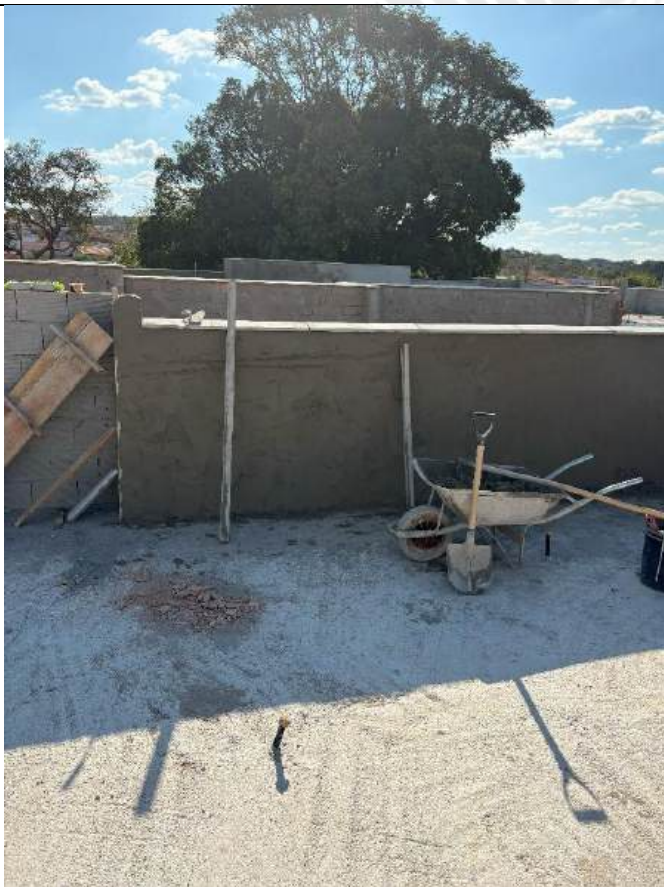
Foto 13 – Reboco e execução de pingadeiras
