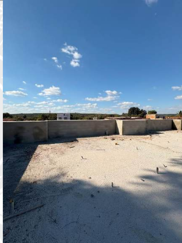
Foto 8 - Reboco e execução de pingadeiras
