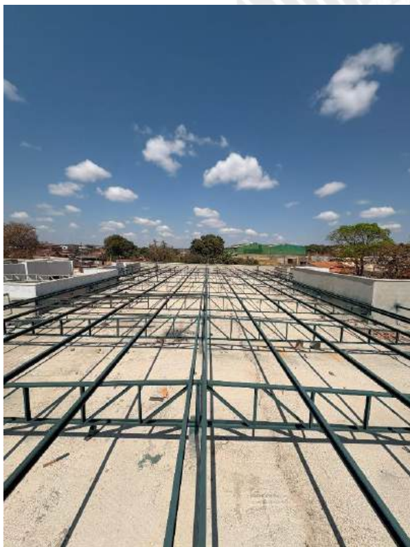
Foto 53 – Execução de estrutura do telhado
