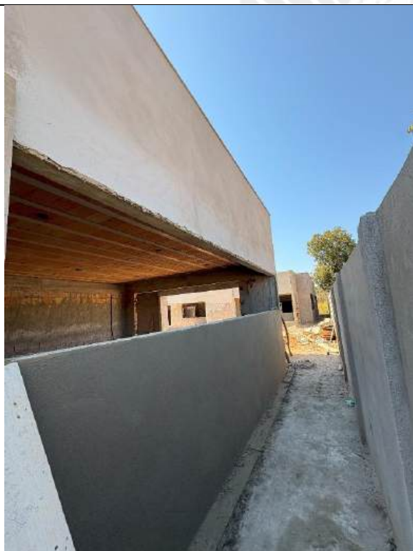
Foto 27 – Reboco e execução de pingadeiras
