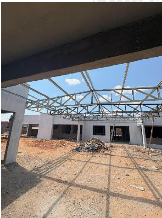
Foto 35 - Execução estrutura telhado
