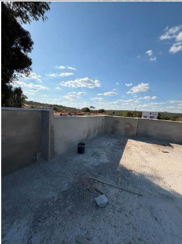
Foto 7 - Reboco e execução de pingadeiras
