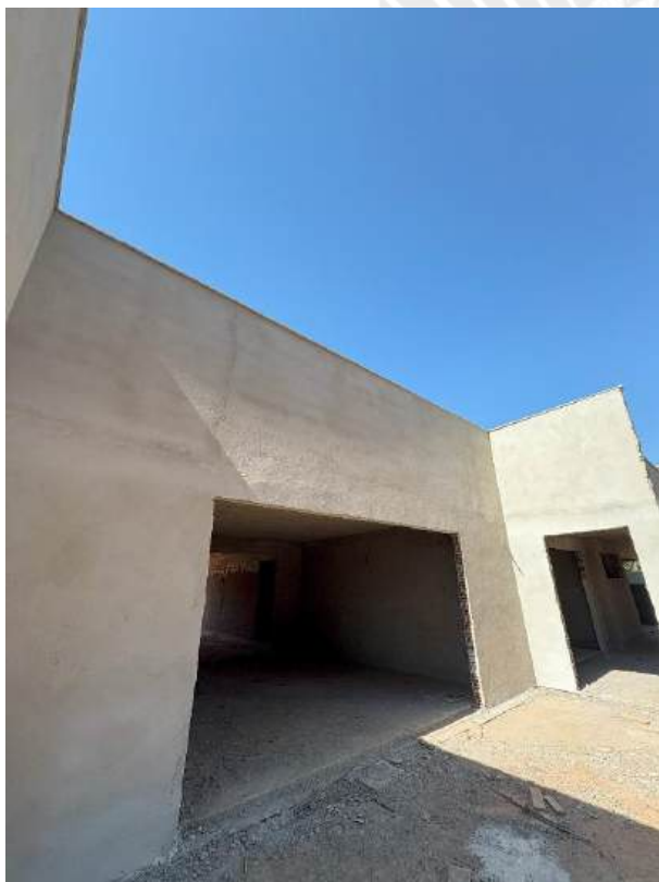
Foto 25 – Reboco e execução de pingadeiras
