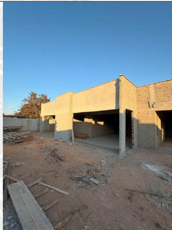
Foto 14 – Reboco e execução de pingadeiras
