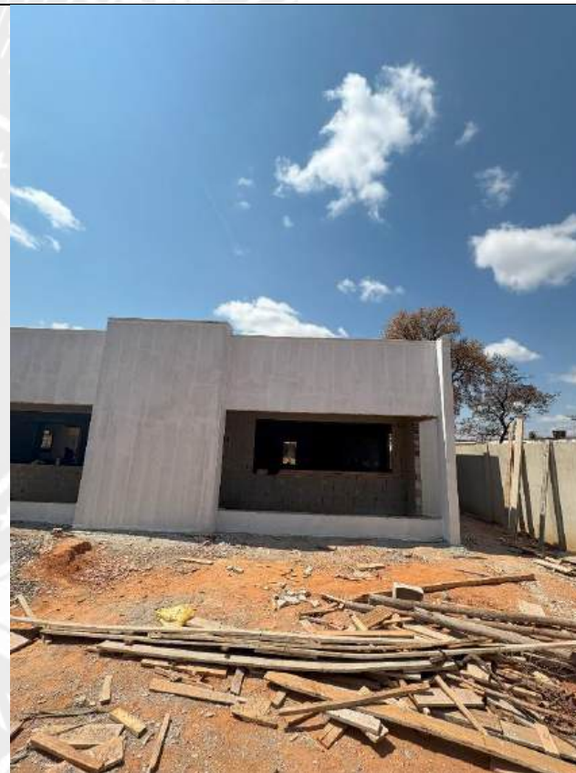
Foto 64 – Preparação, lixamento e aplicação de selador em alvenaria
