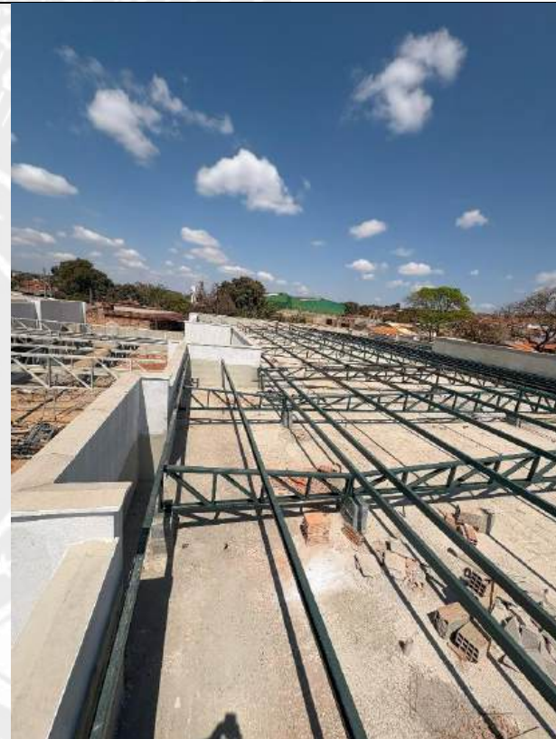
Foto 52 - Execução de estrutura do telhado
