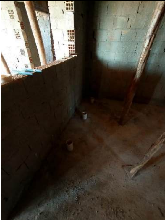
Foto 145 – Execução de redes de esgoto e concretagem de piso
