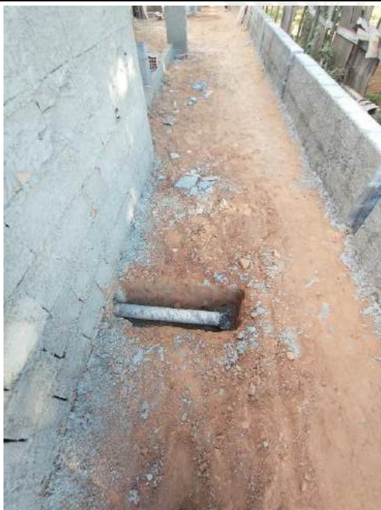
Foto 153 – Execução de redes de esgoto
