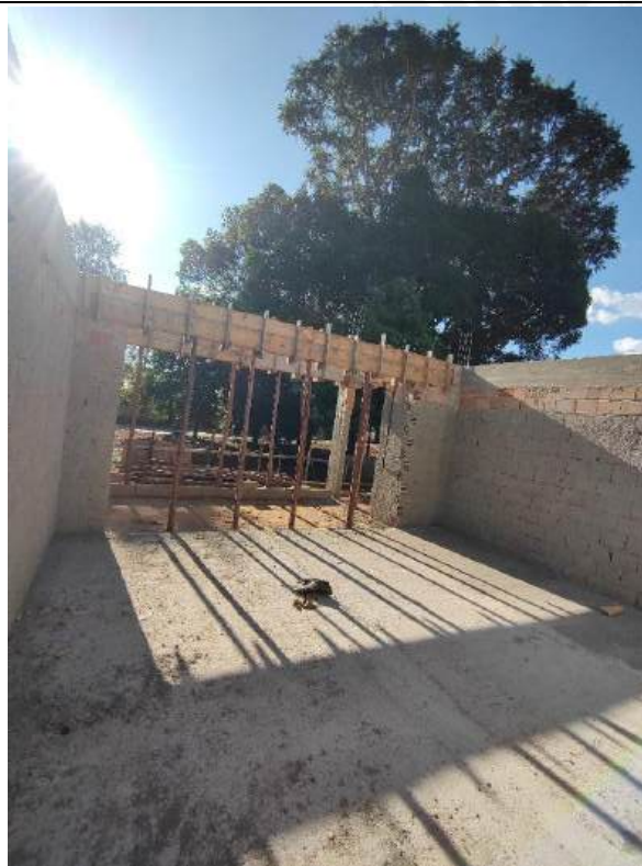
Foto 23 - Concretagem de piso
