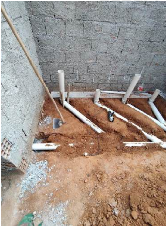
Foto 105 – Execução de redes de esgoto
