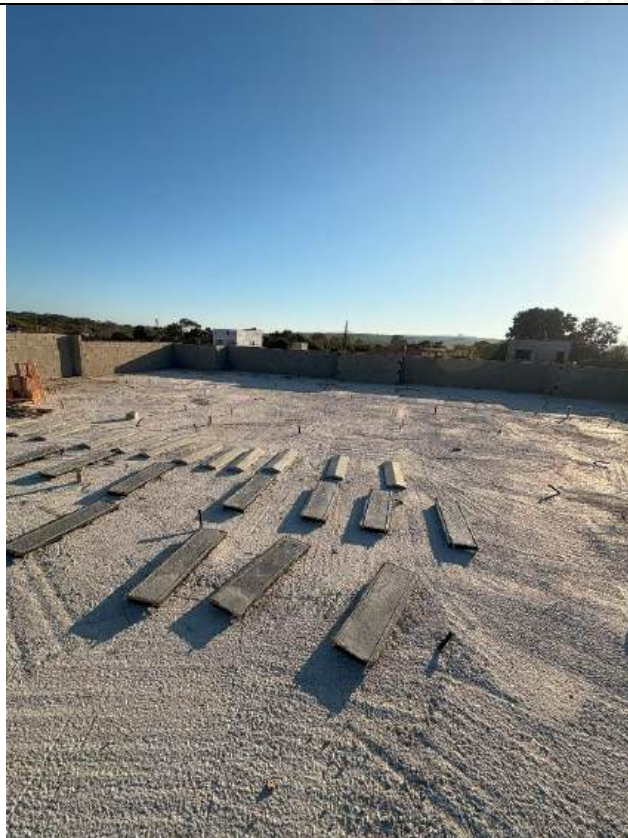
Foto 197 – Chapisco das platibandas
