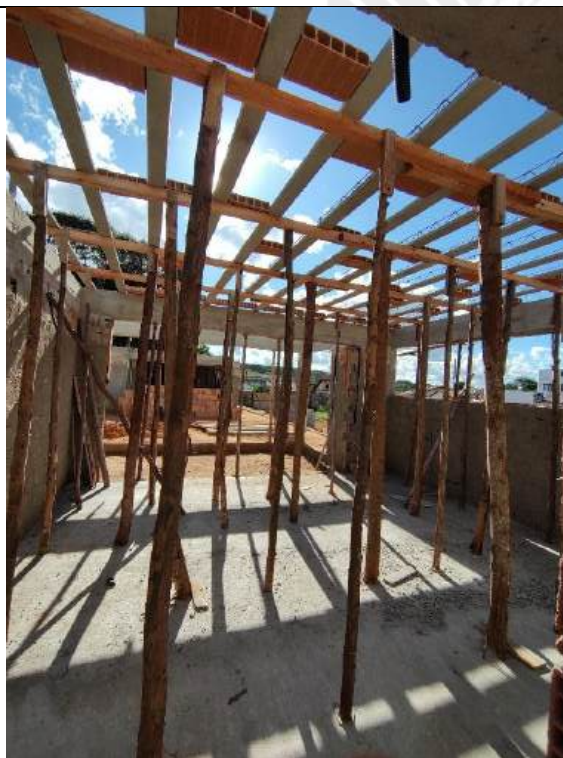
Foto 93 – Armação, forma e concretagem de vigas e cintas
