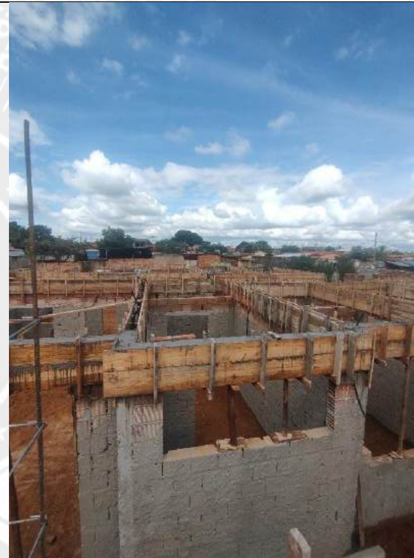
Foto 50 – Armação, forma e concretagem de cintas e vigas
