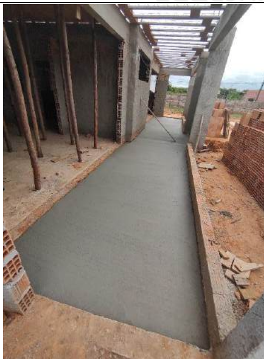
Foto 111 – Concretagem de piso
