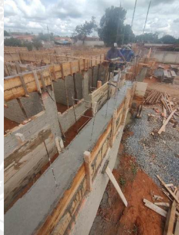
Foto 48 – Armação, forma e concretagem de cintas e vigas
