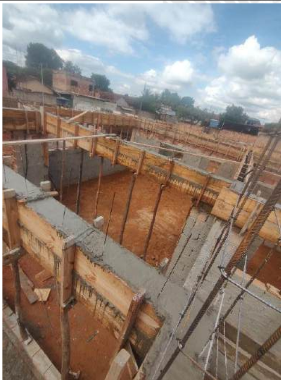
Foto 45 - Armação, forma e concretagem de cintas e vigas
