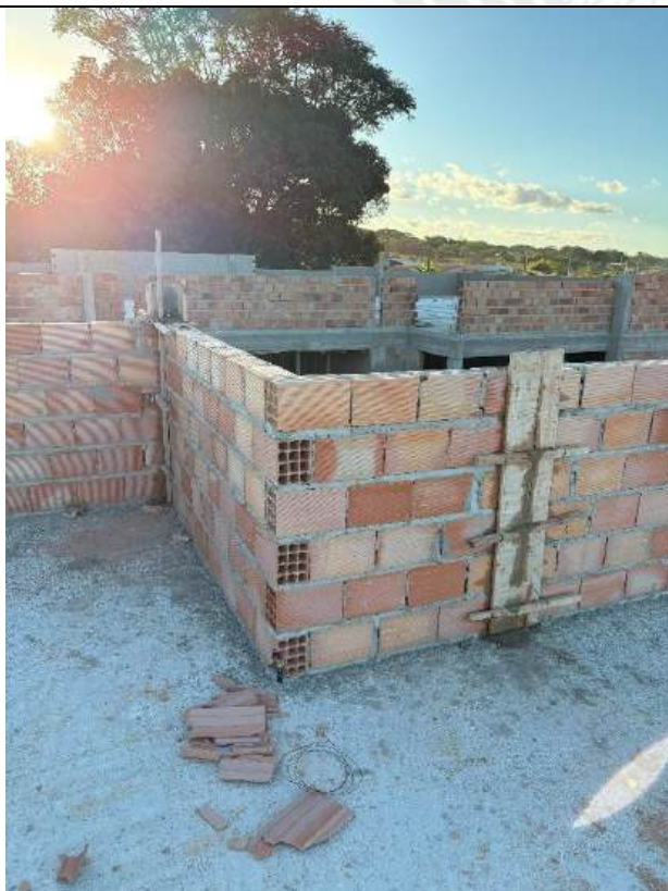
Foto 179 – Forma e concretagem de pilares das platibandas
