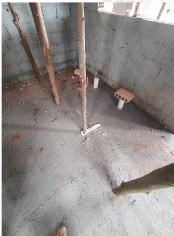
Foto 113 – Execução de redes de esgoto e concretagem de piso
