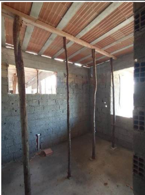
Foto 131 – Execução de redes de esgoto e concretagem de piso
