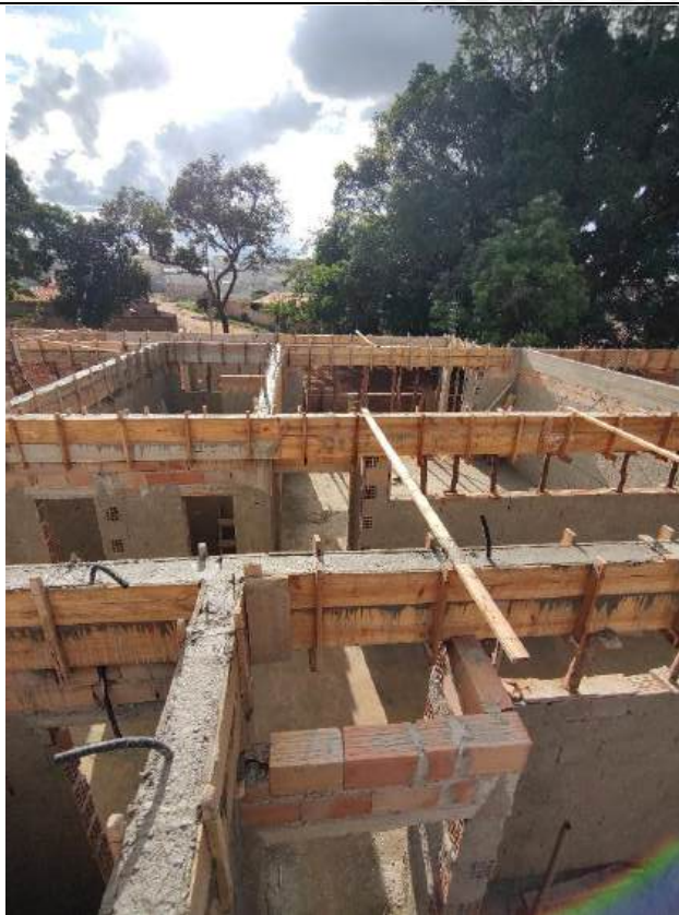
Foto 3 - Armação, forma e concretagem de cintas e vigas
