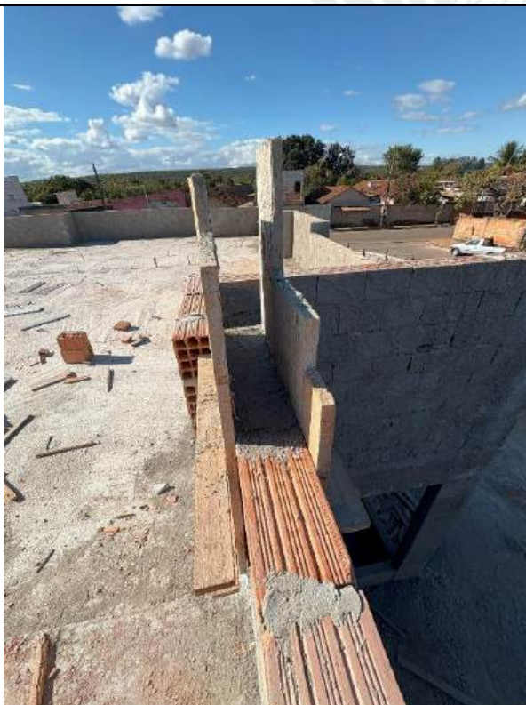
Foto 199 – Forma e concretagem de pilares das platibandas
