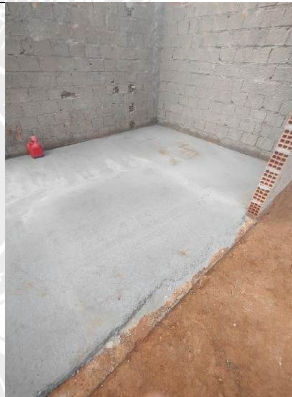
Foto 62 – Concretagem de piso
