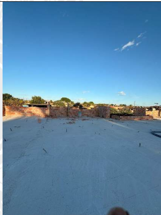
Foto 174 – Execução de alvenaria das platibandas
