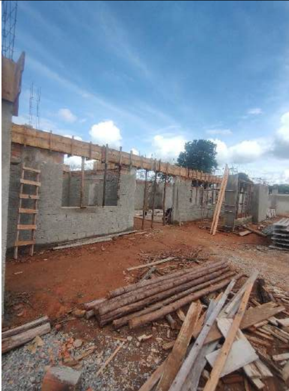
Foto 59 – Armação, forma e concretagem de cintas e vigas
