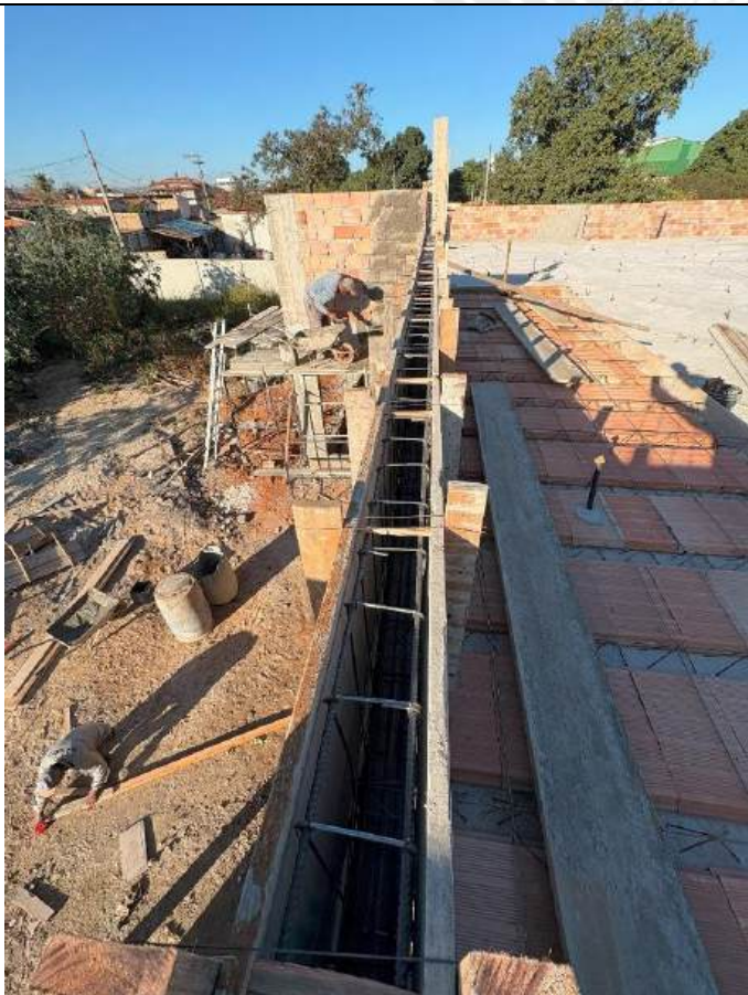
Foto 185 – Forma e concretagem de viga
