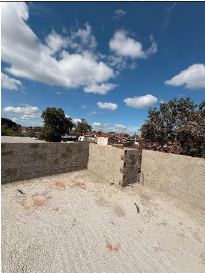
Foto 161 – Execução de alvenaria e chapisco das platibandas
