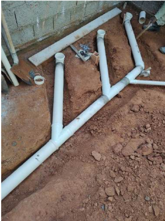
Foto 83 – Execução de redes de esgoto
