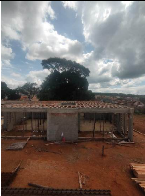
Foto 53 – Armação, forma e concretagem de cintas e vigas
