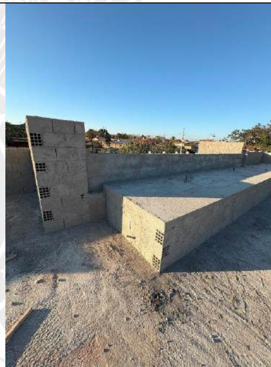
Foto 190 – Concretagem de viga
