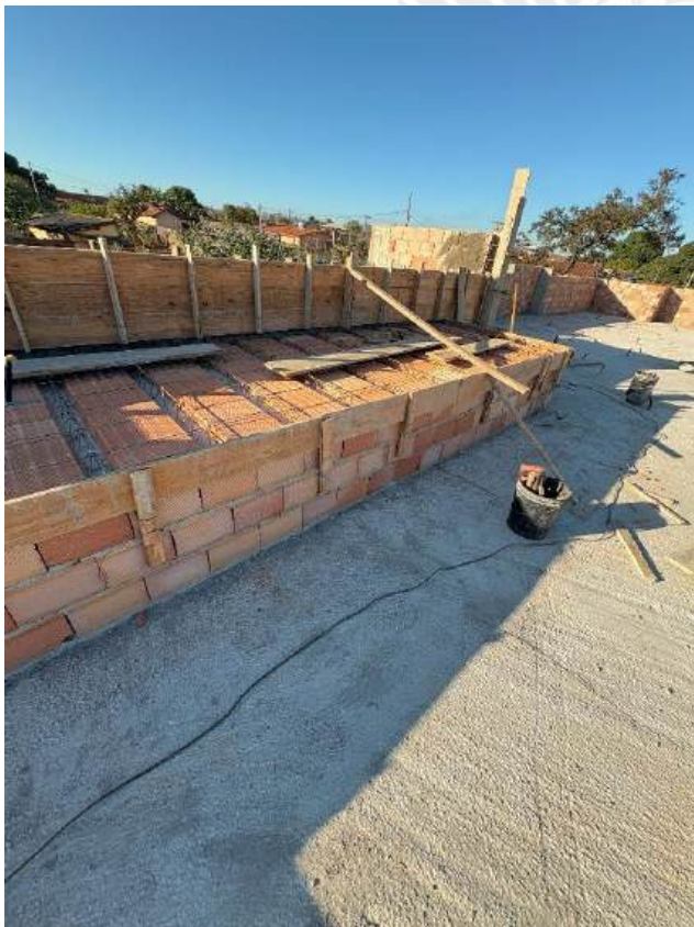
Foto 183 – Forma e concretagem de viga
