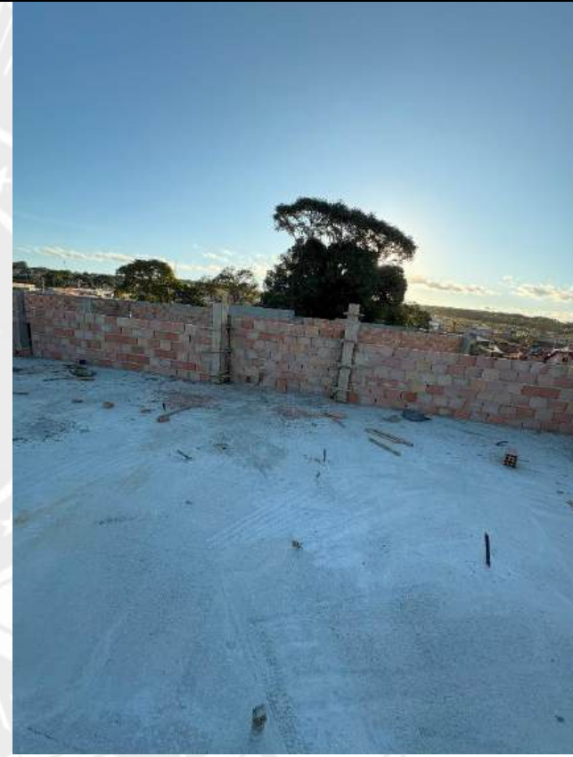
Foto 172 – Execução de alvenaria das platibandas
