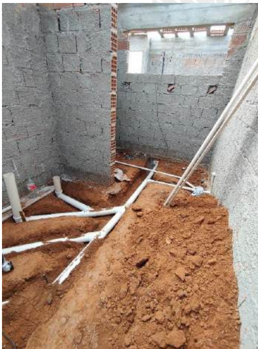
Foto 107 – Execução de redes de esgoto
