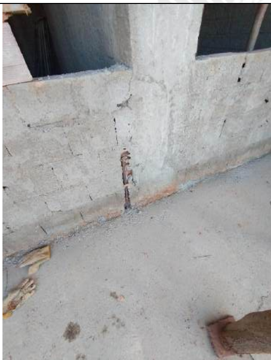
Foto 141 – Execução de redes de dreno de ar condicionado e concretagem de piso
