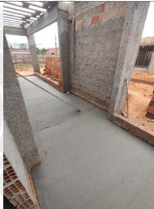
Foto 112 – Concretagem de piso
