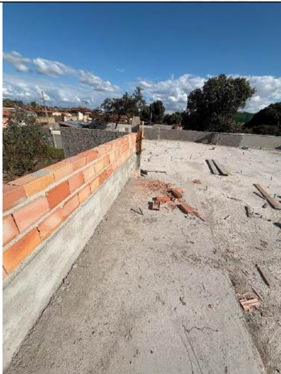
Foto 201 – Execução de alvenaria e chapisco das platibandas
