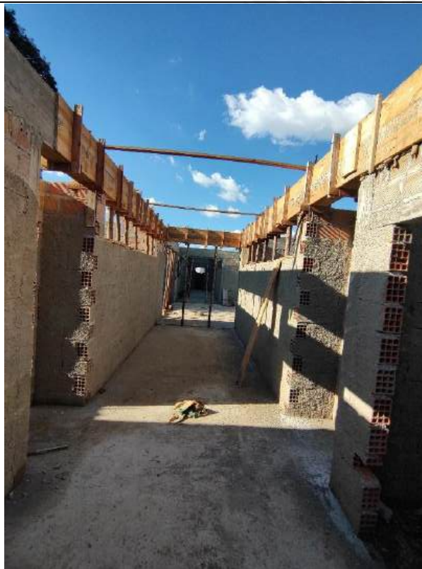
Foto 25 – Concretagem de piso
