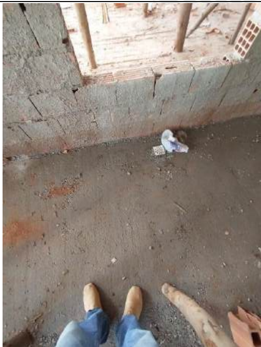
Foto 135 – Execução de redes de esgoto e concretagem de piso
