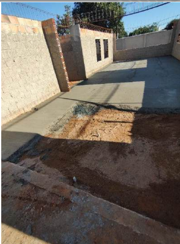
Foto 39 – Concretagem de piso
