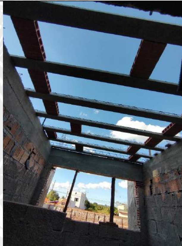
Foto 8 – Armadura, forma e concretagem de cintas e vigas
