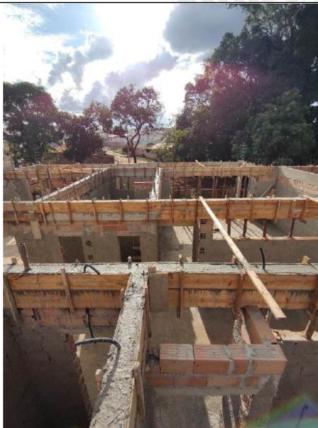
Foto 1 – Armação, forma e concretagem de cintas e vigas
