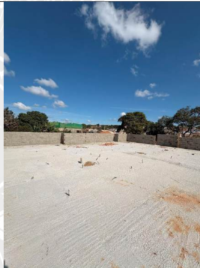
Foto 160 – Execução de alvenaria e chapisco das platibandas
