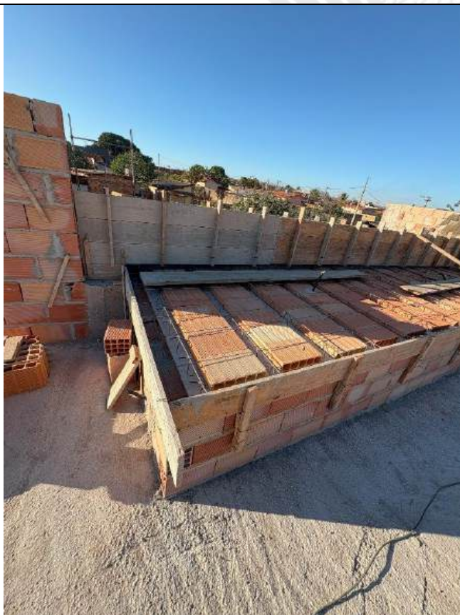
Foto 181 – Forma e concretagem de viga
