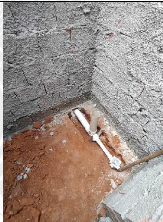
Foto 108 – Execução de redes de esgoto
