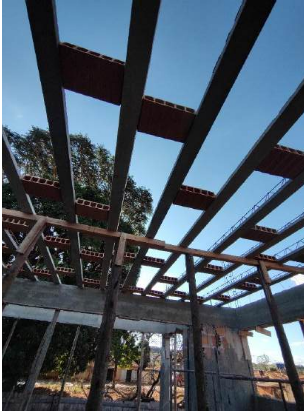
Foto 5 - Armação, forma e concretagem de cintas e vigas
