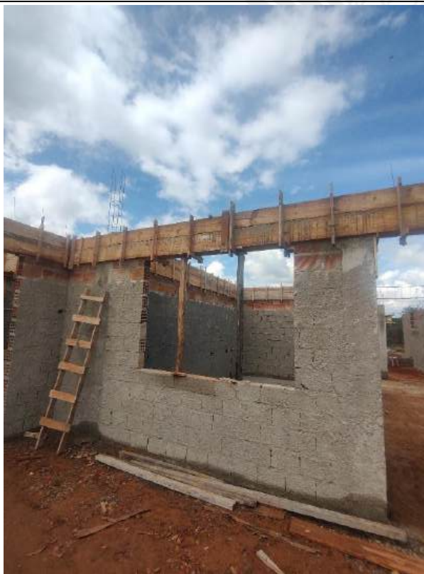
Foto 61 – Armação, forma e concretagem de cintas e vigas
