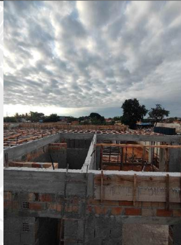
Foto 70 – Armação, forma e concretagem de cintas e vigas
