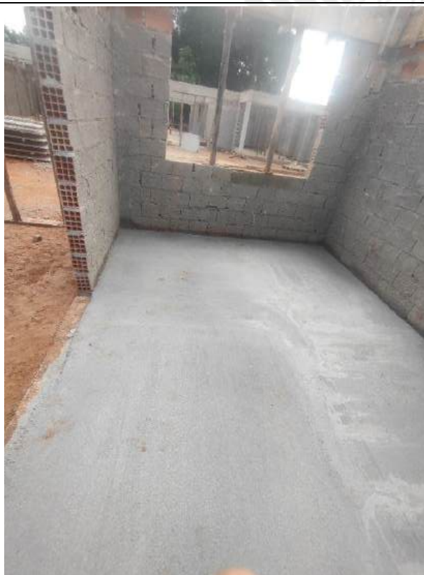
Foto 63 – Concretagem de piso
