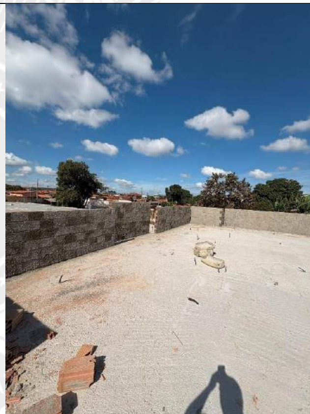
Foto 158 – Execução de alvenaria e chapisco das platibandas
