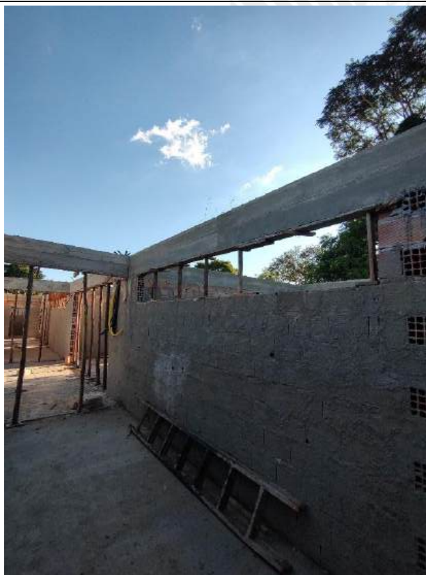
Foto 11 – Armação, forma e concretagem de cintas e vigas
