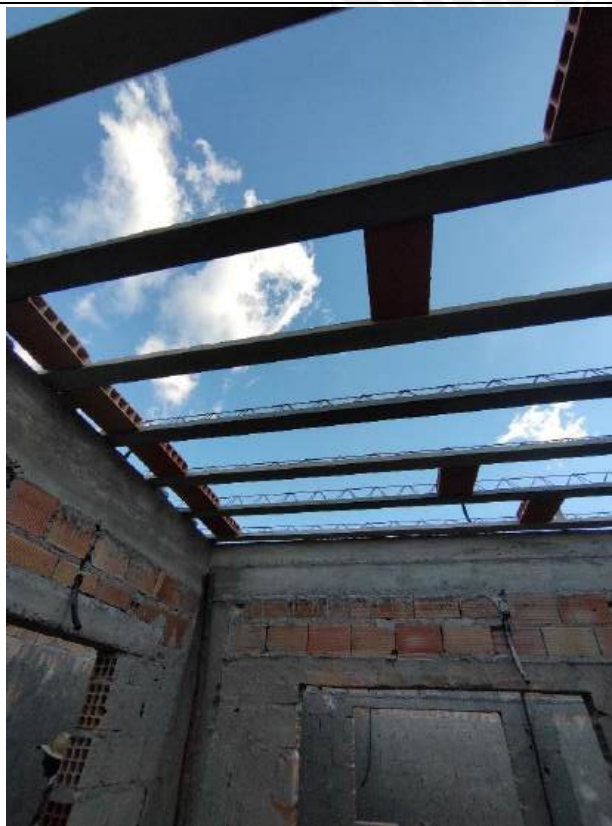
Foto 7 - Armadura, forma e concretagem de cintas e vigas
