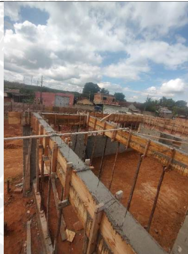
Foto 44 – Armação, forma e concretagem de cintas e vigas
