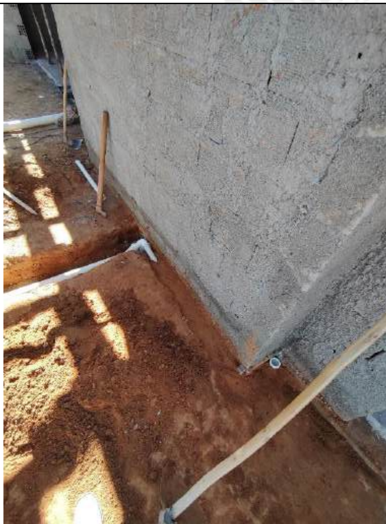
Foto 121 – Execução de redes de esgoto
