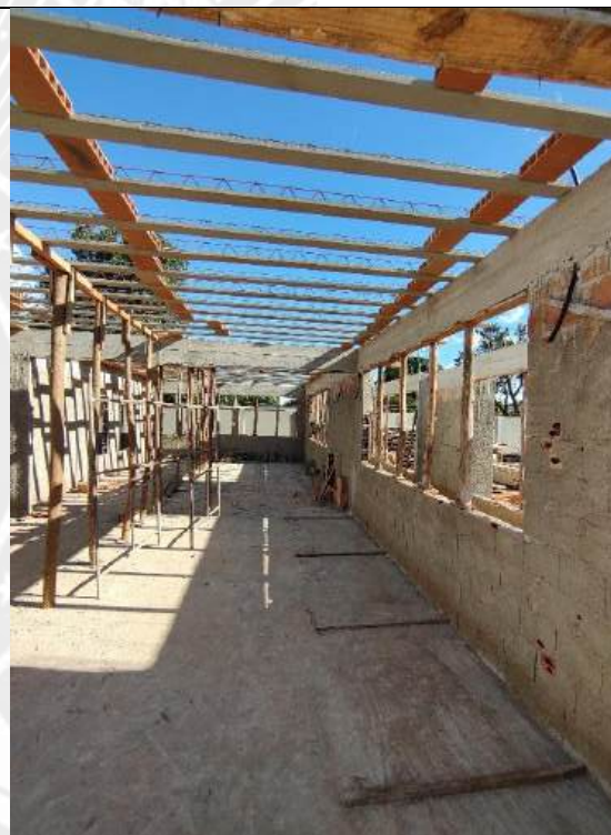
Foto 96 – Armação, forma e concretagem de vigas e cintas
