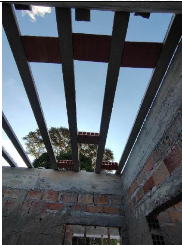
Foto 9 – Armação, forma e concretagem de cintas e vigas
