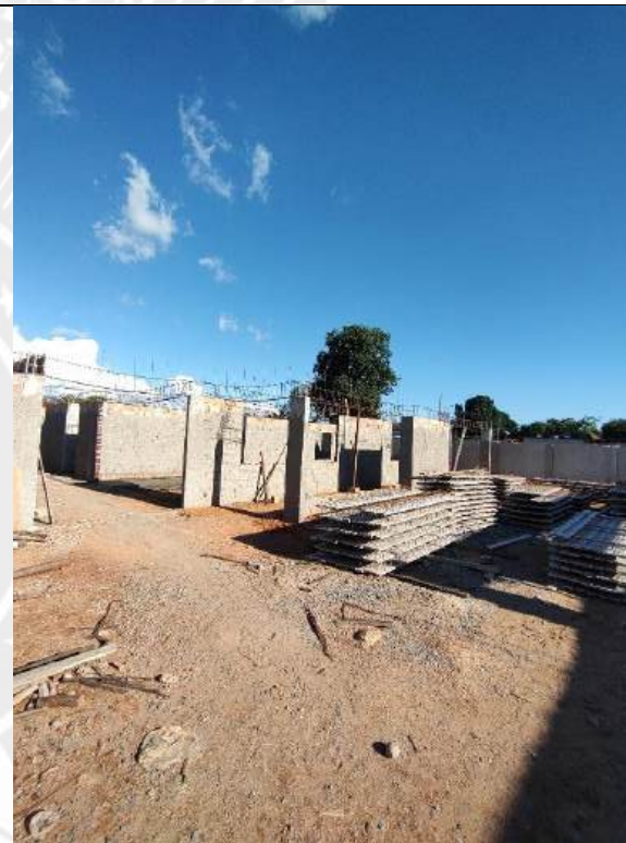
Foto 34 – Armação, forma e concretagem de cintas e vigas
