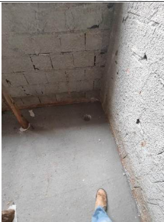
Foto 115 – Execução de redes de esgoto e concretagem de piso
