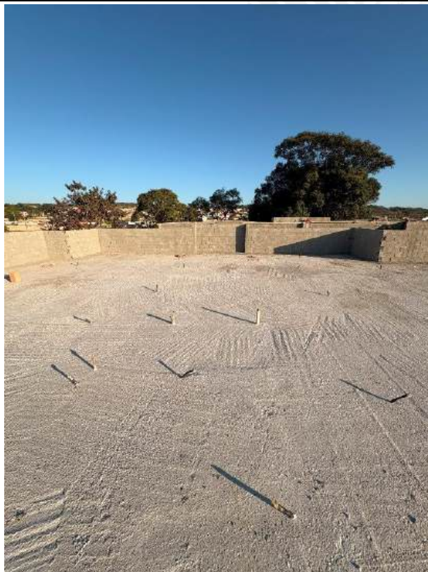
Foto 195 – Chapisco das platibandas
