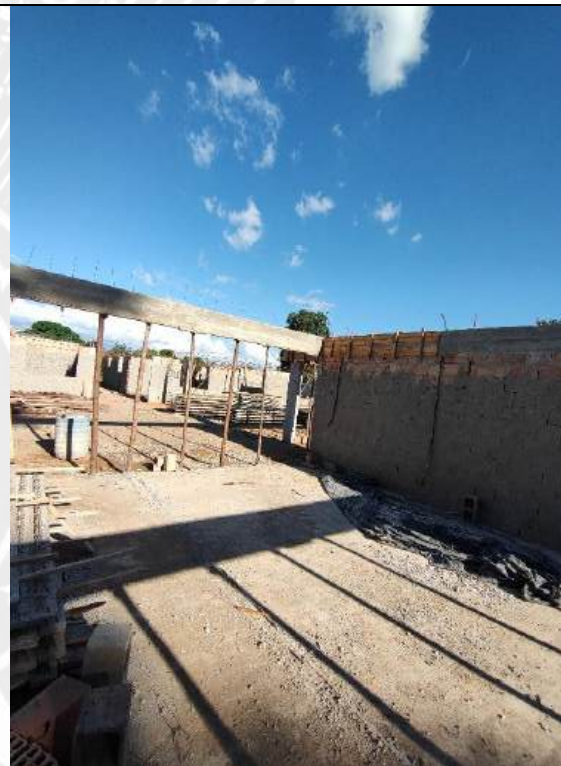
Foto 18 – Concretagem de piso
