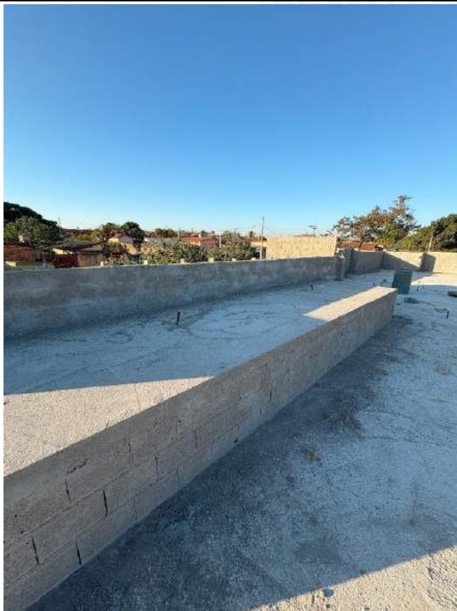
Foto 191 – Chapisco das vigas e platibandas
