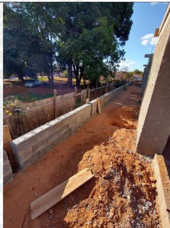
Foto 156 – Execução de mureta para assentamento de gradil
