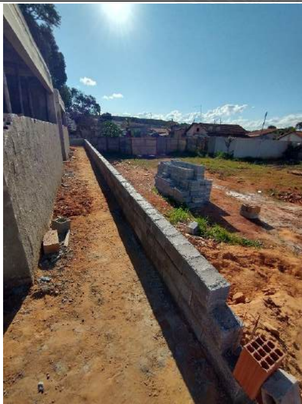
Foto 147 – Execução de mureta para assentamento de gradil
