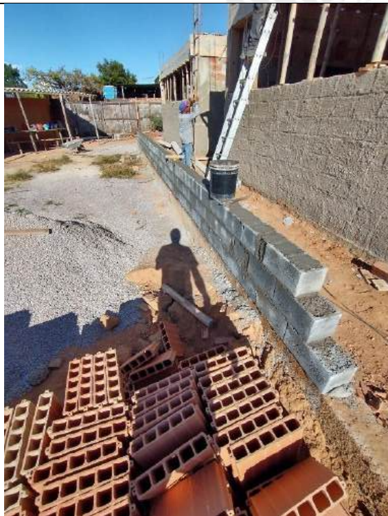
Foto 149 – Execução de mureta para assentamento de gradil
