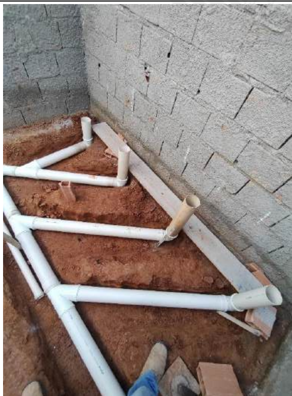
Foto 119 – Execução de redes de esgoto
