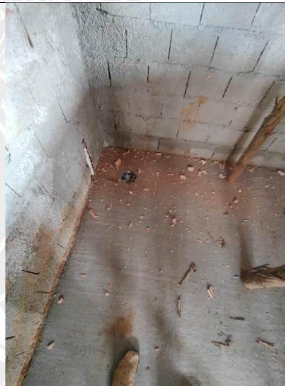
Foto 114 – Execução de redes de esgoto e concretagem de piso
