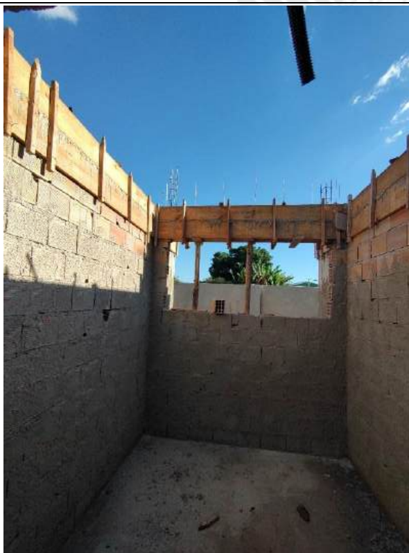
Foto 27 – Concretagem de piso
