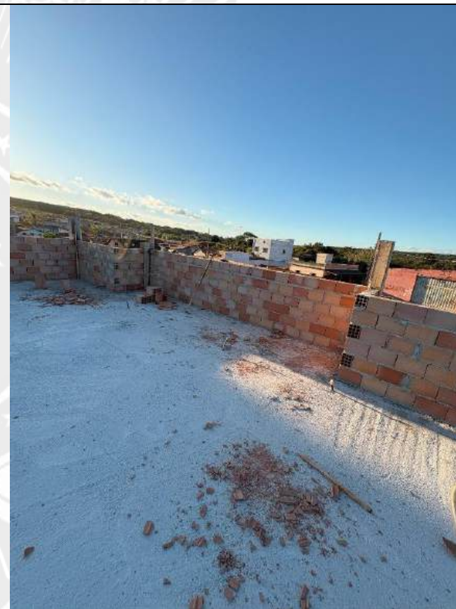
Foto 170 – Execução de alvenaria das platibandas
