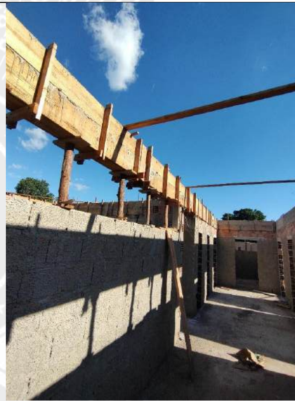
Foto 22 – Concretagem de piso
