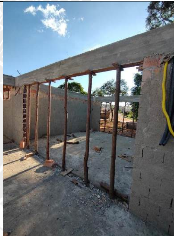
Foto 16 – Concretagem de piso
