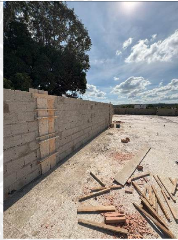
Foto 166 – Forma e concretagem de pilares das platibandas
