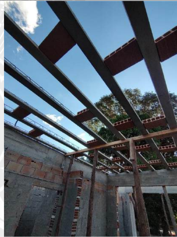
Foto 6 - Armação, forma e concretagem de cintas e vigas
