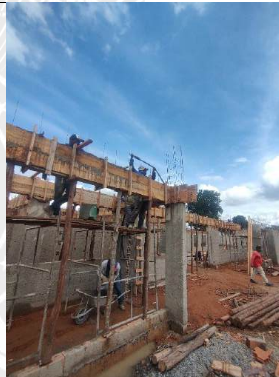
Foto 58 – Armação, forma e concretagem de cintas e vigas
