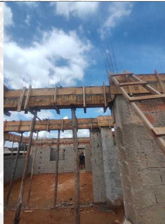
Foto 56 – Armação, forma e concretagem de cintas e vigas
