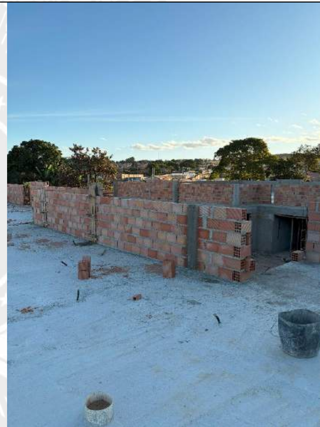
Foto 178 – Forma e concretagem de pilares das platibandas
