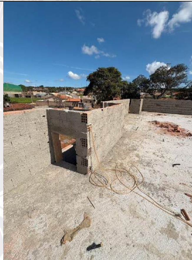
Foto 162 – Execução de alvenaria e chapisco das platibandas
