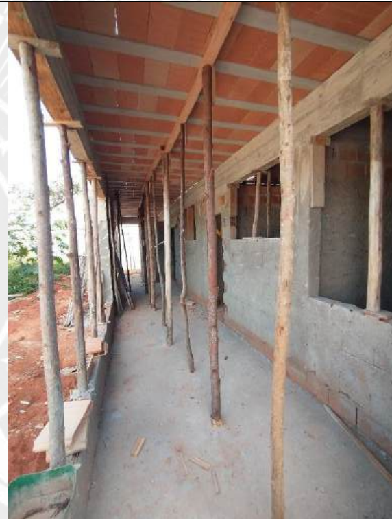
Foto 130 – Concretagem de piso
