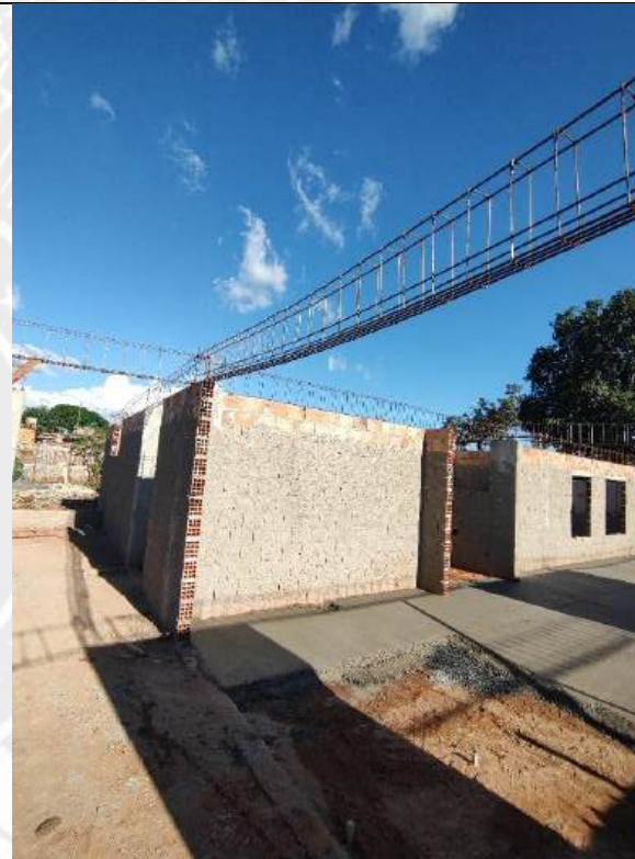
Foto 38 - Concretagem de piso
