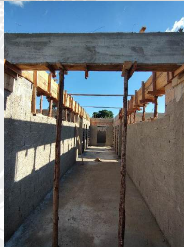
Foto 20 – Concretagem de piso
