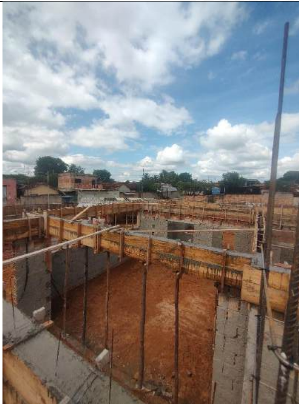
Foto 49 – Armação, forma e concretagem de cintas e vigas
