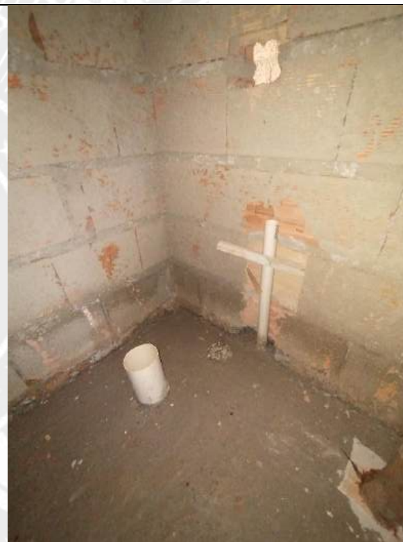
Foto 138 – Execução de redes de esgoto e concretagem de piso
