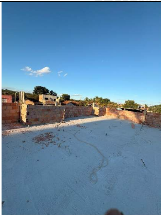
Foto 173 – Execução de alvenaria das platibandas
