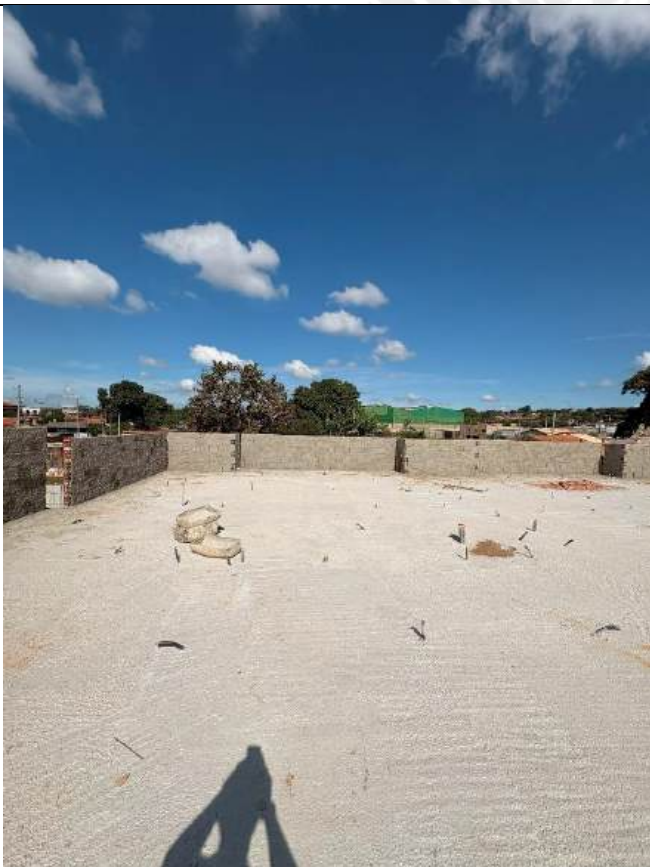
Foto 159 – Execução de alvenaria e chapisco das platibandas
