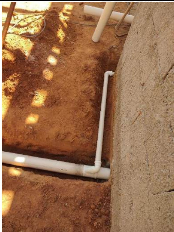
Foto 85 – Execução de redes de esgoto
