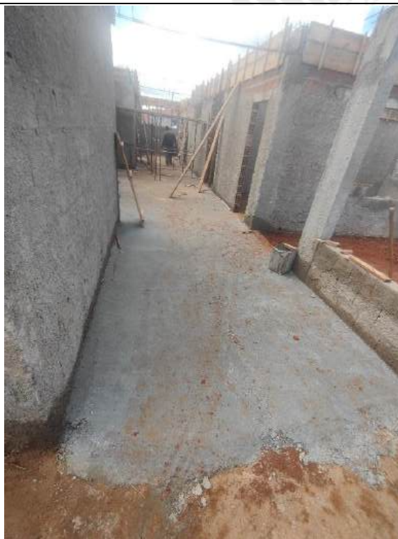
Foto 65 – Concretagem de piso
