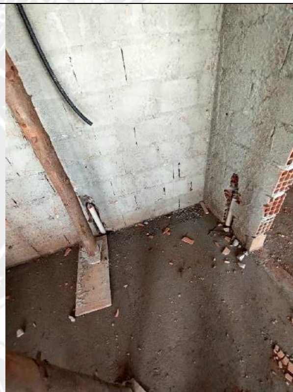
Foto 134 – Execução de redes de esgoto e concretagem de piso
