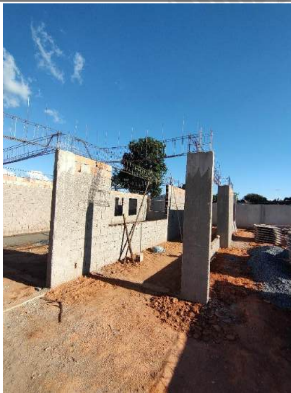
Foto 35 - Armação, forma e concretagem de cintas e vigas
