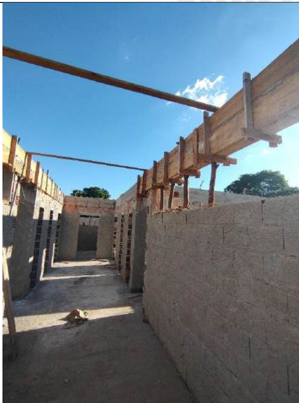
Foto 21 – Concretagem de piso
