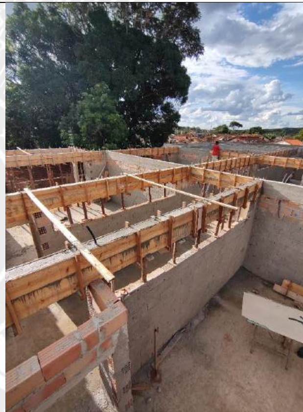
Foto 2 – Armação, forma e concretagem de cintas e vigas
