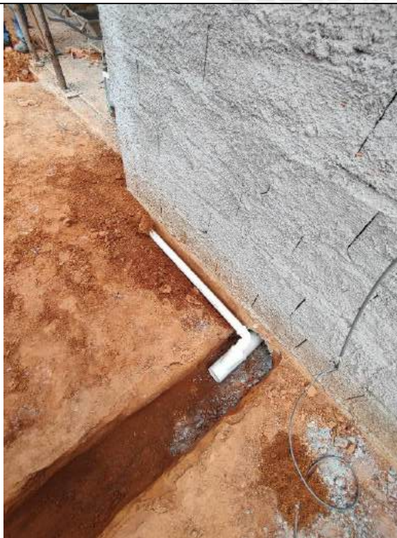
Foto 109 – Execução de redes de esgoto
