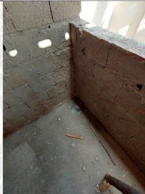
Foto 136 – Execução de redes de esgoto e concretagem de piso
