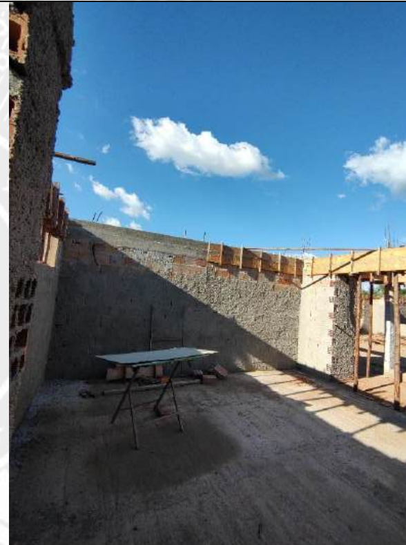
Foto 24 - Concretagem de piso
