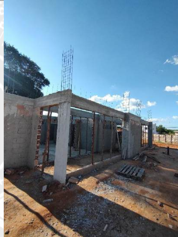
Foto 32 – Armação, forma e concretagem de cintas e vigas
