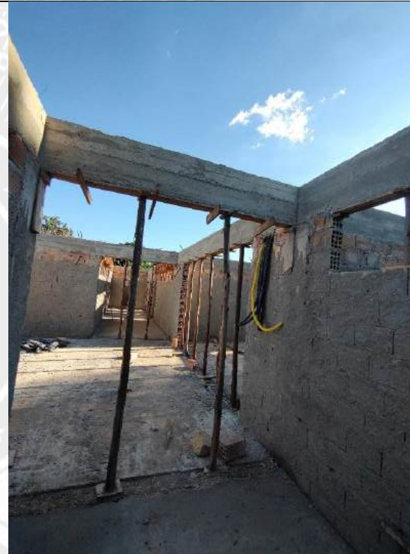
Foto 14 – Armação, forma e concretagem de cintas e vigas
