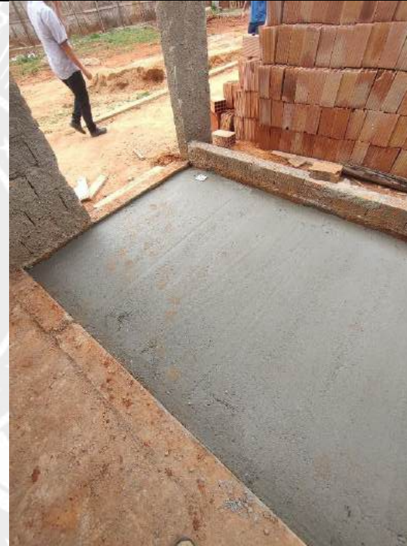
Foto 118 – Execução de redes de esgoto e concretagem de piso
