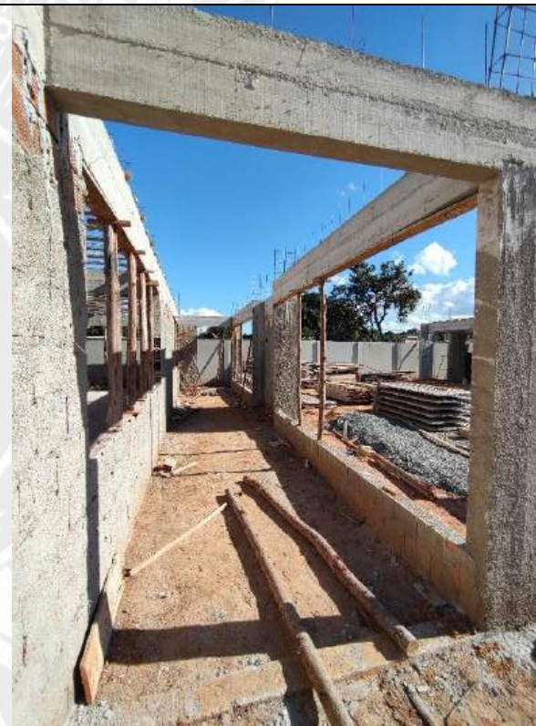
Foto 98 – Armação, forma e concretagem de vigas e cintas
