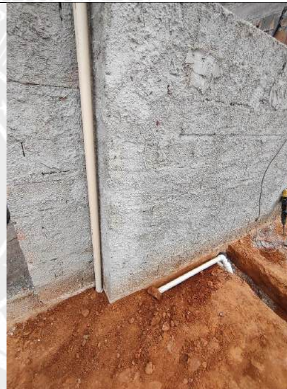
Foto 110 – Execução de redes de esgoto
