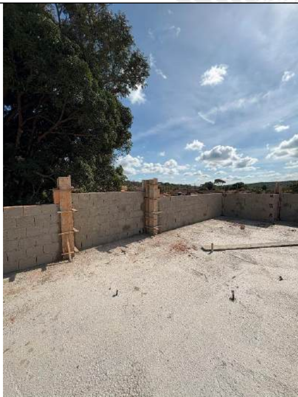
Foto 167 – Forma e concretagem de pilares das platibandas
