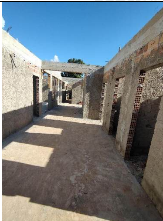
Foto 91 – Concretagem de piso
