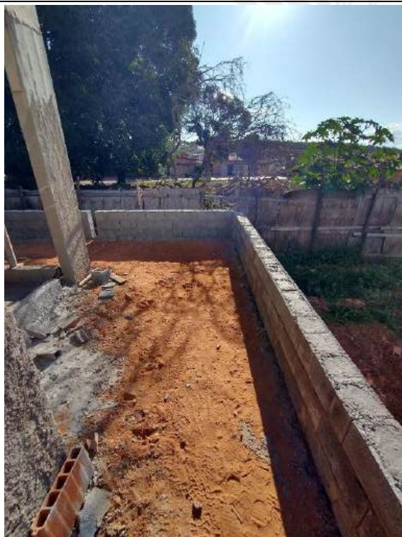
Foto 151 – Execução de mureta para assentamento de gradil
