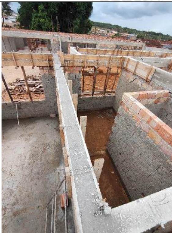
Foto 77 – Armação, forma e concretagem de cintas e vigas
