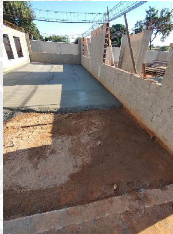
Foto 40 – Concretagem de piso
