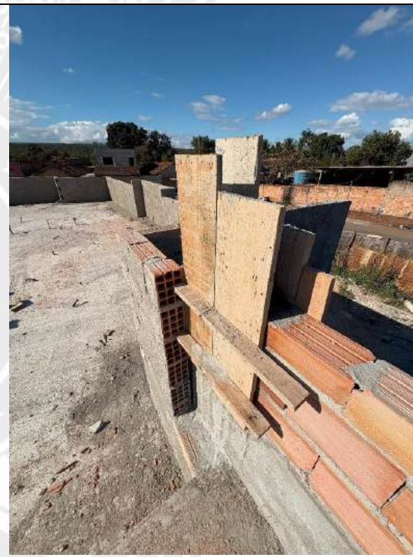
Foto 200 – Forma e concretagem de pilares das platibandas
