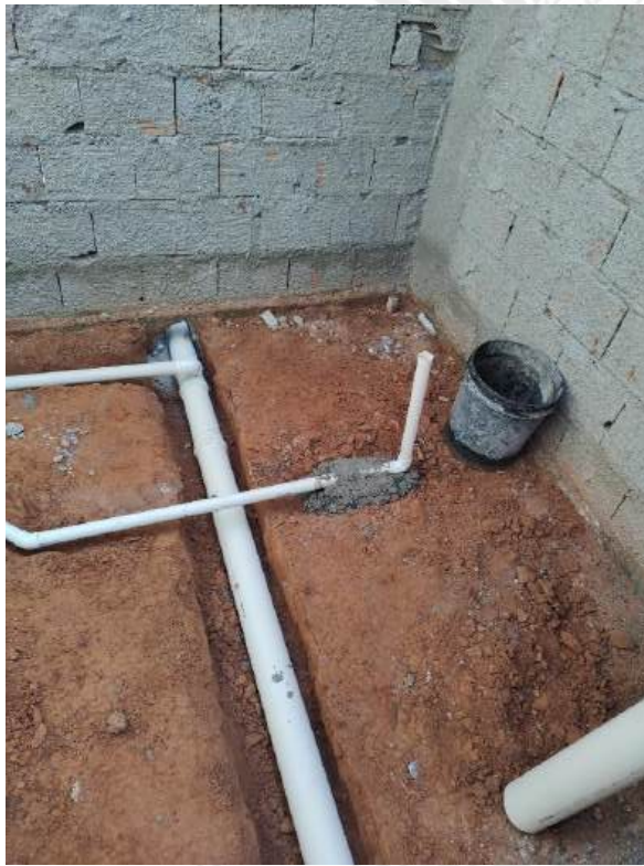
Foto 81 – Execução de redes de esgoto
