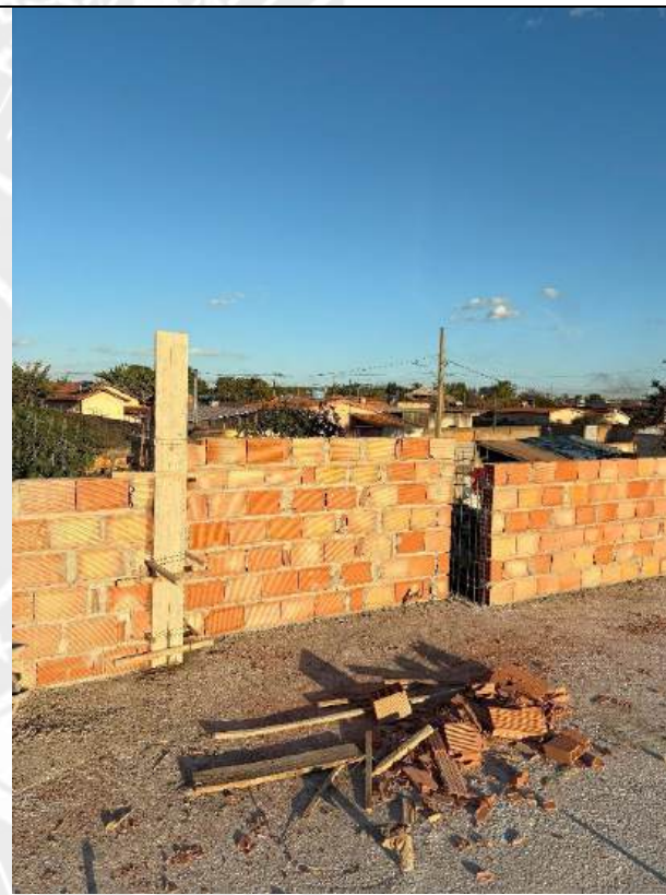
Foto 180 – Forma e concretagem de pilares das platibandas
