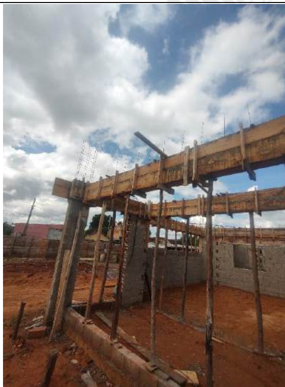
Foto 55 – Armação, forma e concretagem de cintas e vigas
