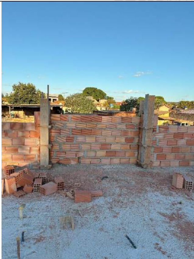
Foto 177 – Forma e concretagem de pilares das platibandas
