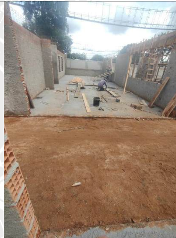
Foto 64 – Concretagem de piso
