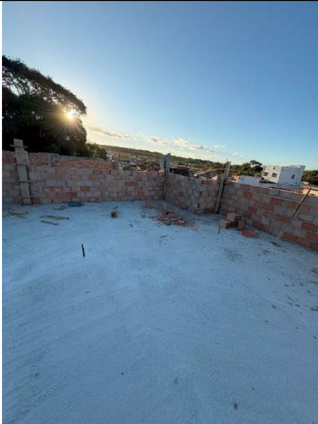
Foto 171 – Execução de alvenaria das platibandas
