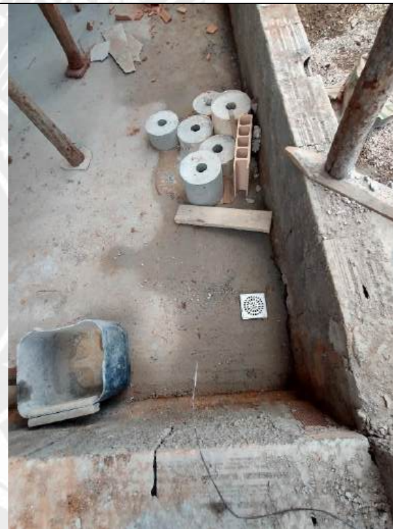
Foto 140 – Execução de redes de esgoto e concretagem de piso
