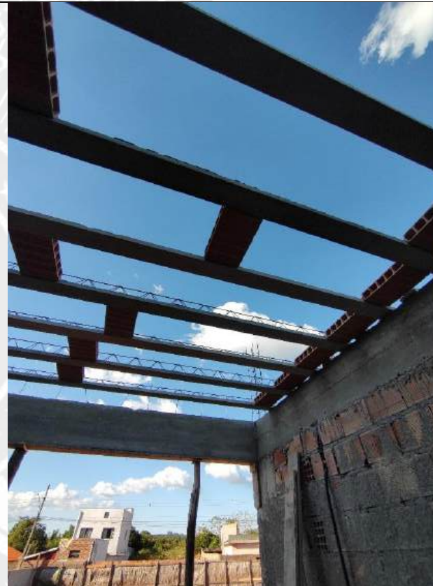
Foto 4 – Armação, forma e concretagem de cintas e vigas
