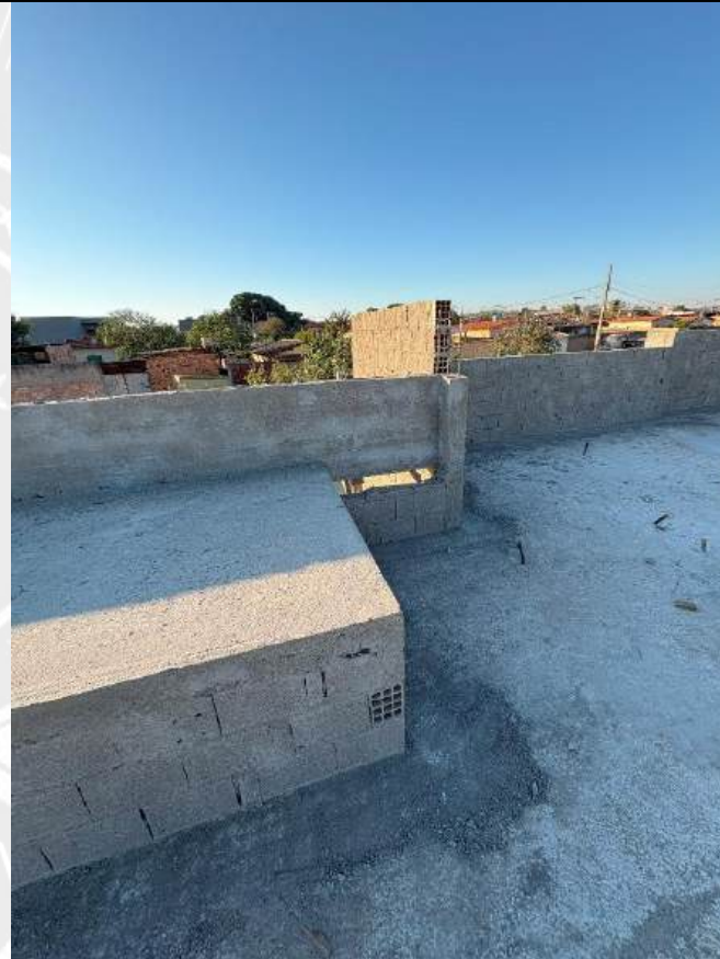
Foto 192 – Chapisco das vigas e platibandas
