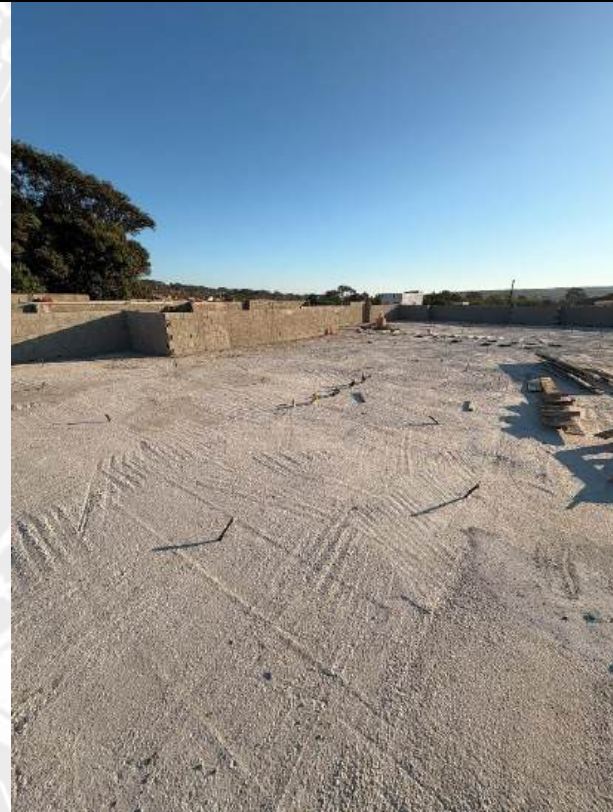
Foto 196 – Chapisco das platibandas
