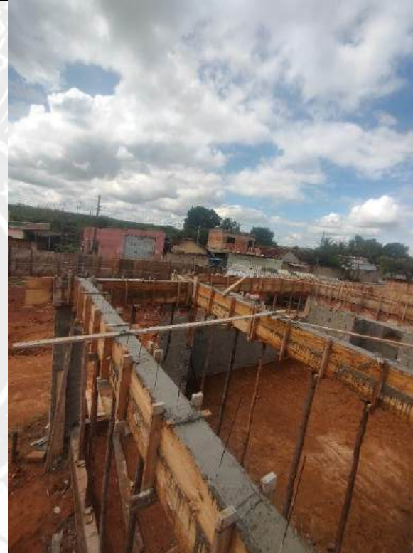
Foto 46 - Armação, forma e concretagem de cintas e vigas
