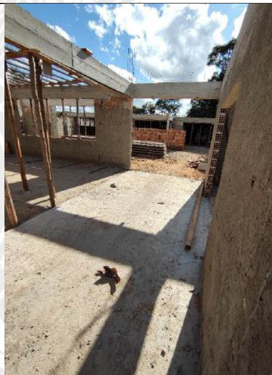
Foto 94 – Armação, forma e concretagem de vigas e cintas
