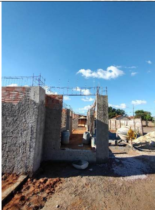
Foto 43 - Armação, forma e concretagem de cintas e vigas
