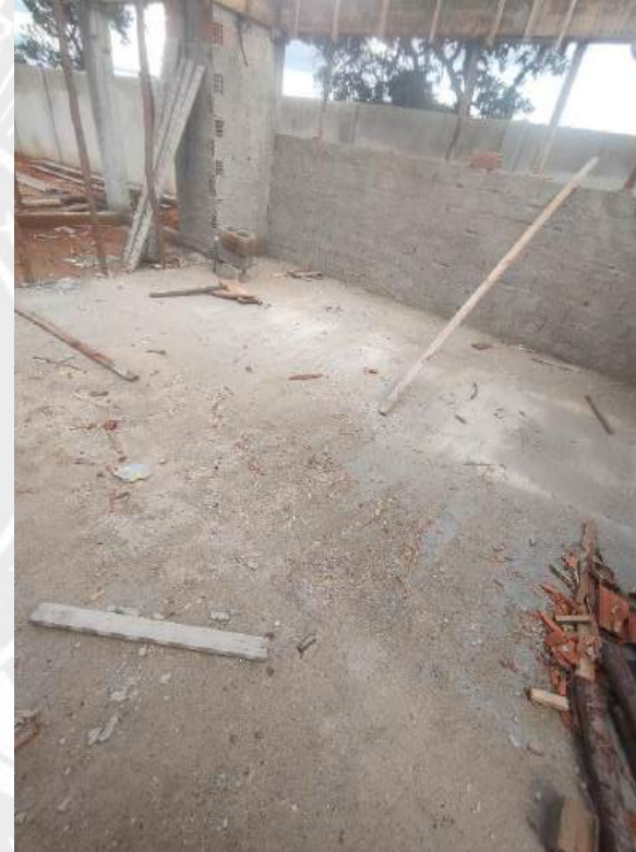
Foto 68 – Concretagem de piso
