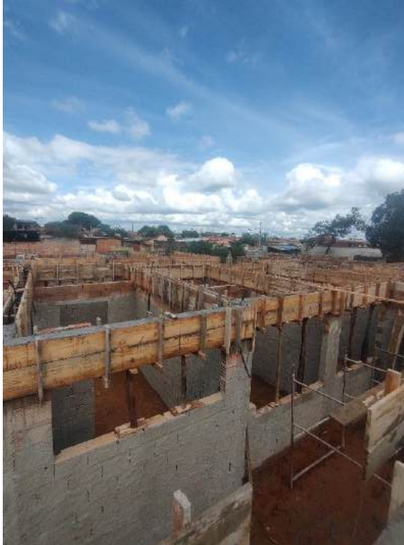
Foto 51 – Armação, forma e concretagem de cintas e vigas
