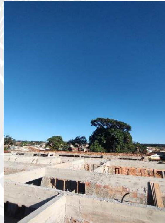
Foto 78 – Armação, forma e concretagem de cintas e vigas
