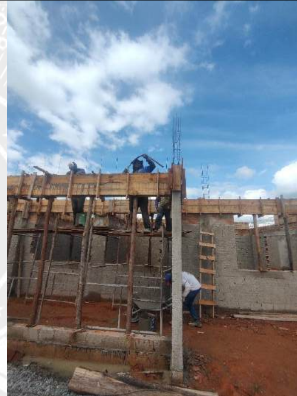
Foto 60 – Armação, forma e concretagem de cintas e vigas
