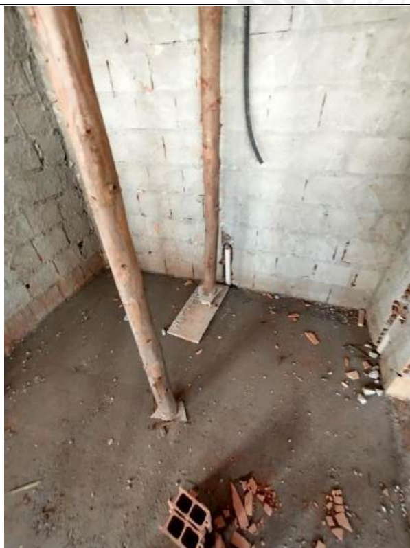
Foto 133 – Execução de redes de esgoto e concretagem de piso
