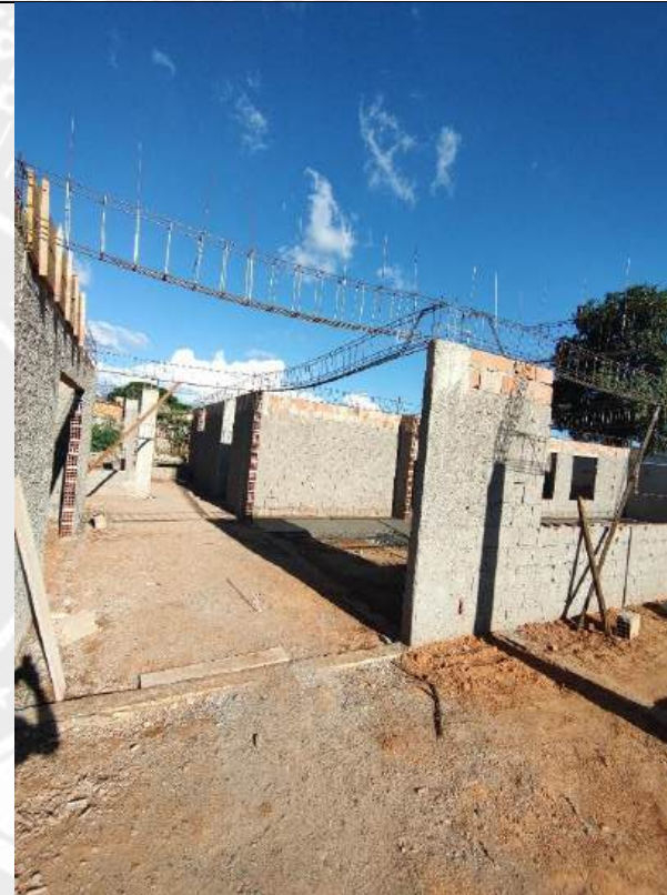
Foto 36 - Armação, forma e concretagem de cintas e vigas
