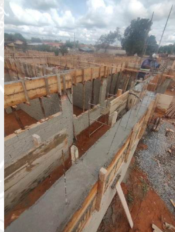
Foto 52 - Armação, forma e concretagem de cintas e vigas
