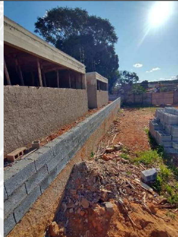
Foto 148 – Execução de mureta para assentamento de gradil
