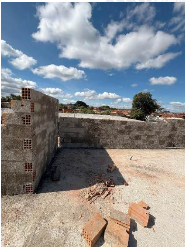
Foto 157 – Execução de alvenaria e chapisco das platibandas
