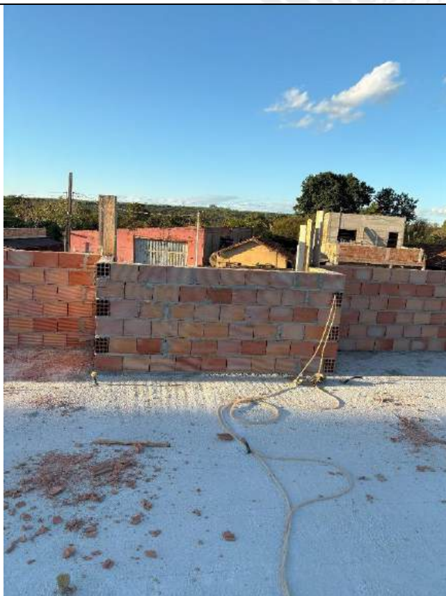
Foto 175 – Execução de alvenaria das platibandas
