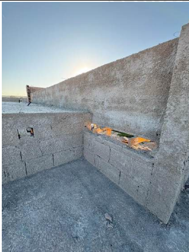
Foto 193 – Chapisco das vigas e platibandas
