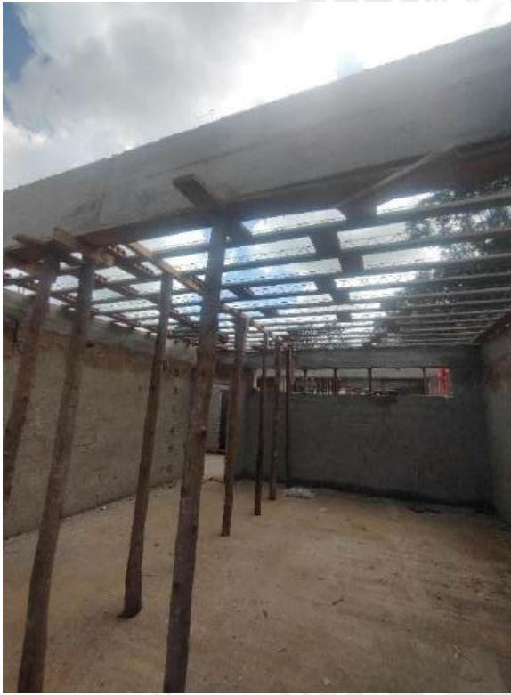
Foto 67 – Concretagem de piso
