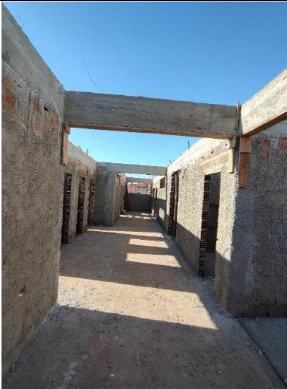
Foto 89 – Armação, forma e concretagem de vigas e cintas
