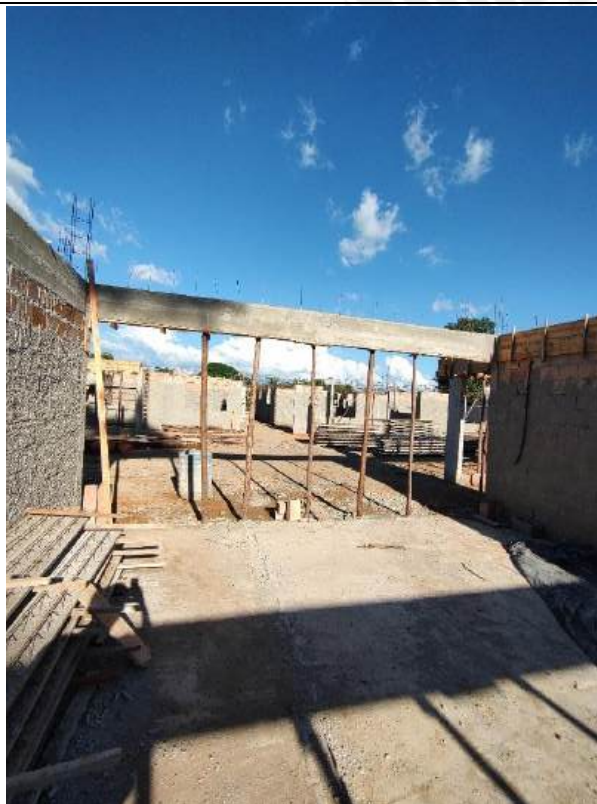
Foto 29 – Concretagem de piso
