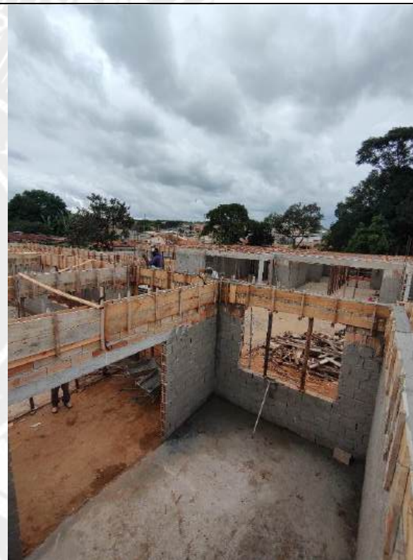
Foto 72 – Armação, forma e concretagem de cintas e vigas
