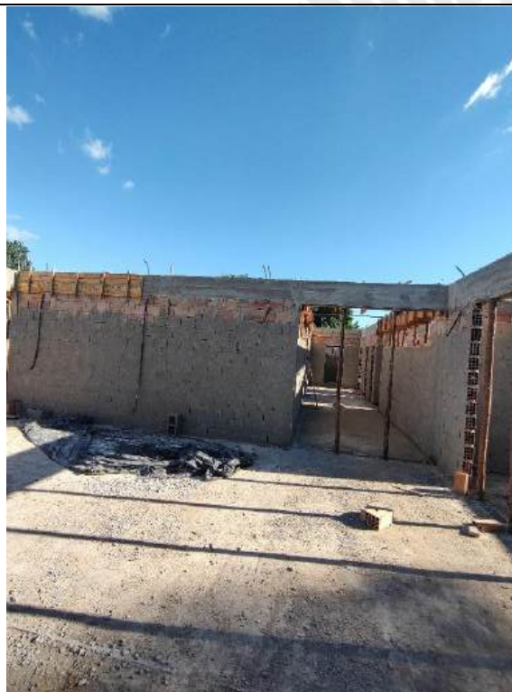
Foto 17 – Concretagem de piso
