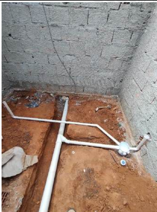
Foto 103 – Execução de redes de esgoto
