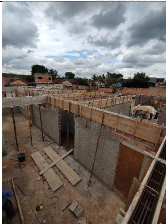
Foto 75 – Armação, forma e concretagem de cintas e vigas
