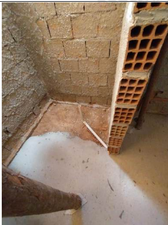
Foto 139 – Execução de redes de esgoto e concretagem de piso
