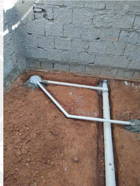
Foto 82 – Execução de redes de esgoto
