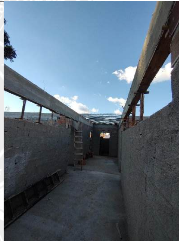
Foto 28 – Concretagem de piso
