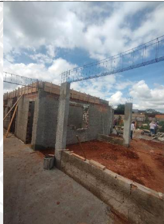
Foto 66 – Concretagem de piso
