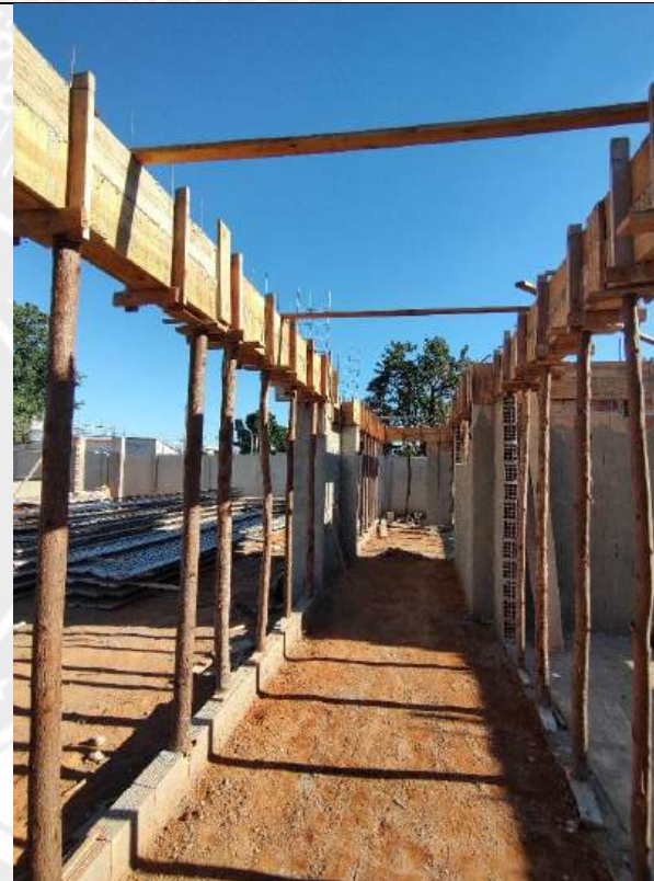
Foto 30 - Armação, forma e concretagem de cintas e vigas
