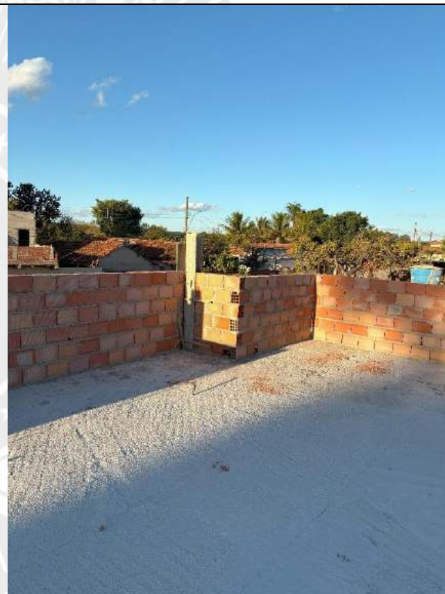
Foto 176 – Execução de alvenaria das platibandas
