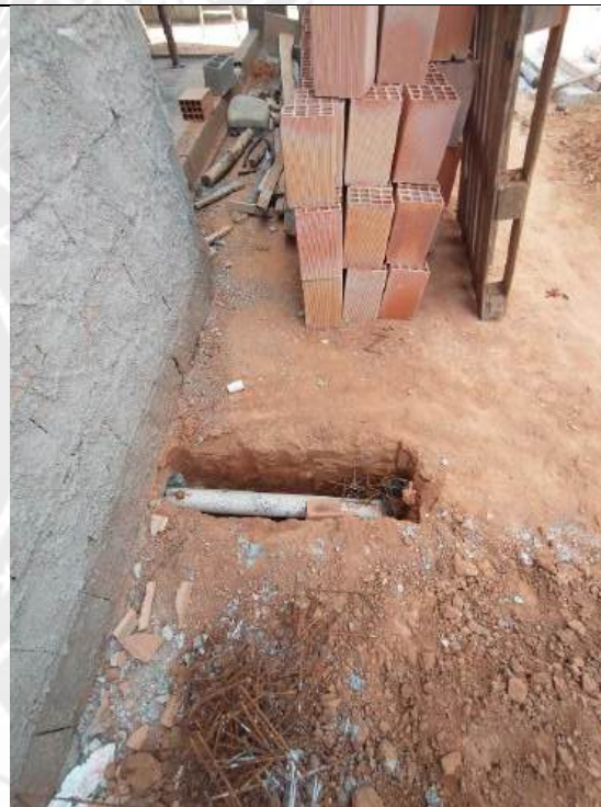
Foto 144 – Execução de redes de esgoto
