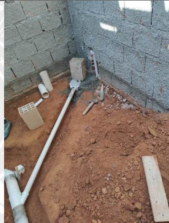
Foto 84 – Execução de redes de esgoto
