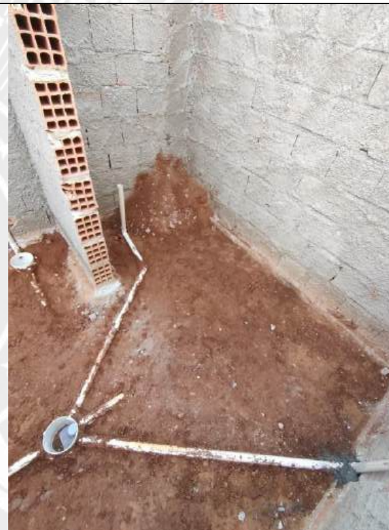
Foto 128 – Execução de redes de esgoto
