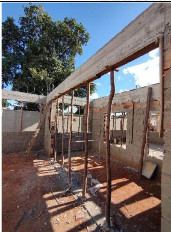
Foto 99 – Armação, forma e concretagem de vigas e cintas
