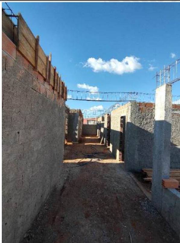
Foto 41 – Armação, forma e concretagem de cintas e vigas
