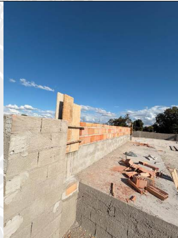
Foto 198 – Forma e concretagem de pilares das platibandas
