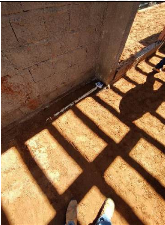
Foto 123 – Execução de redes de esgoto
