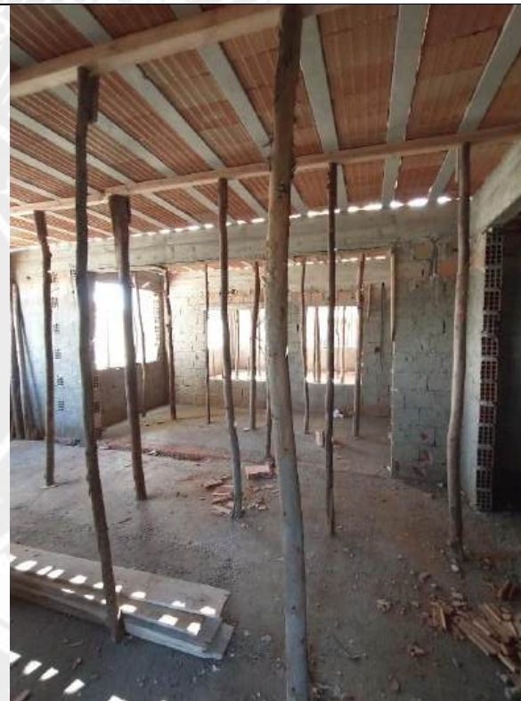
Foto 132 – Concretagem de piso
