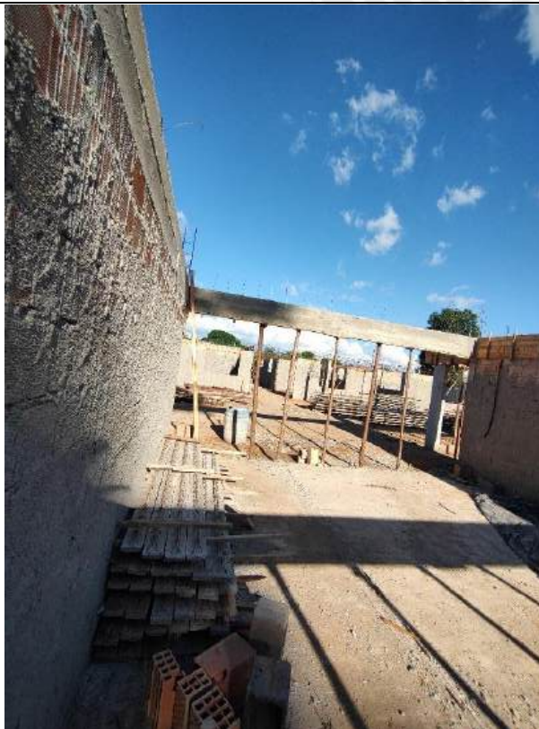
Foto 19 – Concretagem de piso
