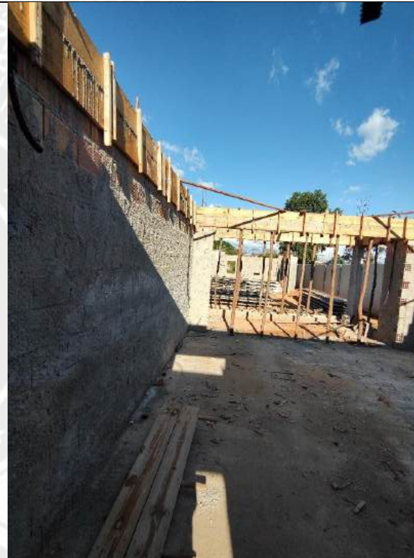
Foto 26 – Concretagem de piso
