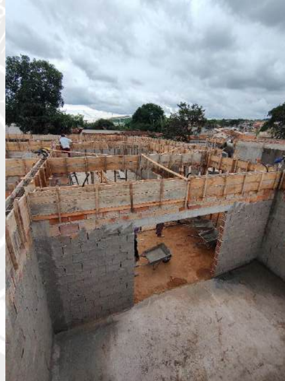
Foto 74 – Armação, forma e concretagem de cintas e vigas
