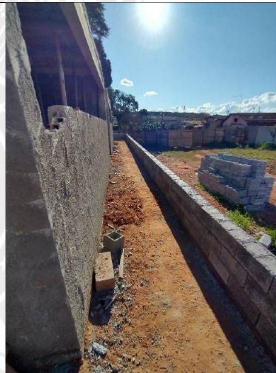
Foto 150 – Execução de mureta para assentamento de gradil
