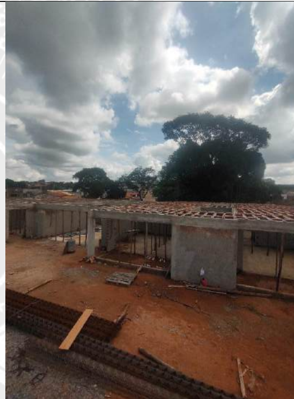
Foto 54 – Armação, forma e concretagem de cintas e vigas
