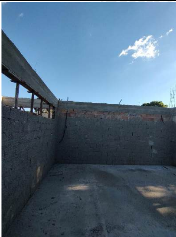
Foto 13 – Concretagem de piso
