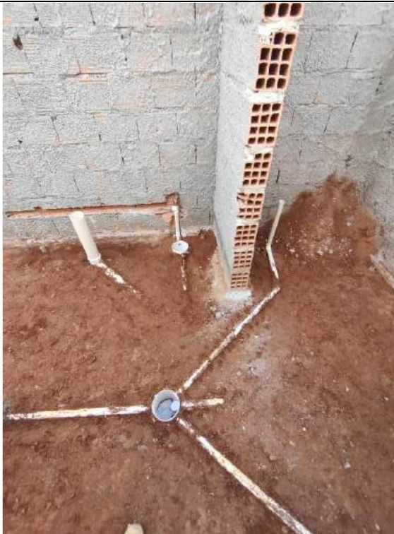
Foto 129 – Execução de redes de esgoto
