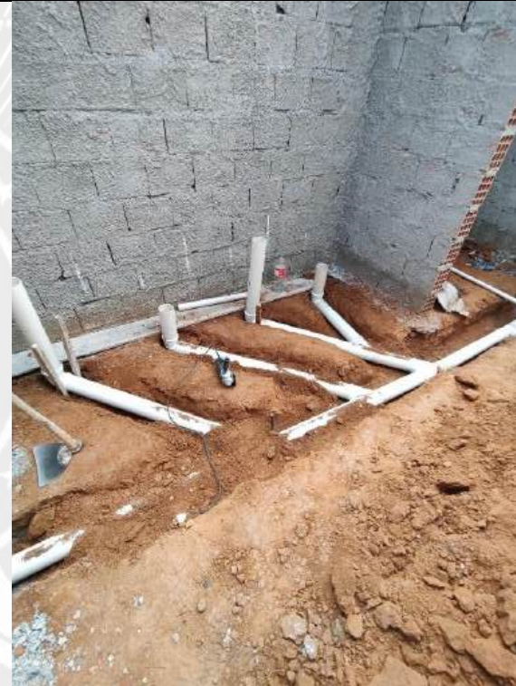
Foto 106 – Execução de redes de esgoto
