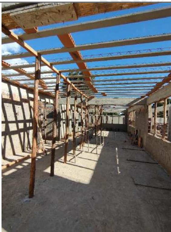
Foto 95 – Armação, forma e concretagem de vigas e cintas
