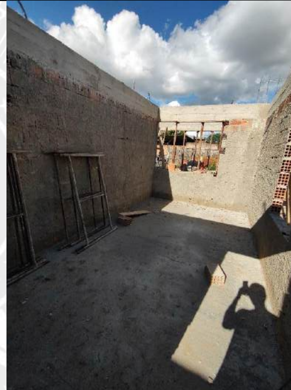
Foto 90 – Armação, forma e concretagem de vigas e cintas
