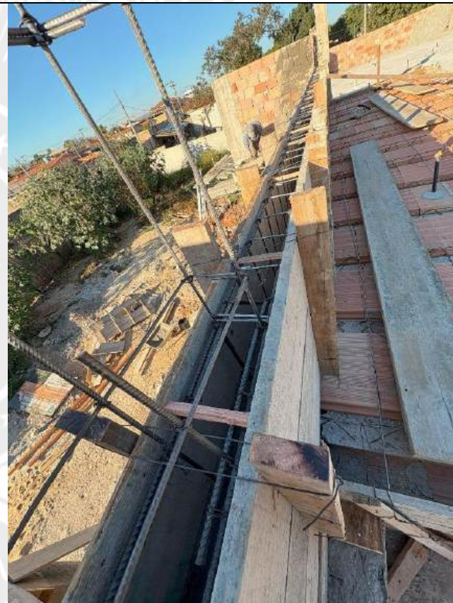
Foto 184 – Forma e concretagem de viga
