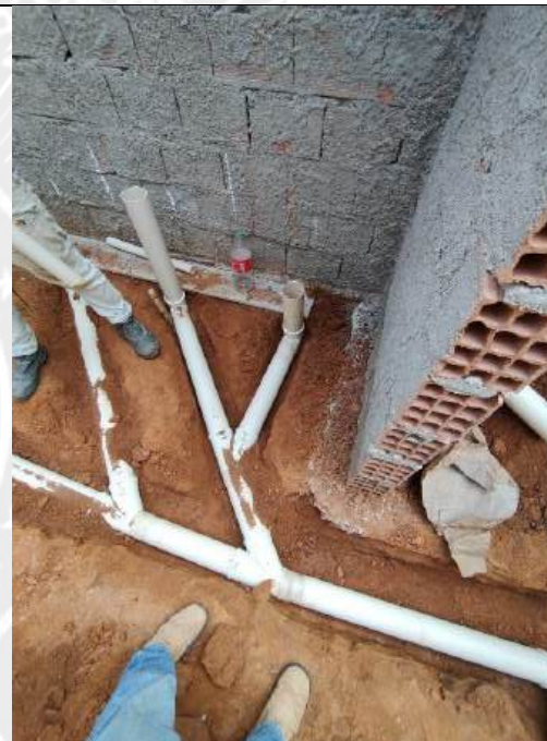
Foto 104 – Execução de redes de esgoto
