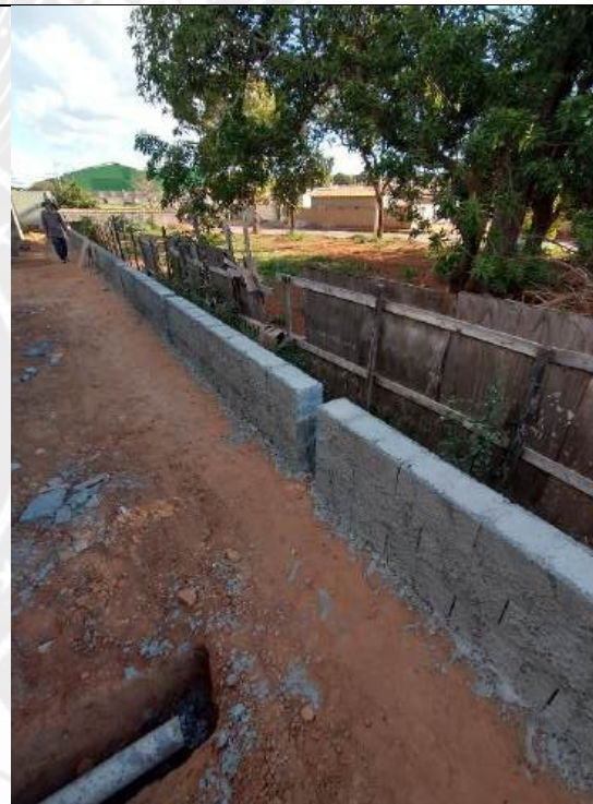
Foto 154 – Execução de mureta para assentamento de gradil
