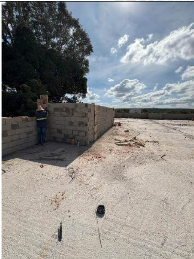
Foto 165 – Forma e concretagem de pilares das platibandas
