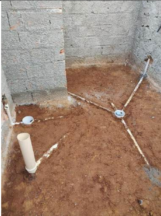
Foto 125 – Execução de redes de esgoto
