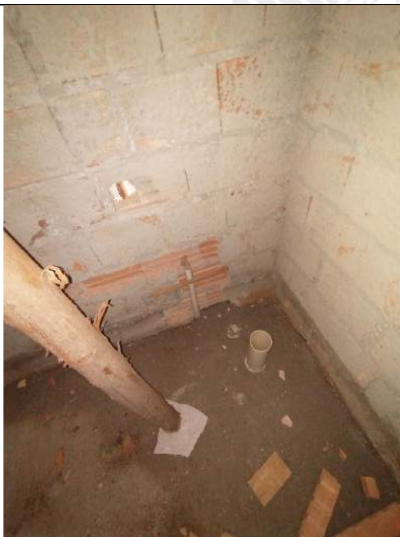
Foto 137 – Execução de redes de esgoto e concretagem de piso
