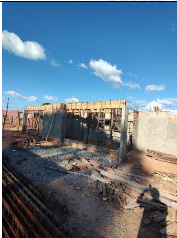
Foto 33 – Armação, forma e concretagem de cintas e vigas
