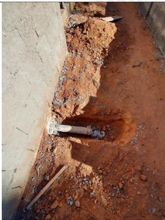
Foto 155 – Execução de redes de esgoto
