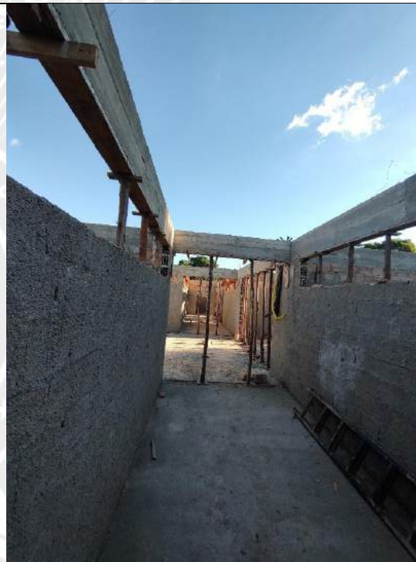
Foto 10 – Concretagem de piso
