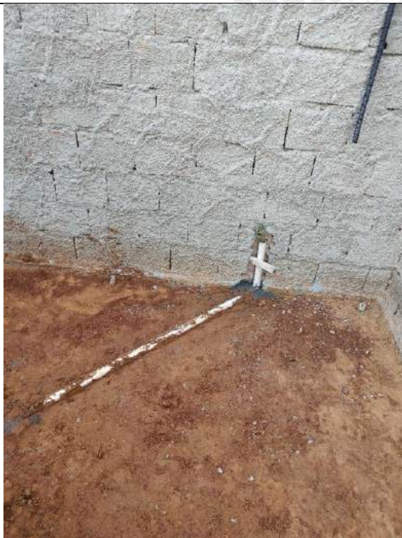
Foto 127 – Execução de redes de esgoto
