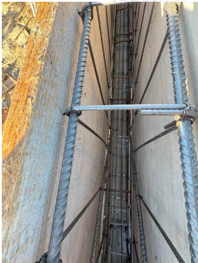
Foto 187 – Forma e concretagem de viga
