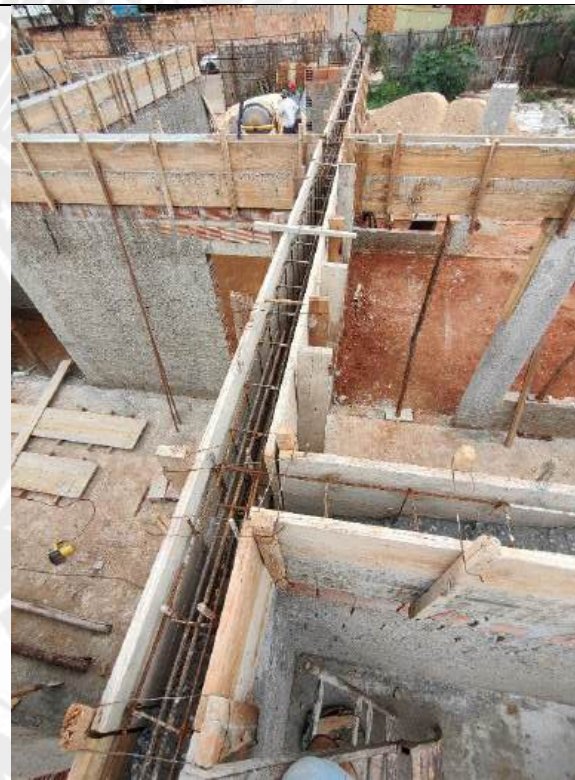
Foto 76 – Armação, forma e concretagem de cintas e vigas
