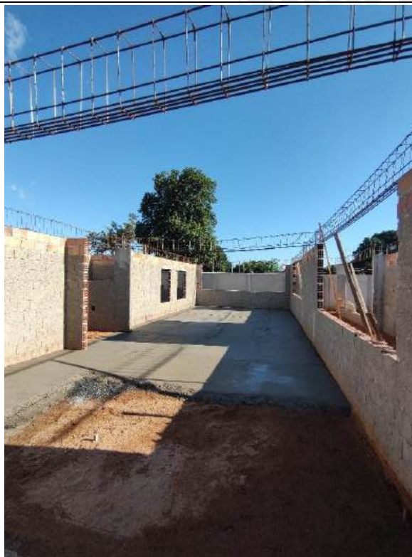
Foto 37 – Concretagem de piso
