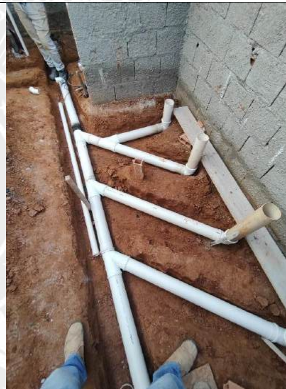
Foto 120 – Execução de redes de esgoto
