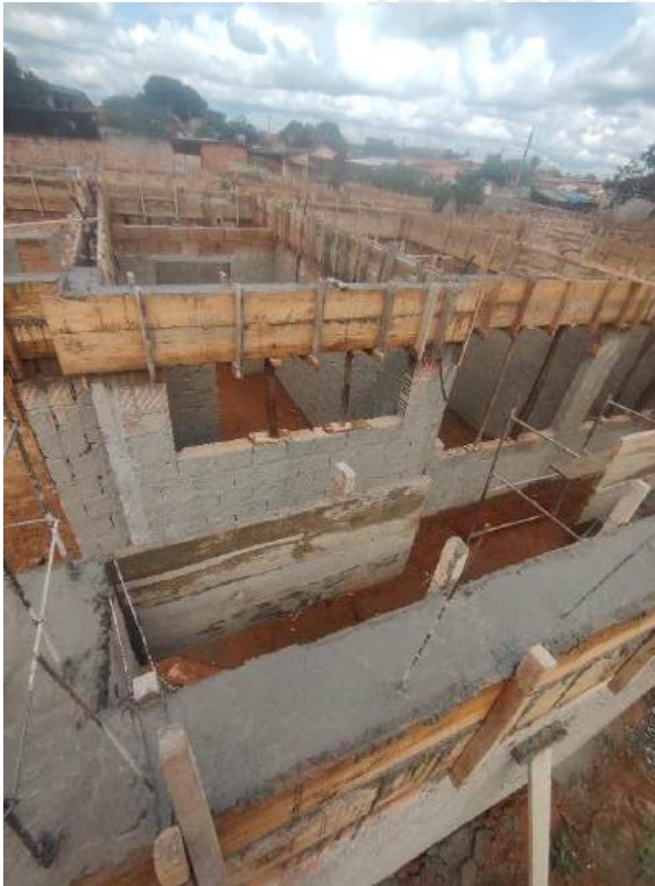
Foto 47 - Armação, forma e concretagem de cintas e vigas
