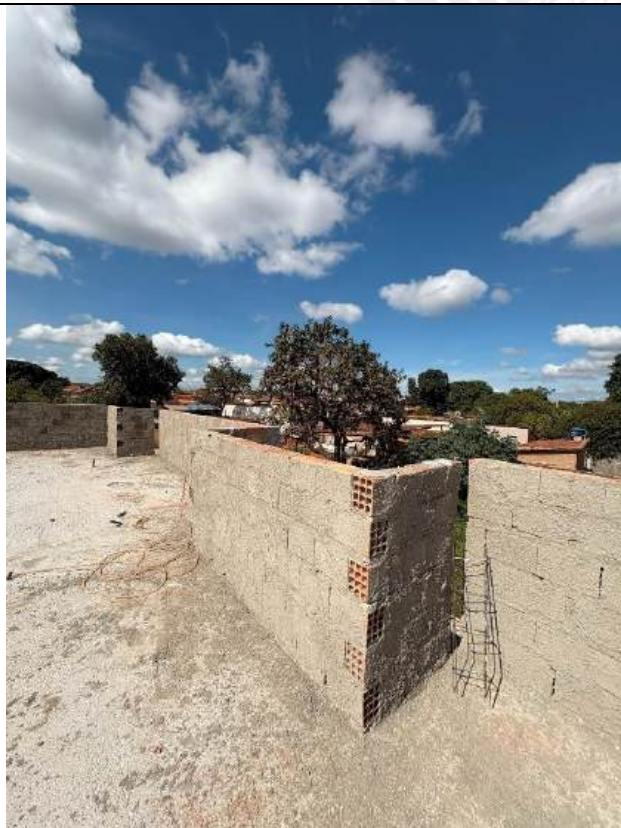
Foto 163 – Execução de alvenaria e chapisco das platibandas
