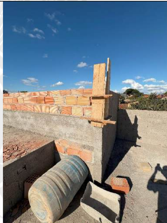
Foto 202 – Forma e concretagem de pilares das platibandas
