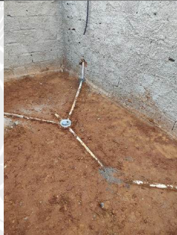
Foto 126 – Execução de redes de esgoto
