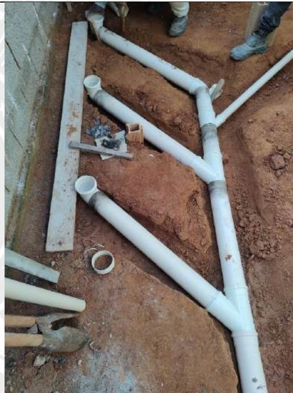
Foto 80 – Execução de redes de esgoto
