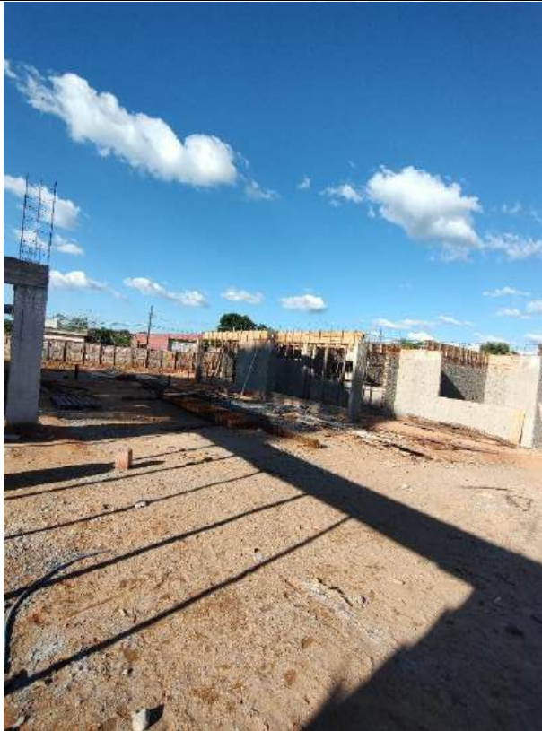
Foto 31 - Armação, forma e concretagem de cintas e vigas
