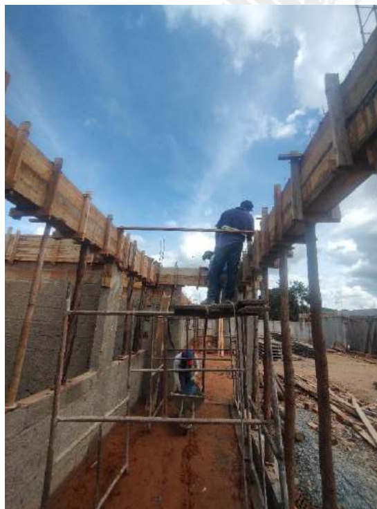
Foto 57 – Armação, forma e concretagem de cintas e vigas
