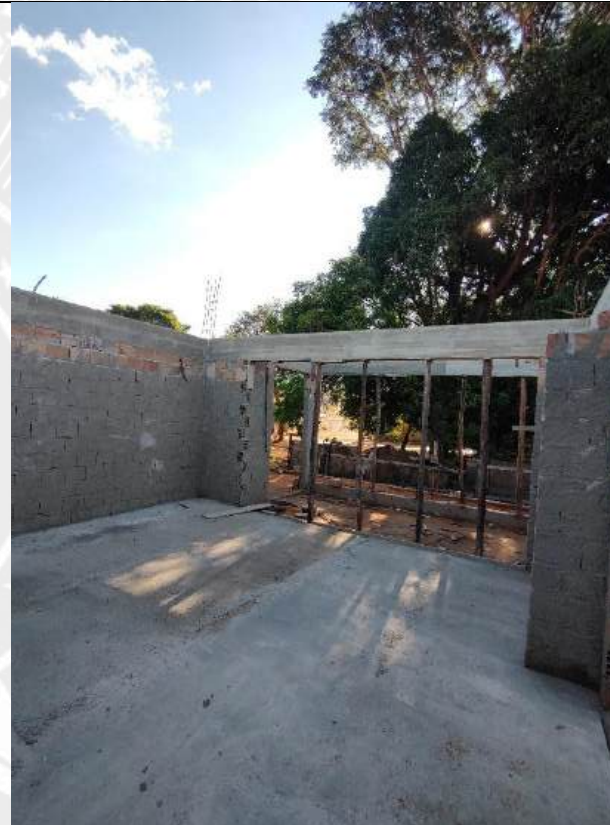
Foto 12 – Concretagem de piso
