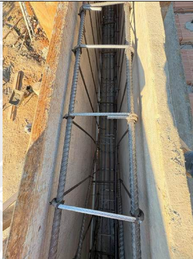
Foto 186 – Forma e concretagem de viga
