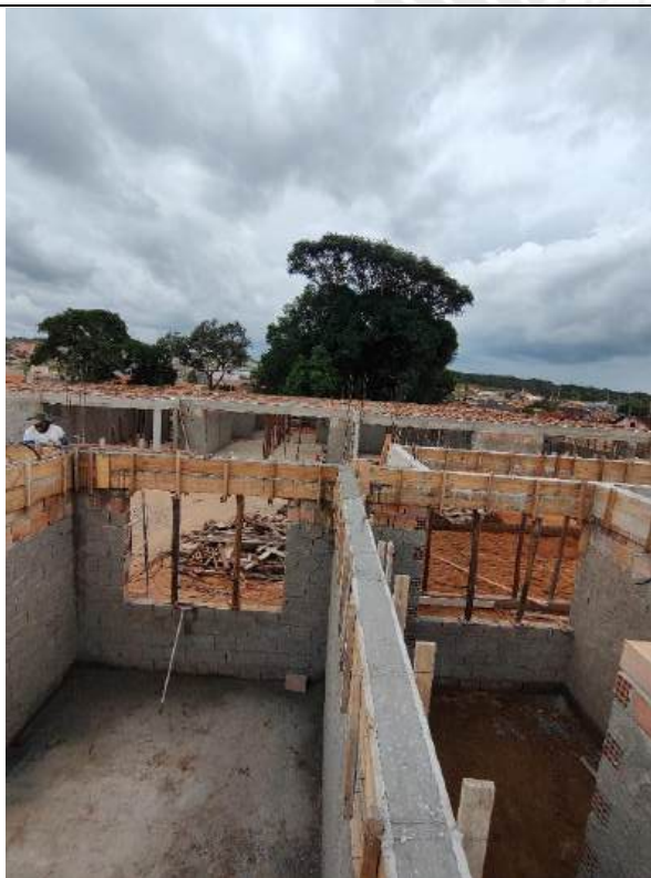
Foto 71 – Armação, forma e concretagem de cintas e vigas
