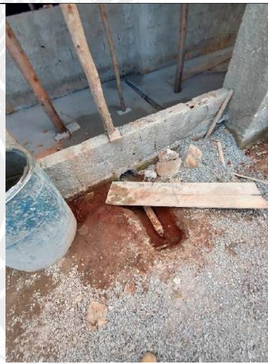
Foto 142 – Execução de redes de esgoto e concretagem de piso
