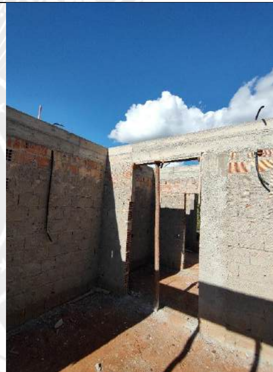
Foto 100 – Armação, forma e concretagem de vigas e cintas
