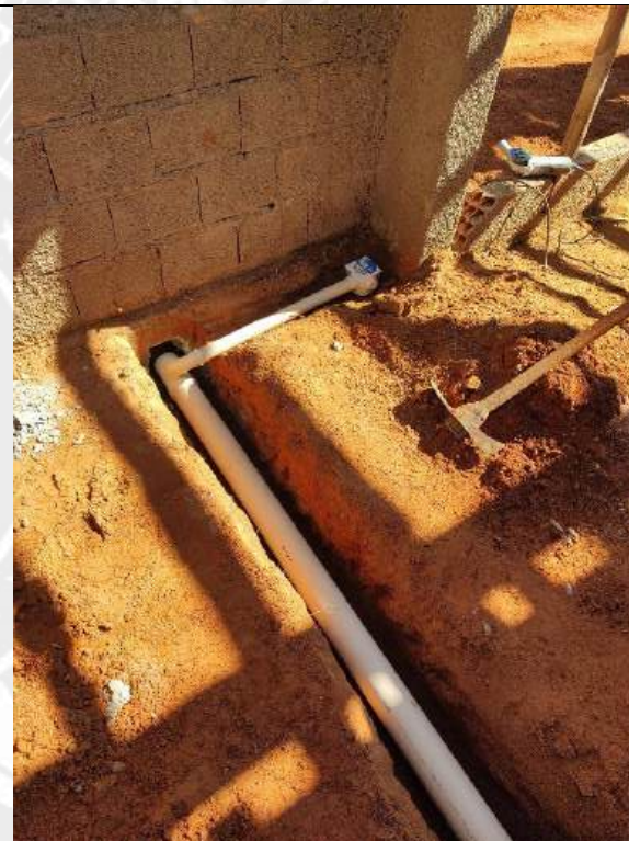
Foto 86 – Execução de redes de esgoto
