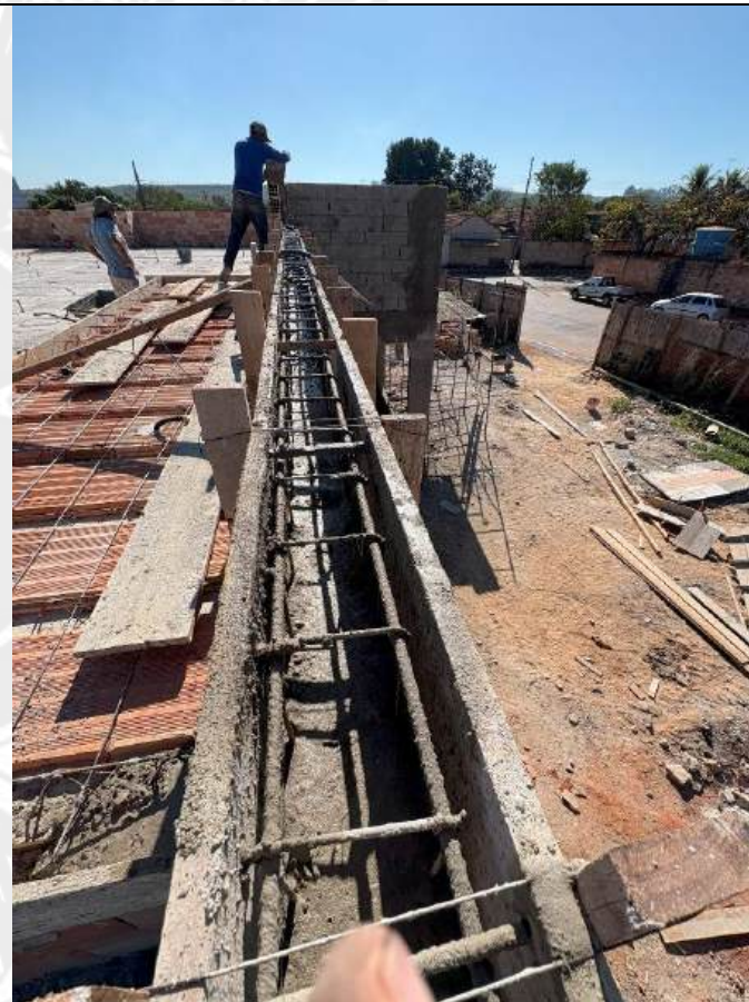
Foto 188 – Forma e concretagem de viga
