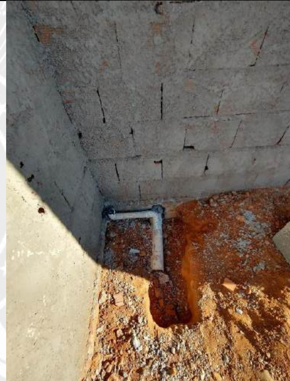
Foto 146 – Execução de redes de esgoto
