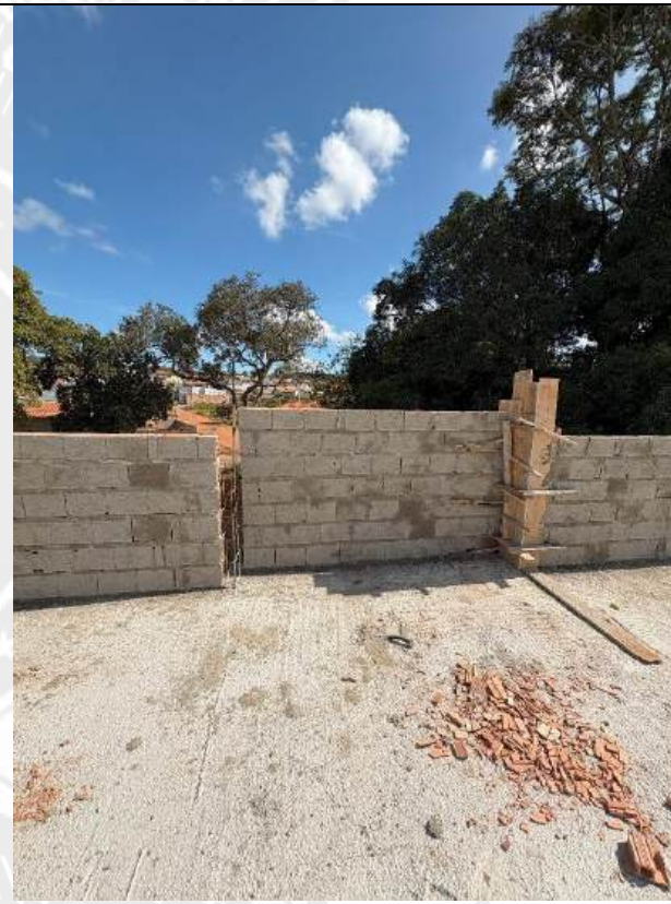
Foto 164 – Execução de alvenaria e chapisco das platibandas
