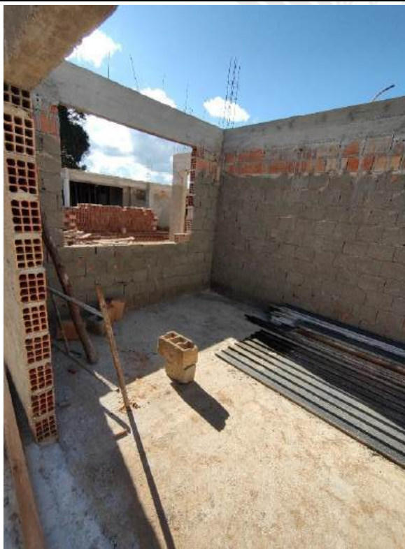
Foto 97 – Armação, forma e concretagem de vigas e cintas
