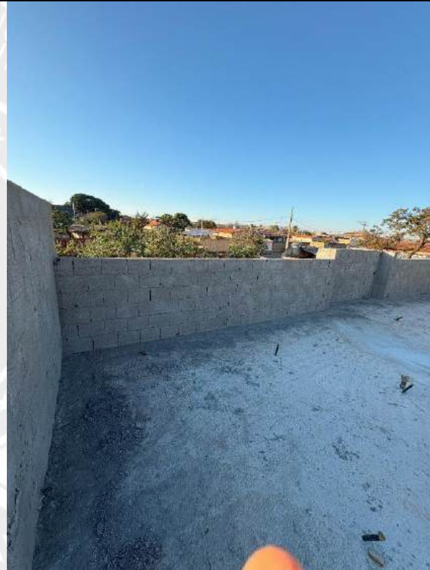
Foto 194 – Chapisco das platibandas
