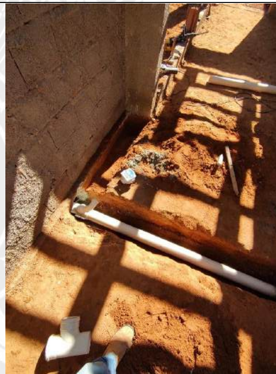
Foto 122 – Execução de redes de esgoto
