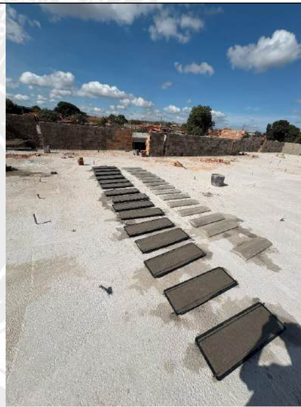
Foto 168 – Execução de alvenaria e chapisco das platibandas
