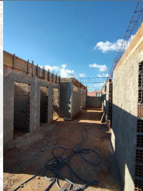
Foto 42 - Armação, forma e concretagem de cintas e vigas
