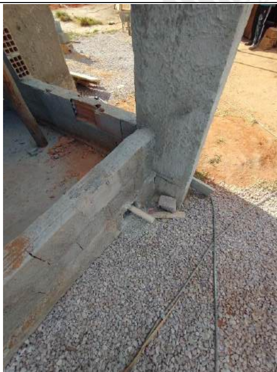
Foto 143 – Execução de redes de esgoto
