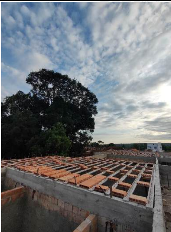
Foto 69 – Armação, forma e concretagem de cintas e vigas
