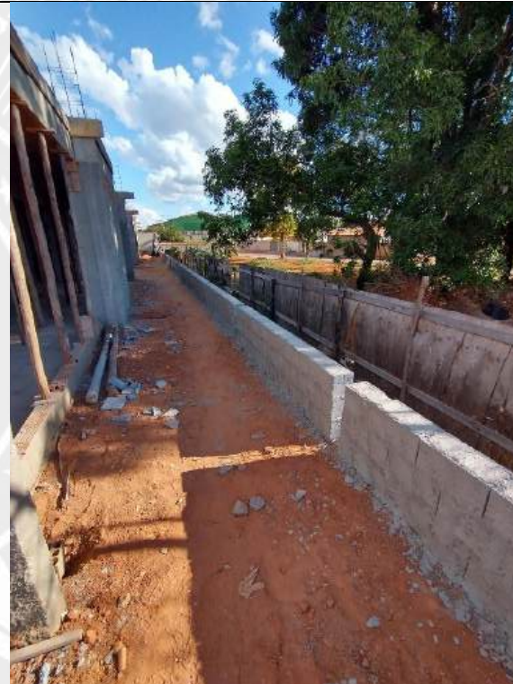
Foto 152 – Execução de mureta para assentamento de gradil
