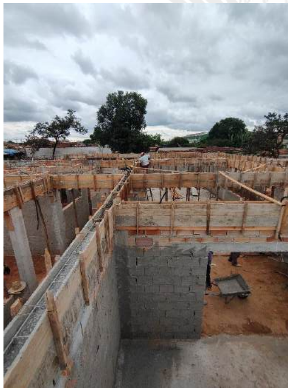
Foto 73 – Armação, forma e concretagem de cintas e vigas
