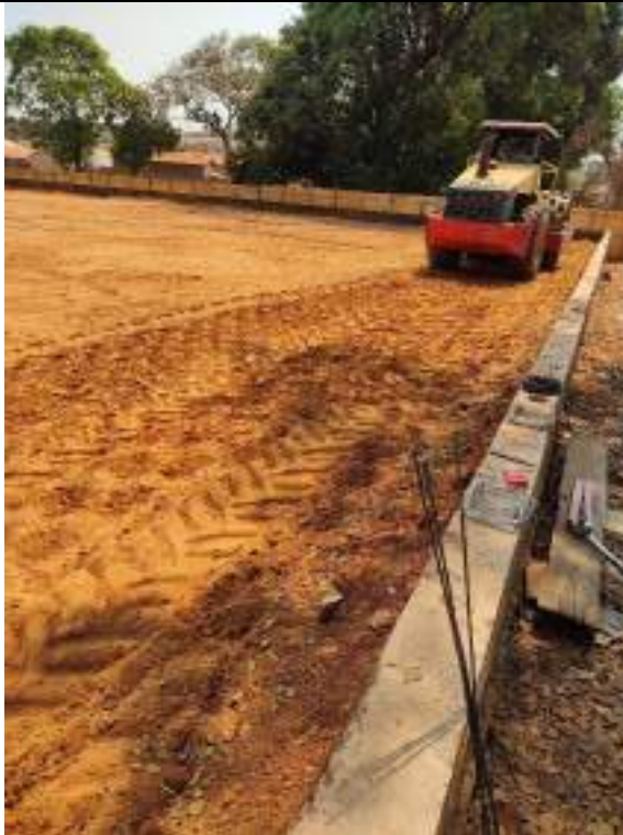
Foto 211 – Execução de compactação mecanizada do aterro da obra
