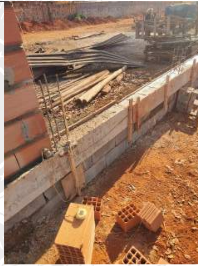
Foto 110 – Forma e concretagem de cintas
