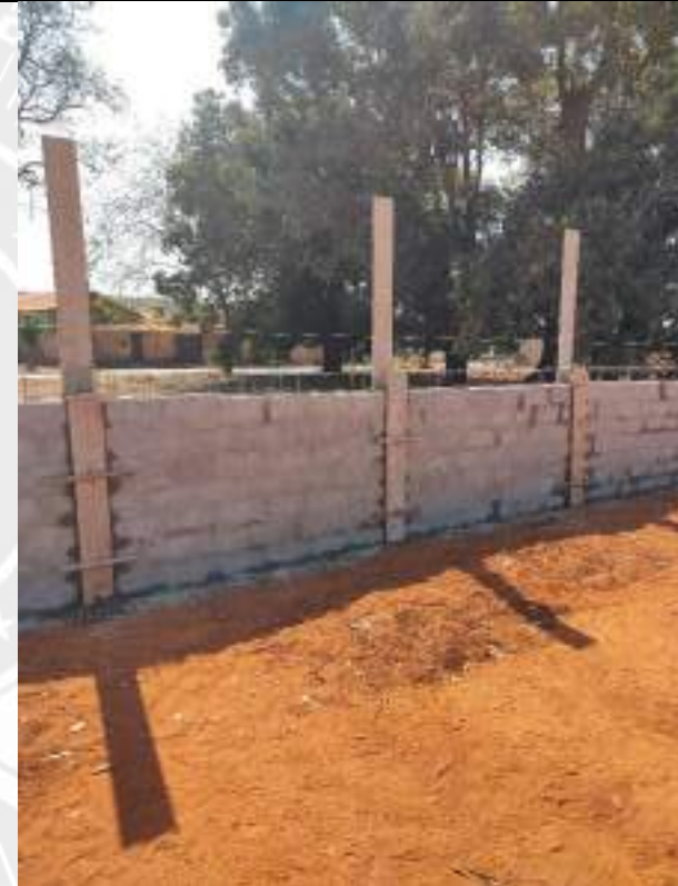
Foto 96 – Execução de rejunte em muro de arrimo
