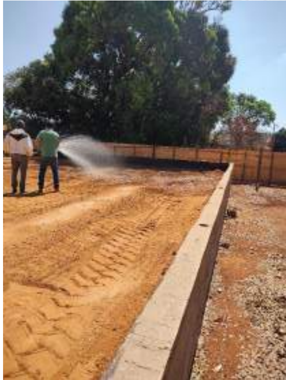
Foto 209 – Execução de umedecimento de aterro para compactação
