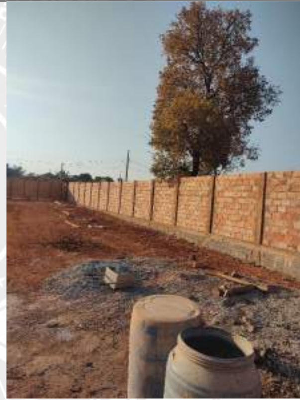
Foto 146 – Execução de muro de divisa
