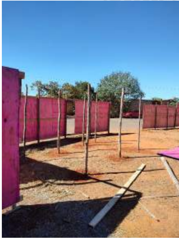
Foto 19 – Execução de barracão de obra
