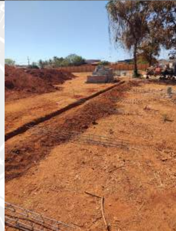
Foto 76 – Execução de fundação muro de arrimo
