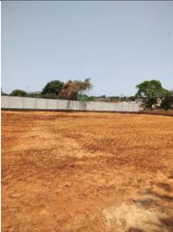
Foto 227 – Execução de compactação mecanizada do aterro da obra
