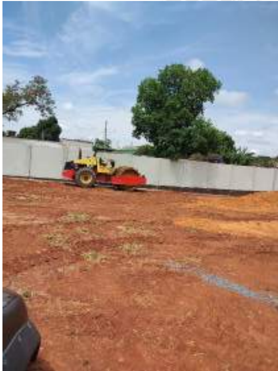
Foto 243 – Execução de aterro compactado
