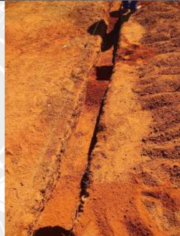
Foto 68 – Execução de fundação muro de arrimo
