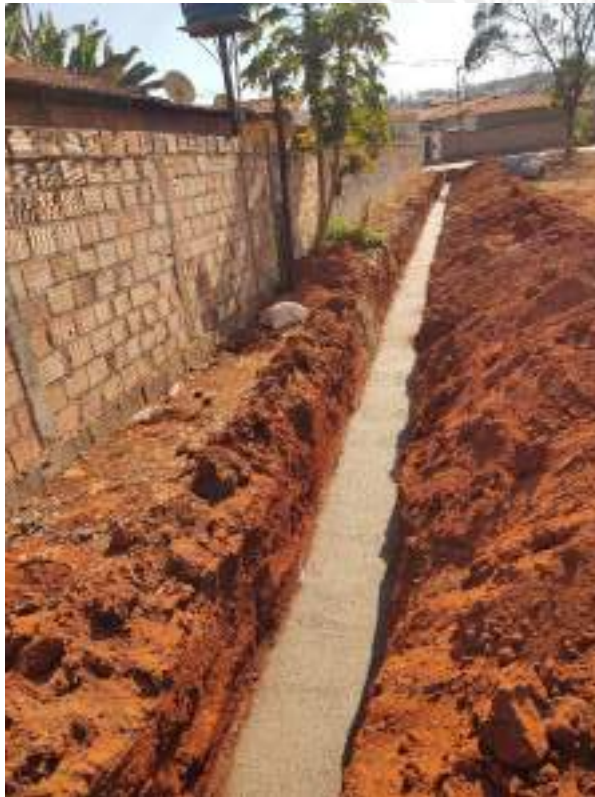
Foto 125 – Acerto de fundo de vala e concretagem de berço
