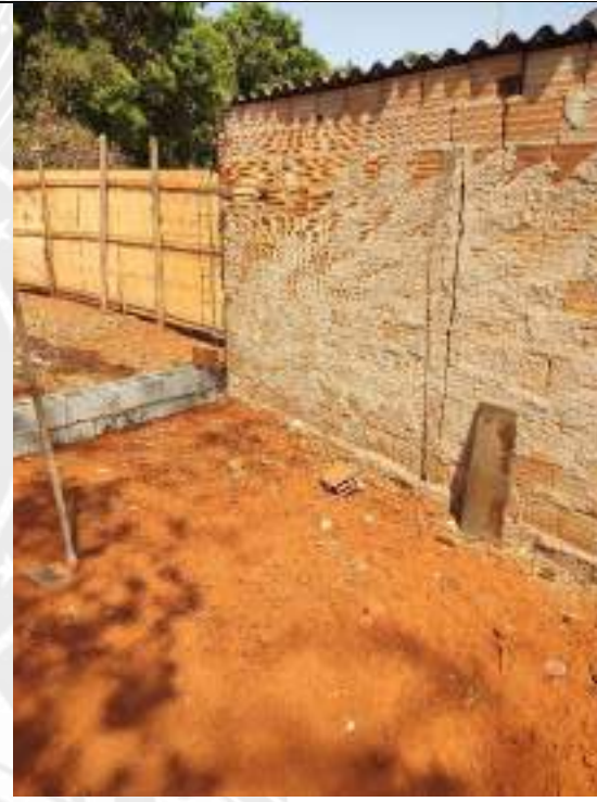
Foto 222 – Execução de fundação de muro de divisa
