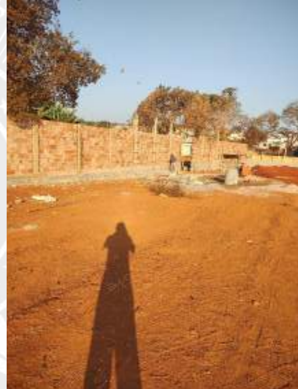
Foto 116 – Execução de muro de divisa
