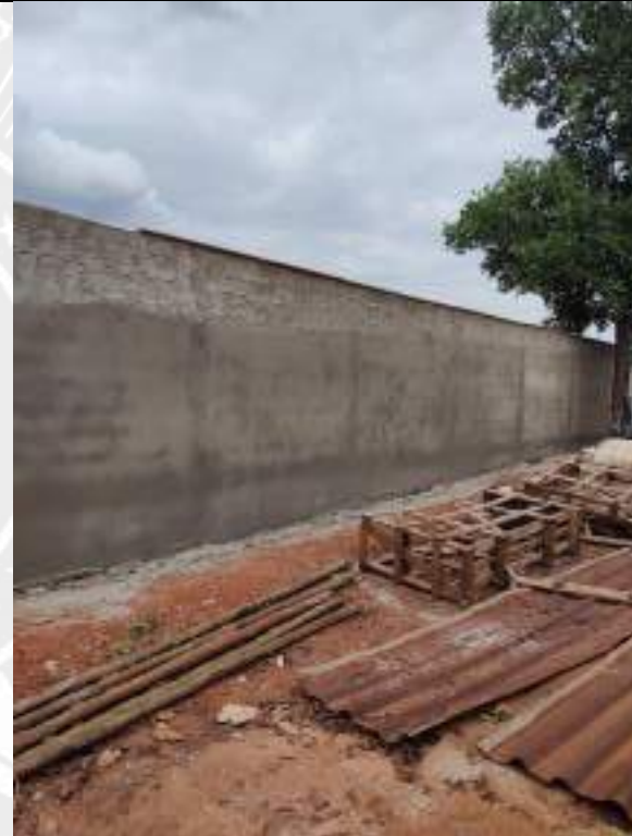
Foto 266 – Reboco dos muros de divisa
