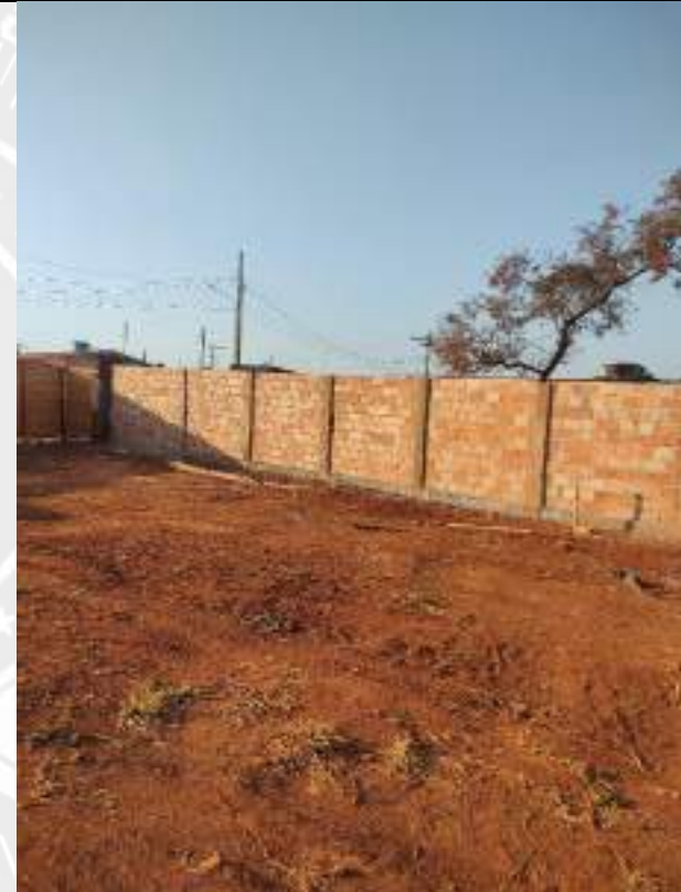
Foto 114 – Execução de muro de divisa
