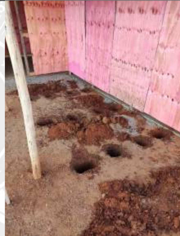
Foto 60 – Execução de mesa para o barracão de obra
