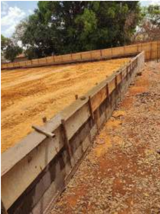
Foto 193 – Forma e concretagem de cintas
