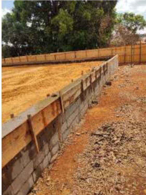
Foto 195 – Forma e concretagem de cintas
