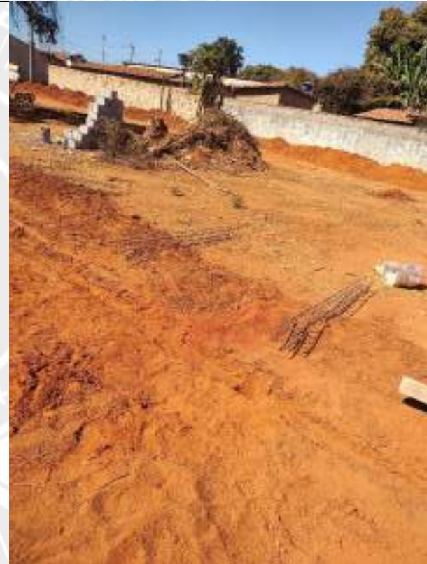
Foto 70 – Execução de fundação muro de arrimo
