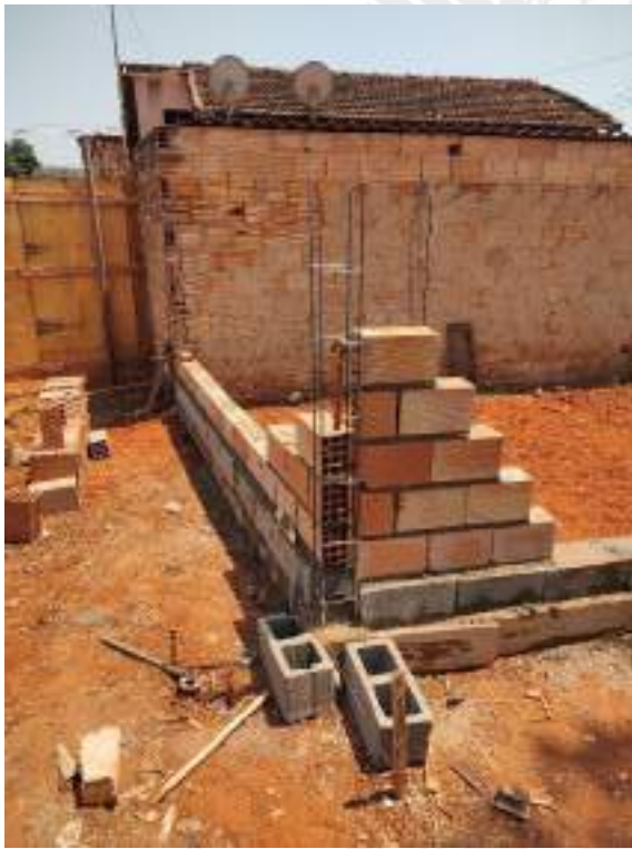
Foto 235 – Execução de muro de divisa
