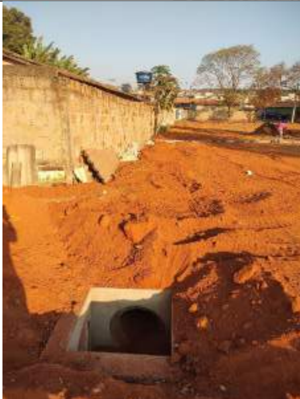
Foto 145 – Aterro compactado da rede de drenagem
