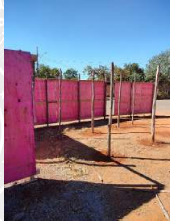
Foto 6 - Execução de tapume para fechamento de obra
