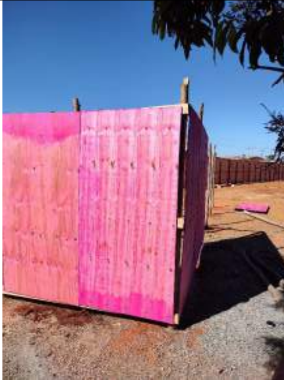
Foto 13 – Execução de barracão de obra com sanitário e depósito
