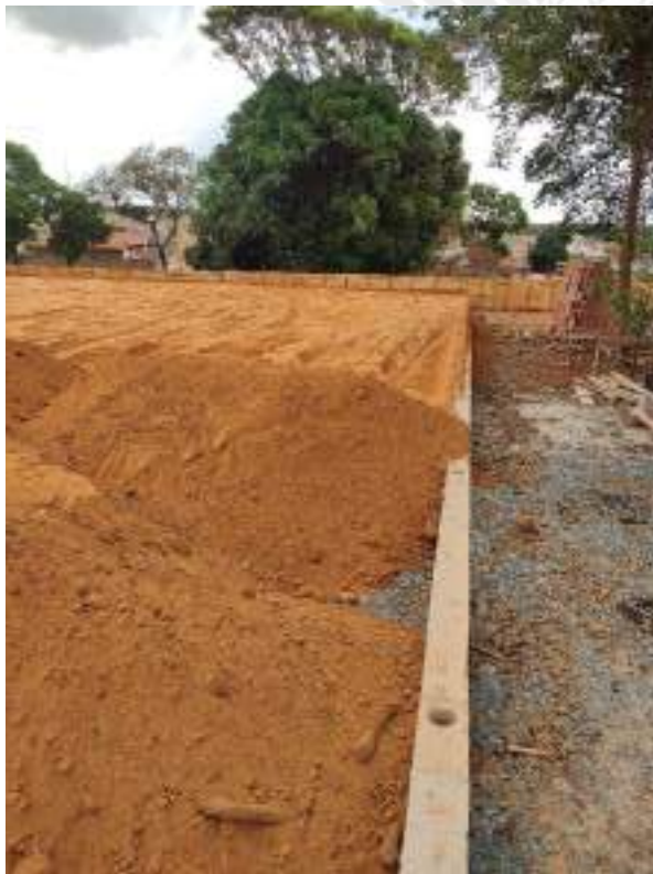
Foto 247 – Execução de aterro compactado
