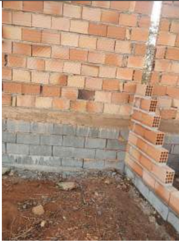
Foto 171 – Execução de muro de divisa
