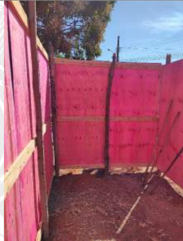
Foto 8 - Execução de barracão de obra com sanitário e depósito
