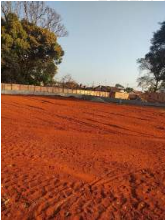
Foto 149 – Execução de aterro compactado da construção
