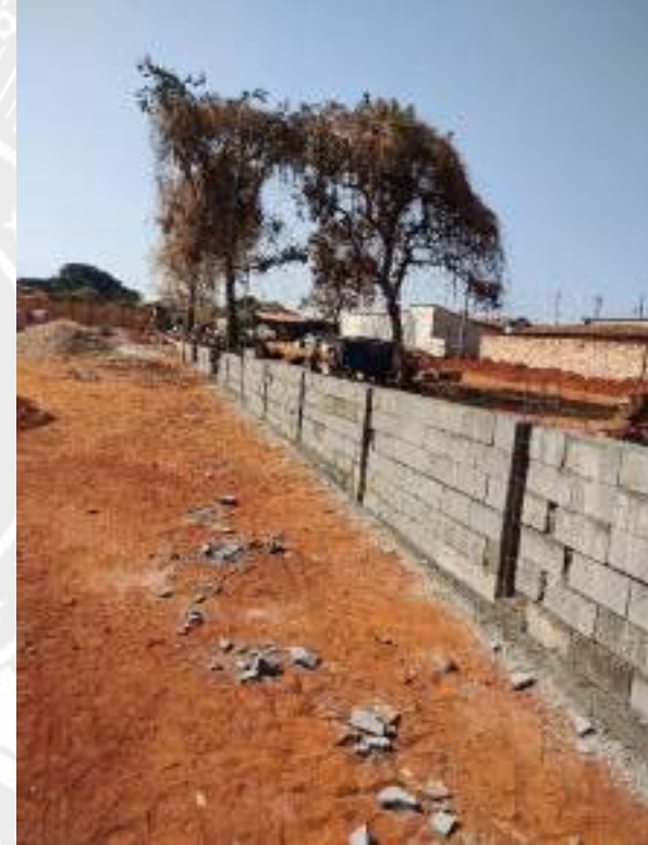
Foto 90 – Execução de muro de arrimo e concretagem de pilares
