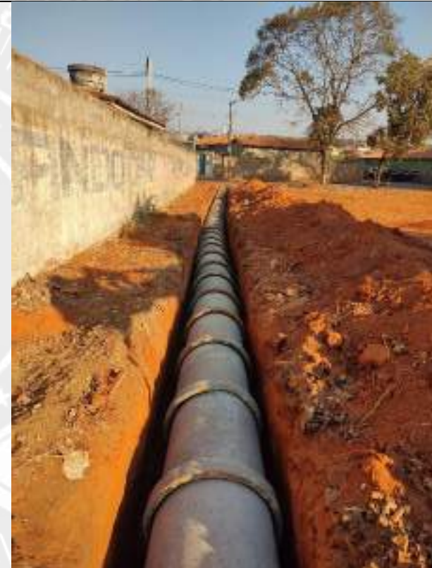
Foto 132 – Assentamento de manilhas de 600mm
