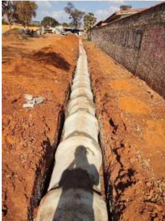
Foto 139 – Concretagem de “travesseiro” da rede de drenagem
