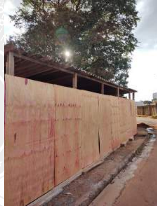
Foto 36 - Execução de telhado do barracão de obra
