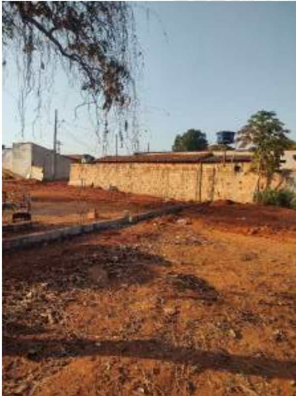
Foto 169 – Execução de muro de divisa
