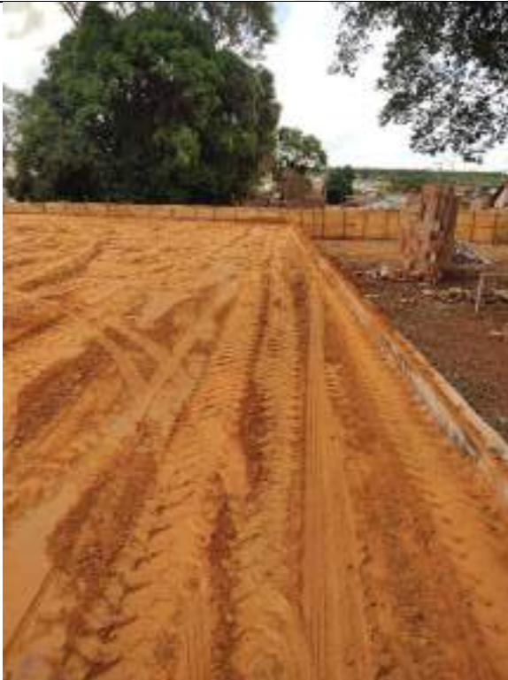
Foto 249 – Execução de aterro compactado
