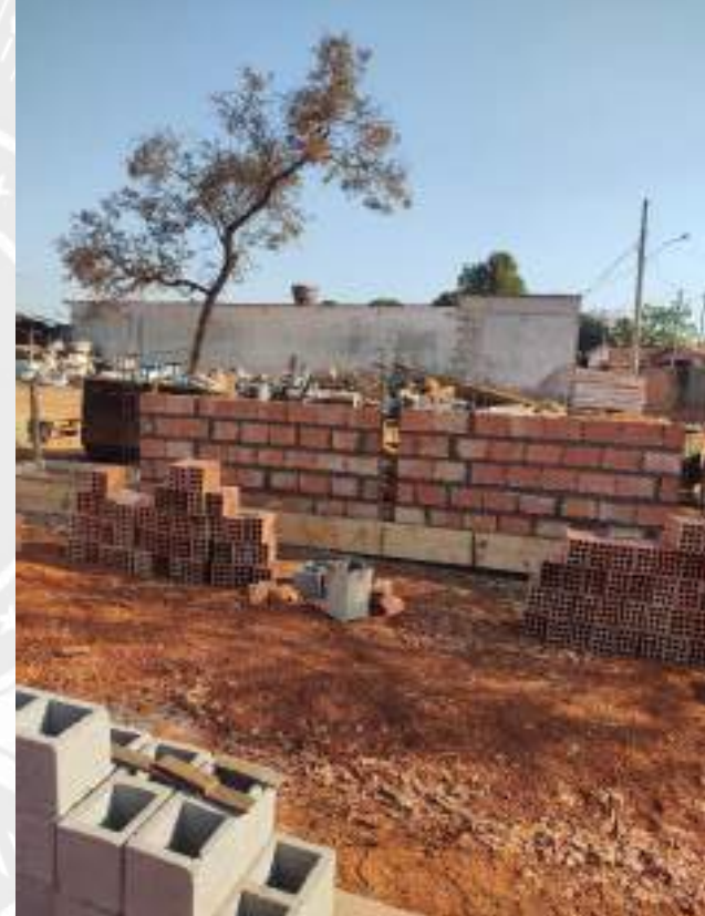
Foto 108 – Execução de muro de divisa
