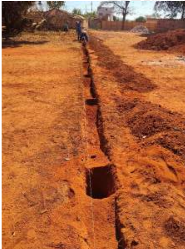
Foto 79 – Execução de fundação muro de arrimo
