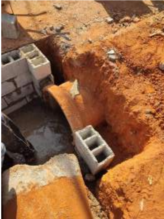
Foto 141 – Execução de caixa de drenagem
