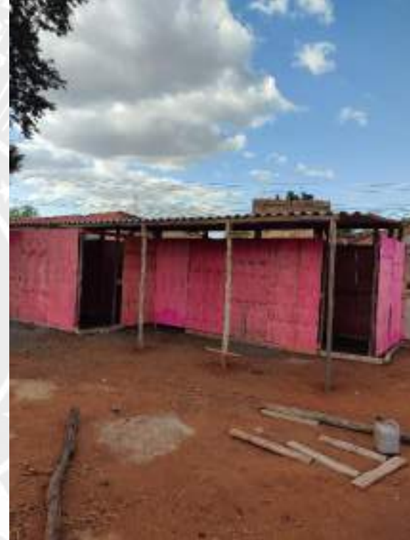
Foto 54 – Execução dos barracões de obra
