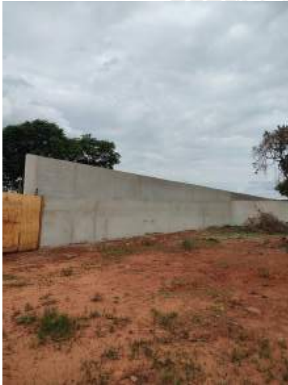
Foto 269 – Reboco dos muros de divisa
