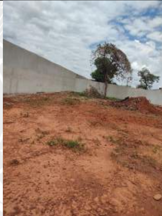
Foto 262 – Reboco dos muros de divisa
