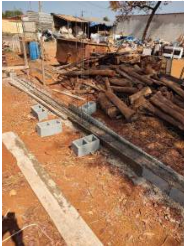
Foto 101 – Execução de cinta do muro de divisa
