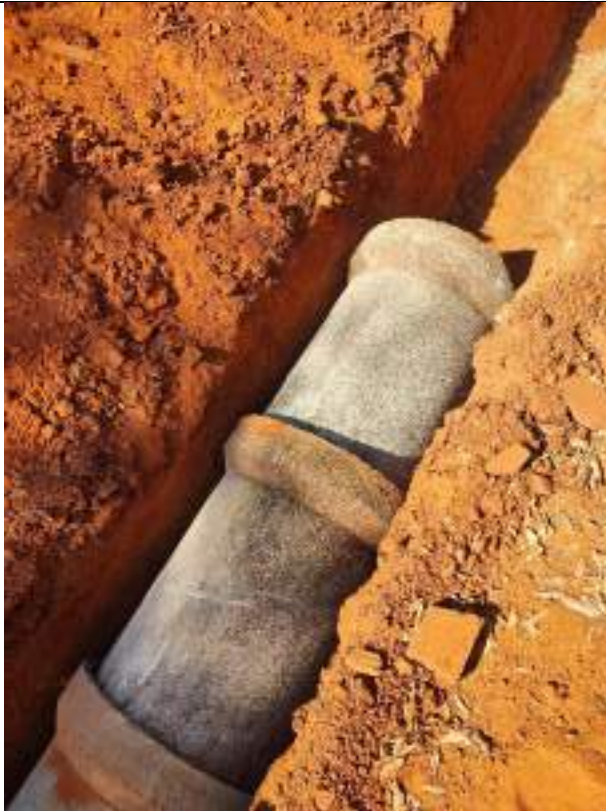
Foto 129 – Assentamento de manilhas de 600mm
