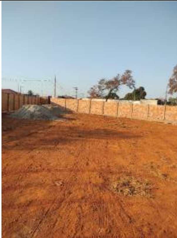
Foto 113 – Execução de muro de divisa
