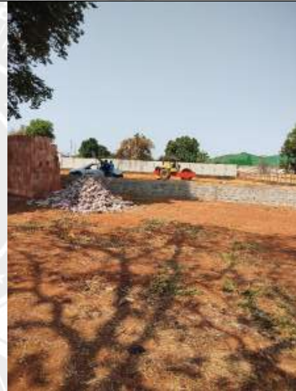
Foto 224 – Execução de compactação mecanizada do aterro da obra
