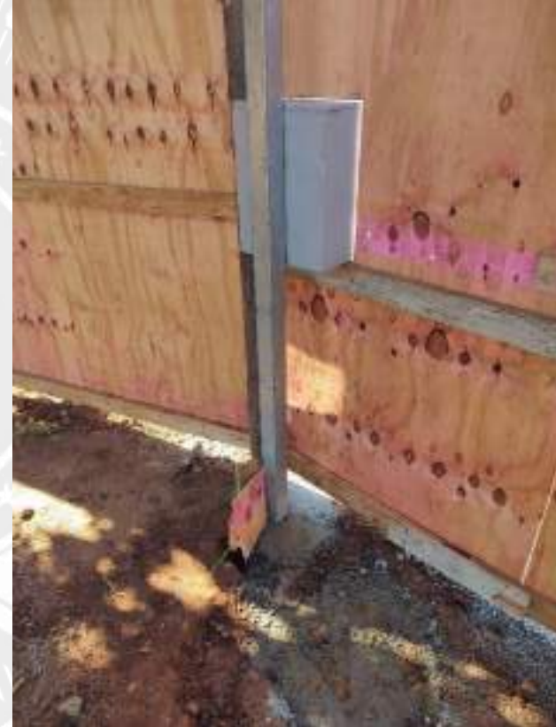
Foto 66 – Execução de ligações hidrossanitárias
