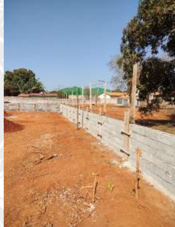
Foto 86 – Execução de muro de arrimo e concretagem de pilares
