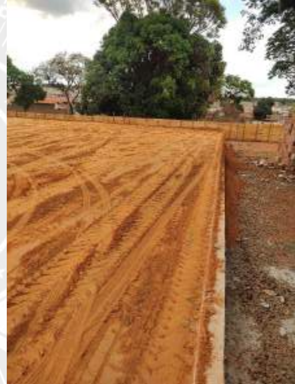
Foto 248 – Execução de aterro compactado
