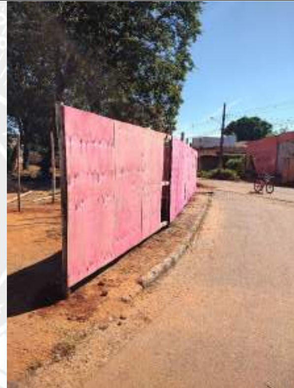
Foto 26 – Execução de tapume para fechamento de obra
