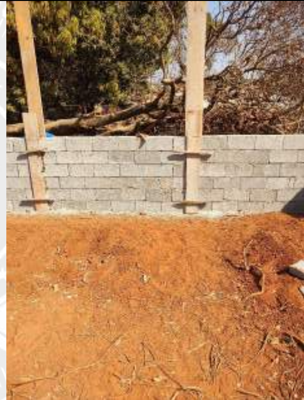
Foto 84 – Execução de muro de arrimo e concretagem de pilares
