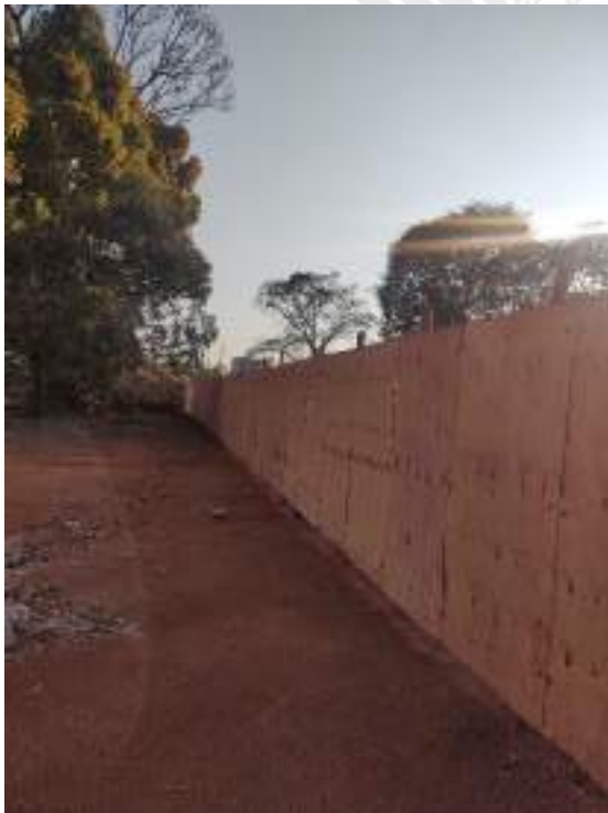
Foto 165 – Execução de tapume de fechamento de obra
