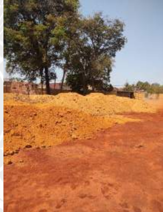
Foto 190 – Execução de aterro compactado da construção
