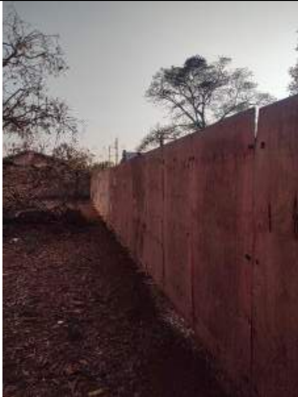
Foto 167 – Execução de tapume de fechamento de obra
