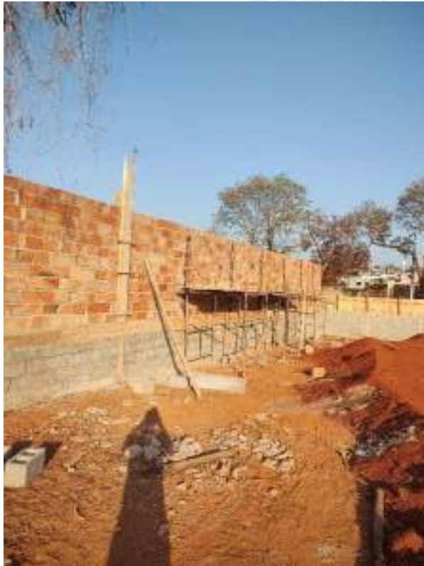
Foto 151 – Execução de muro de divisa
