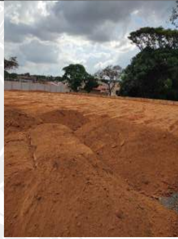
Foto 246 – Execução de aterro compactado
