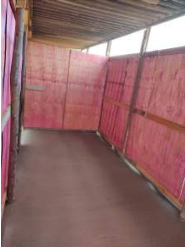
Foto 41 – Acerto e concretagem de piso dos barracões de obra
