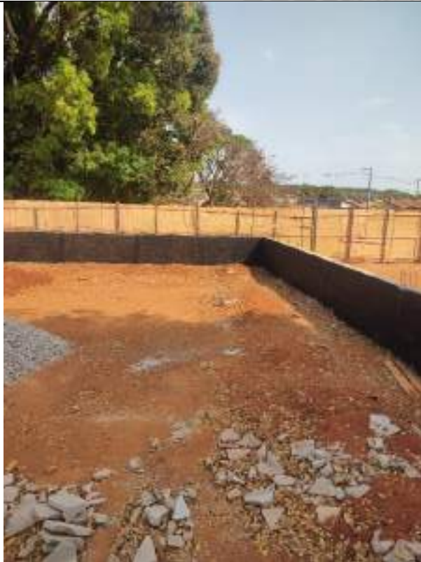
Foto 175 – Aplicação de impermeabilizante em muro de arrimo
