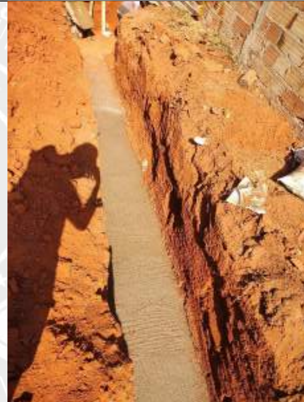
Foto 126 – Acerto de fundo de vala e concretagem de berço
