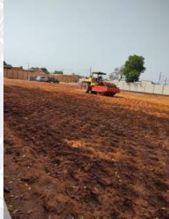
Foto 218 – Execução de compactação mecanizada do aterro da obra
