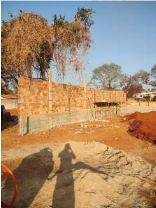
Foto 147 – Execução de muro de divisa
