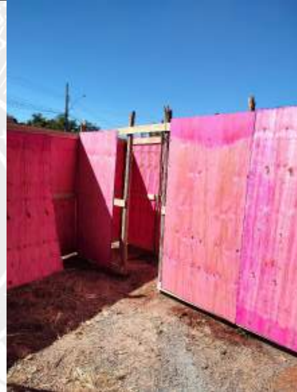
Foto 14 – Execução de barracão de obra com sanitário e depósito
