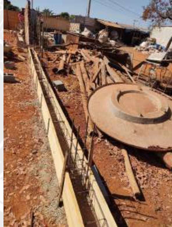
Foto 104 – Armação e concretagem de cintas
