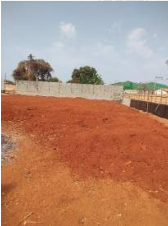
Foto 181 – Aplicação de impermeabilizante em muro de arrimo
