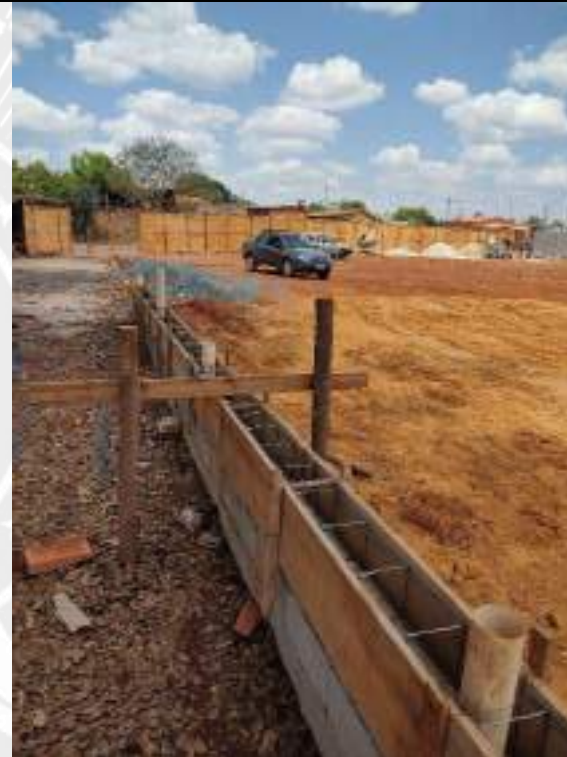
Foto 192 – Forma e concretagem de cintas
