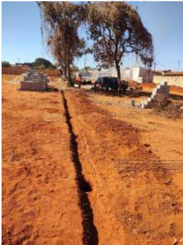
Foto 71 – Execução de fundação muro de arrimo
