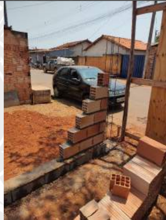
Foto 232 – Execução de muro de divisa
