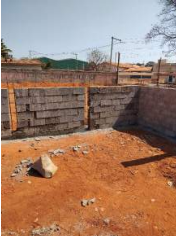
Foto 95 – Execução de rejunte em muro de arrimo
