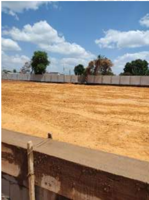
Foto 205 – Forma e concretagem de cintas
