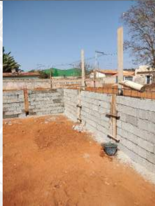
Foto 88 – Execução de muro de arrimo e concretagem de pilares
