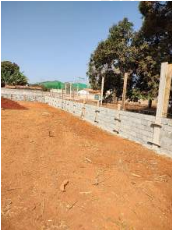
Foto 85 – Execução de muro de arrimo e concretagem de pilares
