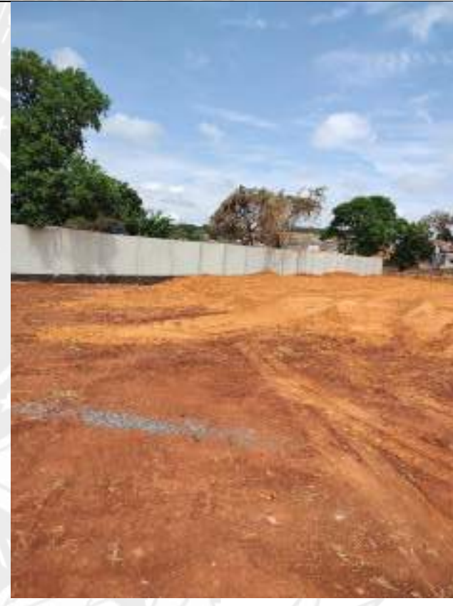
Foto 240 – Execução de aterro compactado
