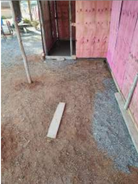
Foto 43 - Acerto e concretagem de piso dos barracões de obra
