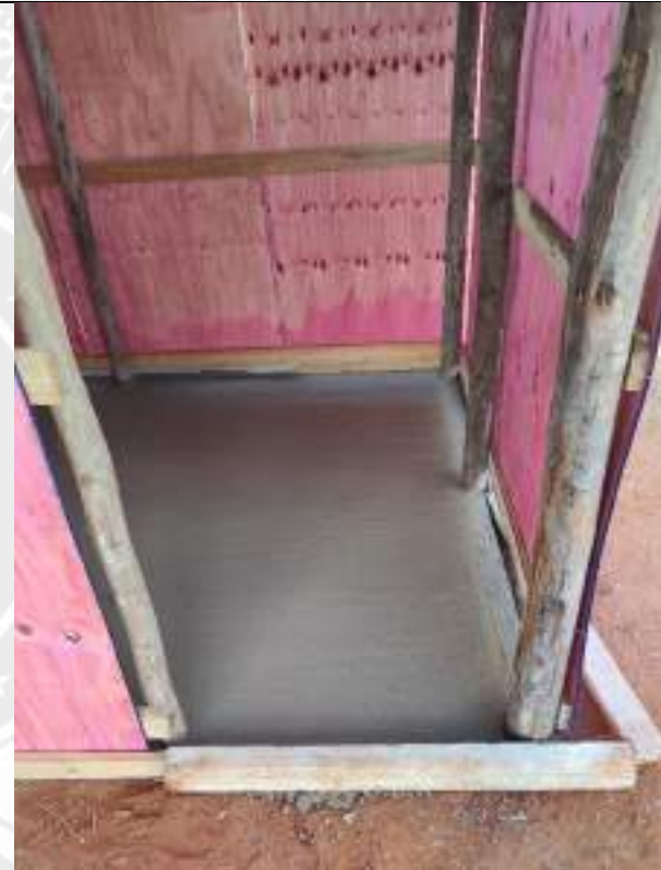
Foto 42 - Acerto e concretagem de piso dos barracões de obra
