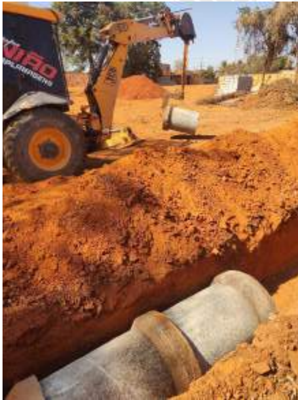
Foto 131 – Assentamento de manilhas de 600mm
