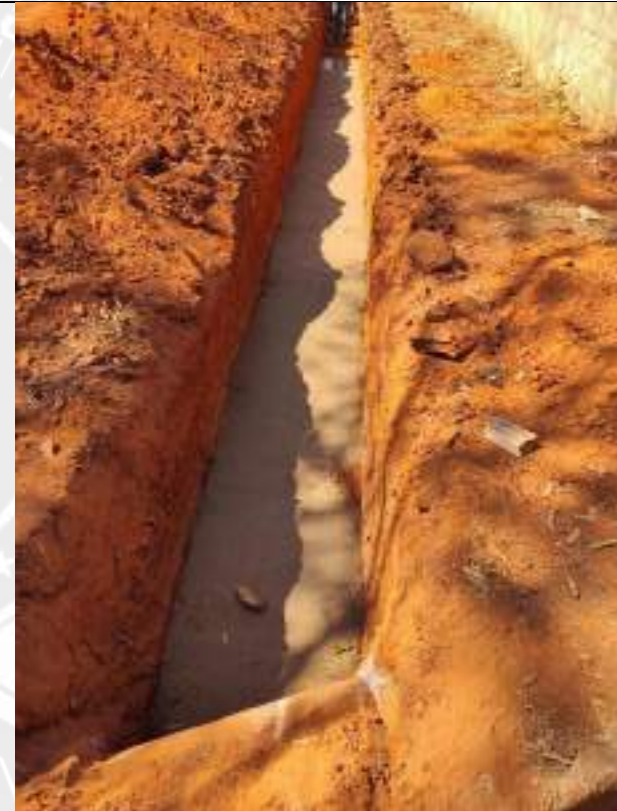
Foto 124 – Acerto de fundo de vala e concretagem de berço
