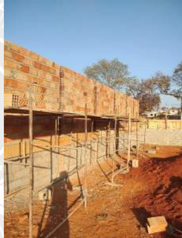
Foto 152 – Execução de muro de divisa
