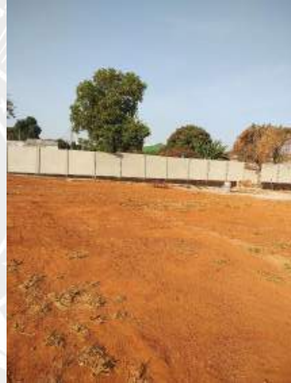
Foto 182 – Aplicação de impermeabilizante em muro de arrimo
