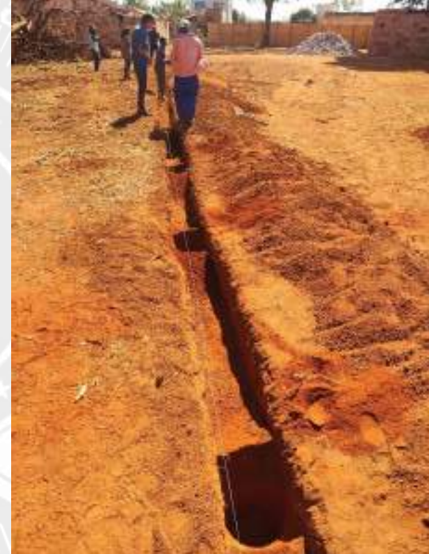
Foto 80 – Execução de fundação muro de arrimo
