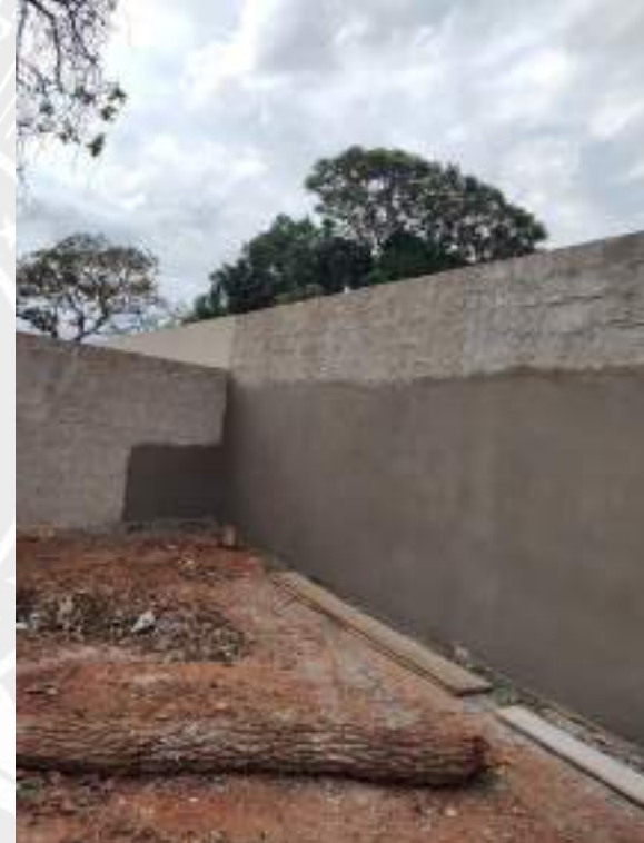
Foto 264 – Reboco dos muros de divisa
