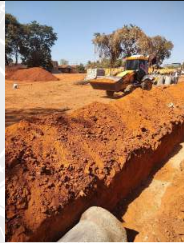
Foto 130 – Assentamento de manilhas de 600mm
