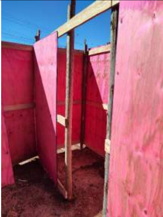
Foto 15 - Execução de sanitário do barracão de obra
