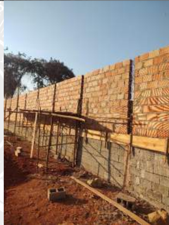
Foto 158 – Execução de muro de divisa
