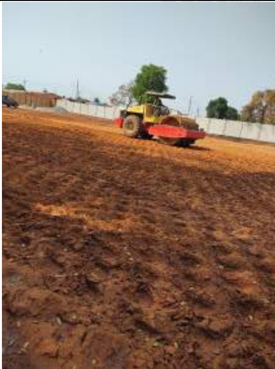
Foto 213 – Execução de compactação mecanizada do aterro da obra
