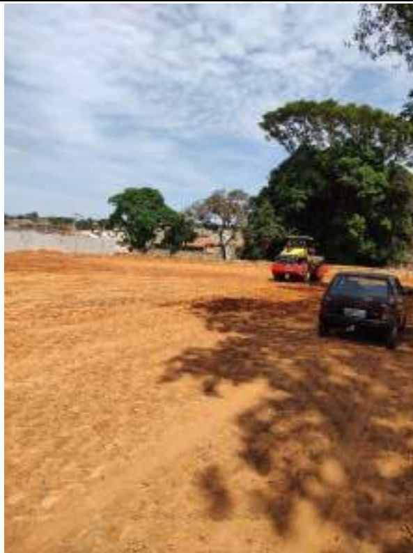
Foto 257 – Execução de aterro compactado
