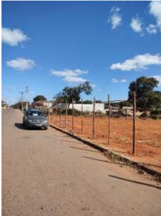
Foto 5 - Execução de tapume para fechamento de obra
