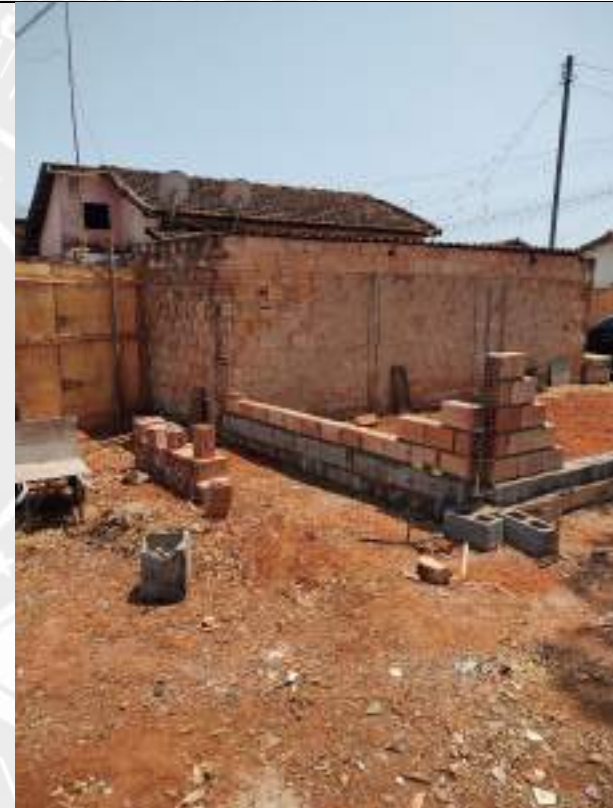
Foto 230 – Execução de muro de divisa
