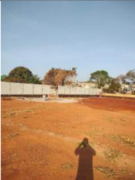
Foto 183 – Execução de chapisco e reboco do muro de divisa
