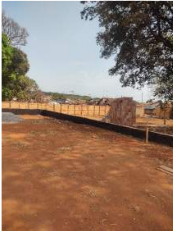
Foto 173 – Aplicação de impermeabilizante em muro de arrimo
