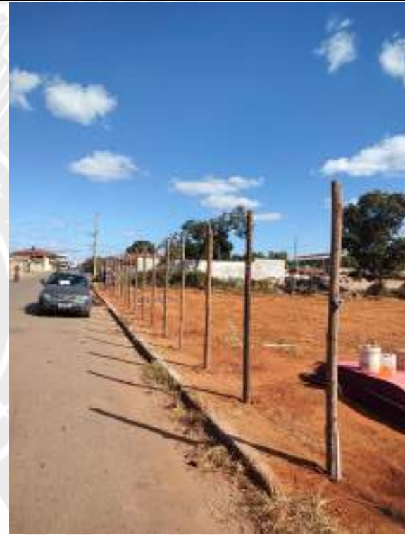
Foto 2 – Execução de tapume para fechamento de obra
