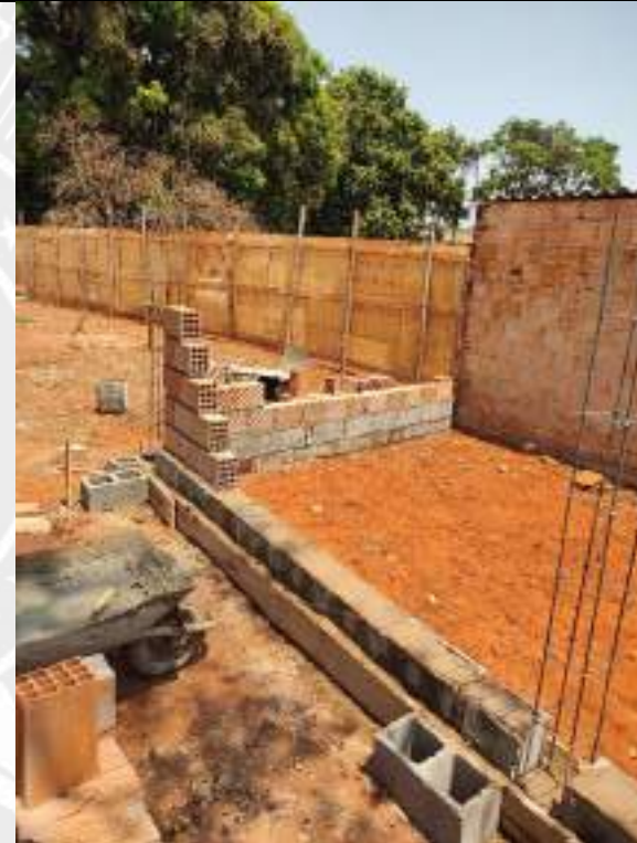
Foto 234 – Execução de muro de divisa
