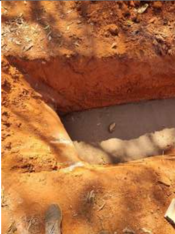
Foto 123 – Acerto de fundo de vala e concretagem de berço
