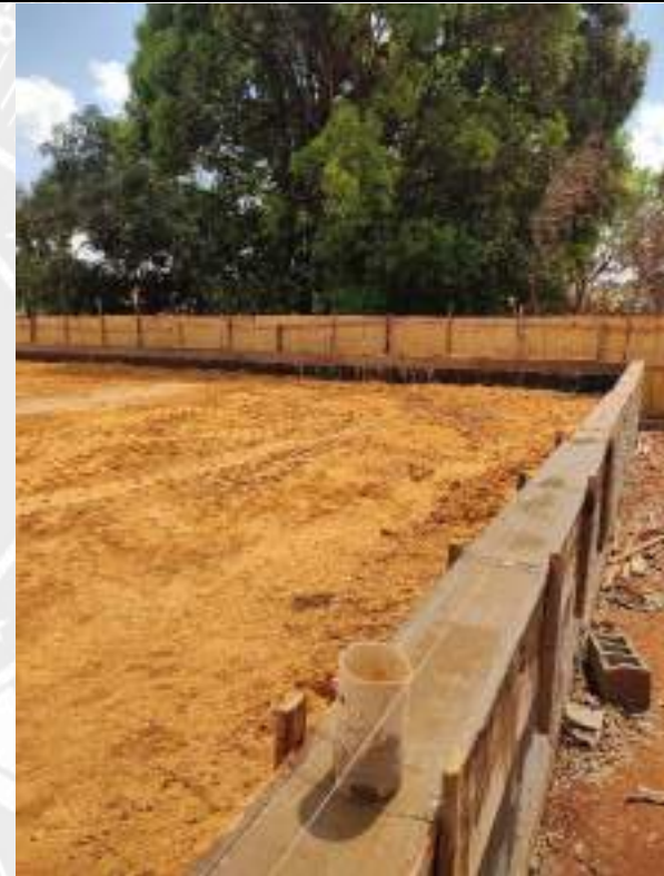
Foto 196 – Forma e concretagem de cintas
