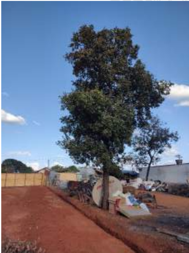
Foto 65 – Execução de ligações hidrossanitárias
