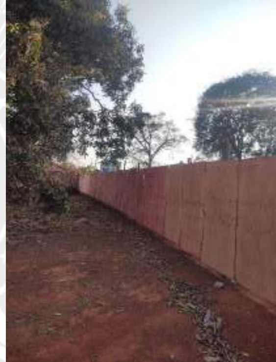
Foto 166 – Execução de tapume de fechamento de obra
