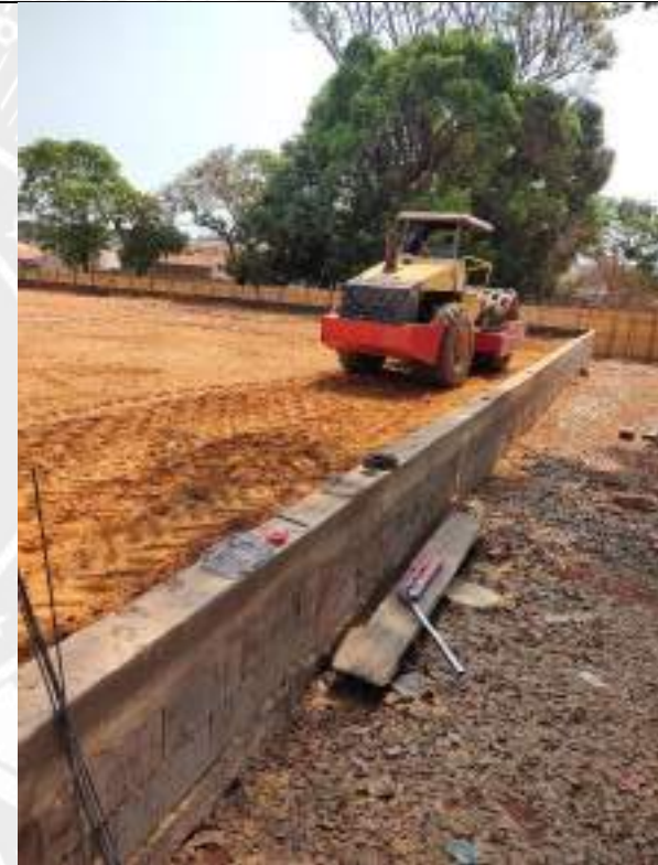
Foto 210 – Execução de compactação mecanizada do aterro da obra
