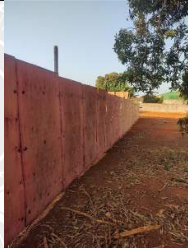
Foto 168 – Execução de tapume de fechamento de obra
