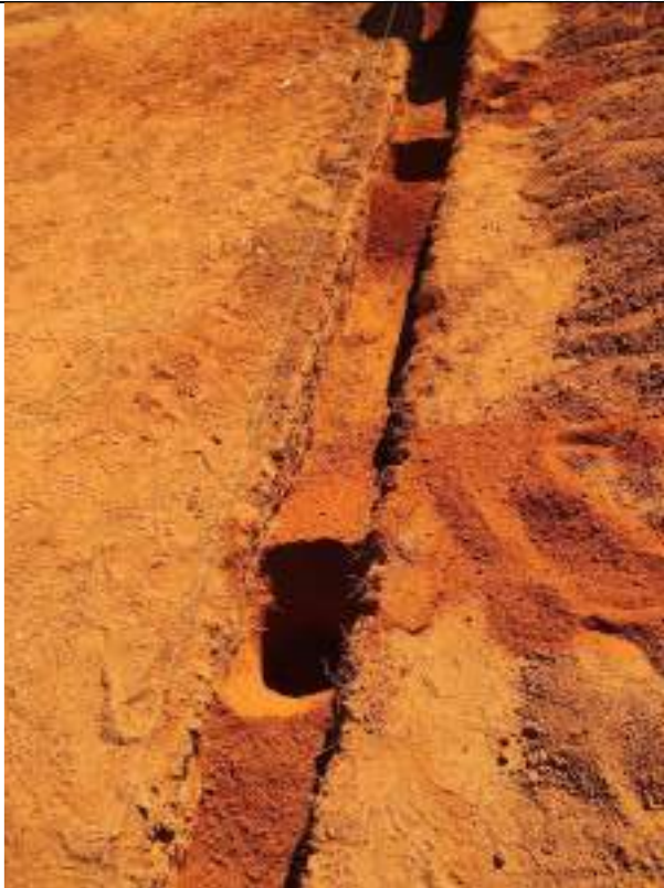
Foto 69 – Execução de fundação muro de arrimo
