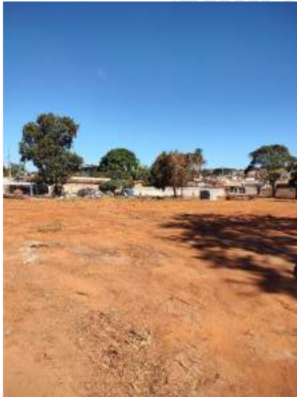
Foto 21 – Limpeza e remoção de cerca de divisa
