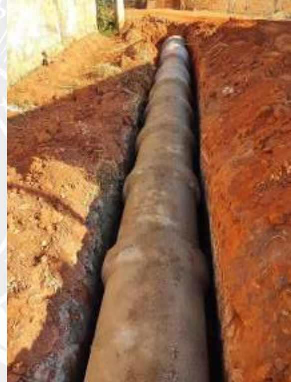
Foto 138 – Concretagem de “travesseiro” da rede de drenagem
