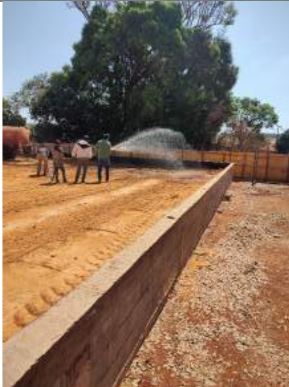
Foto 207 – Execução de umedecimento de aterro para compactação
