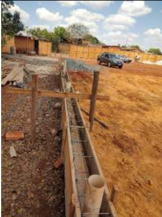
Foto 191 – Forma e concretagem de cintas
