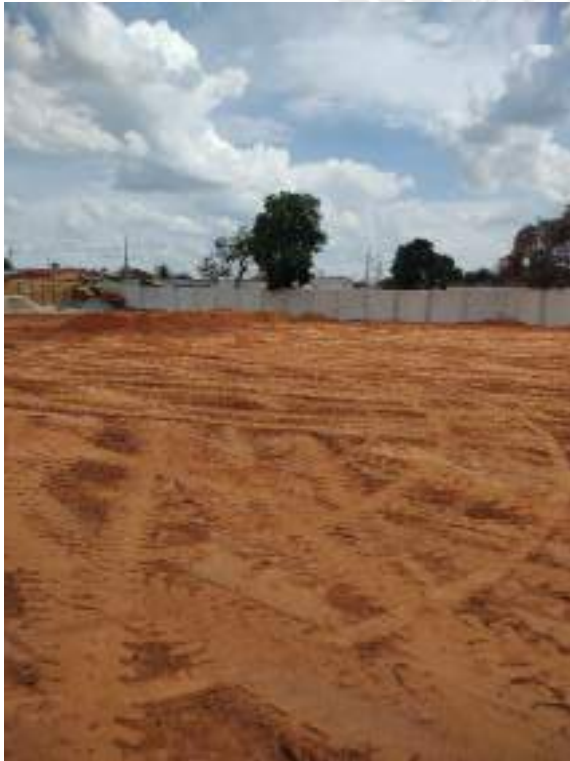
Foto 253 – Execução de aterro compactado
