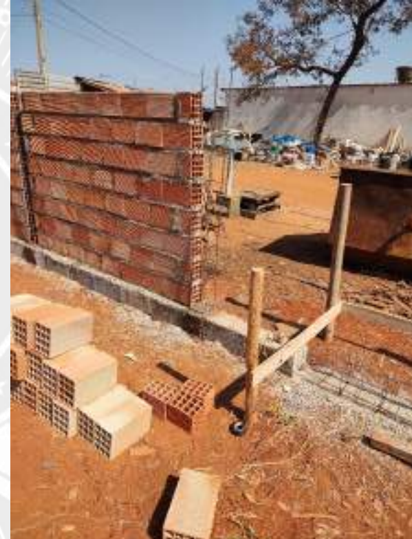
Foto 102 – Execução de muro de divisa
