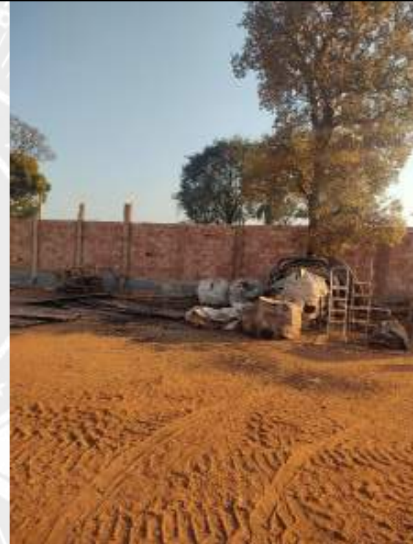
Foto 162 – Execução de muro de divisa
