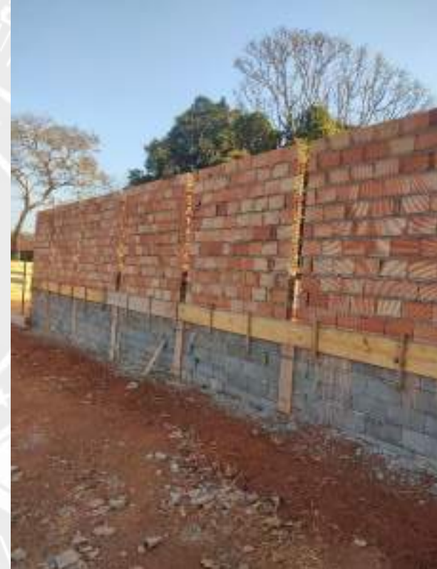
Foto 170 – Execução de muro de divisa
