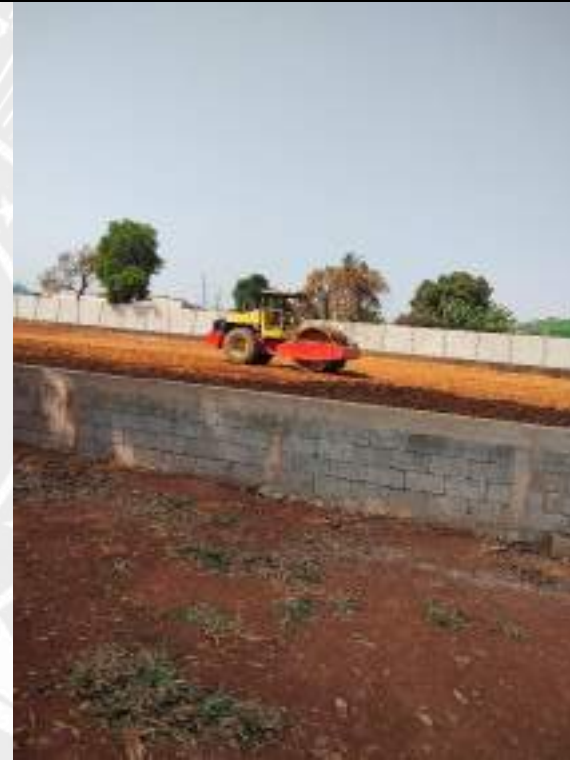
Foto 212 – Execução de compactação mecanizada do aterro da obra
