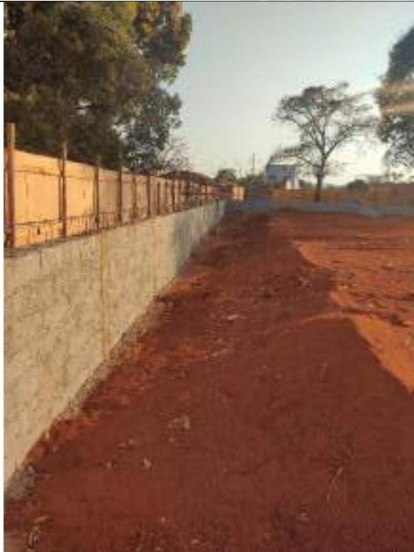
Foto 157 – Execução de aterro compactado da construção
