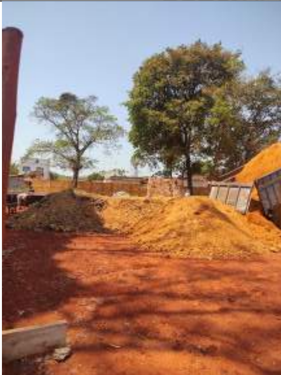
Foto 185 – Execução de aterro compactado da construção
