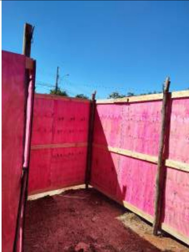
Foto 11 – Execução de barracão de obra com sanitário e depósito
