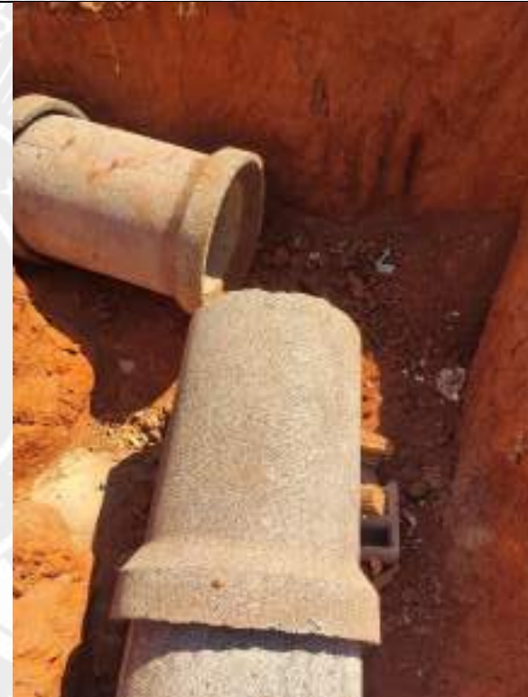
Foto 134 – Execução de caixa de drenagem
