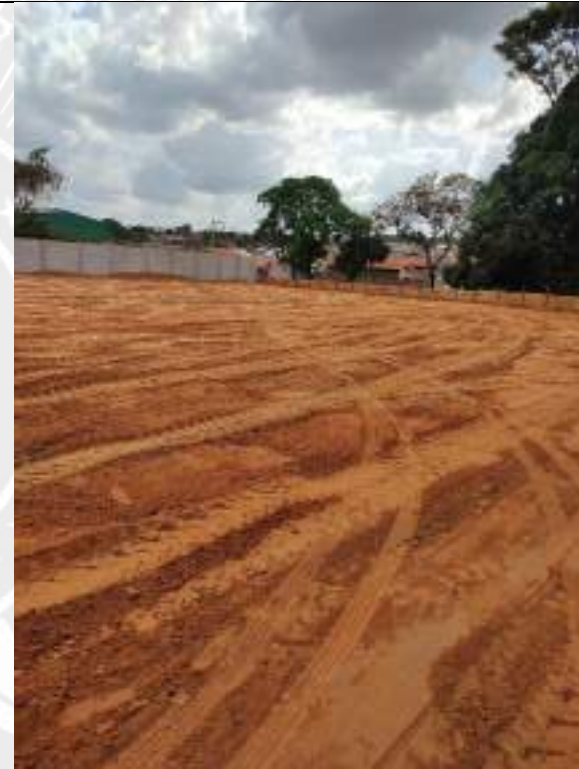
Foto 250 – Execução de aterro compactado
