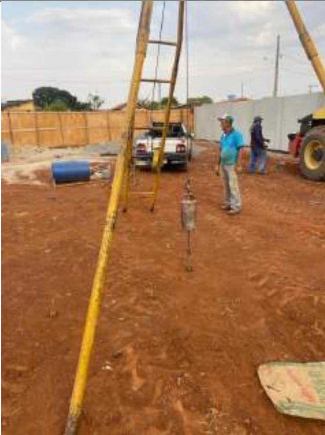
Foto 239 – Execução de furos de sondagem
