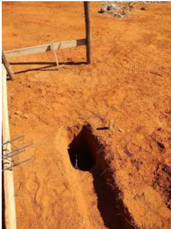
Foto 75 – Execução de fundação muro de arrimo
