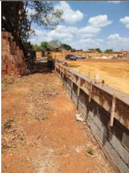
Foto 203 – Forma e concretagem de cintas
