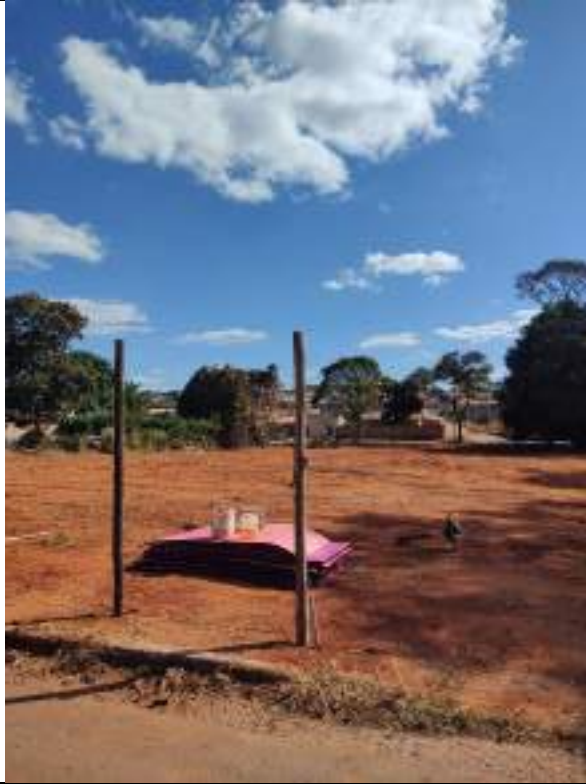
Foto 3 - Execução de tapume para fechamento de obra
