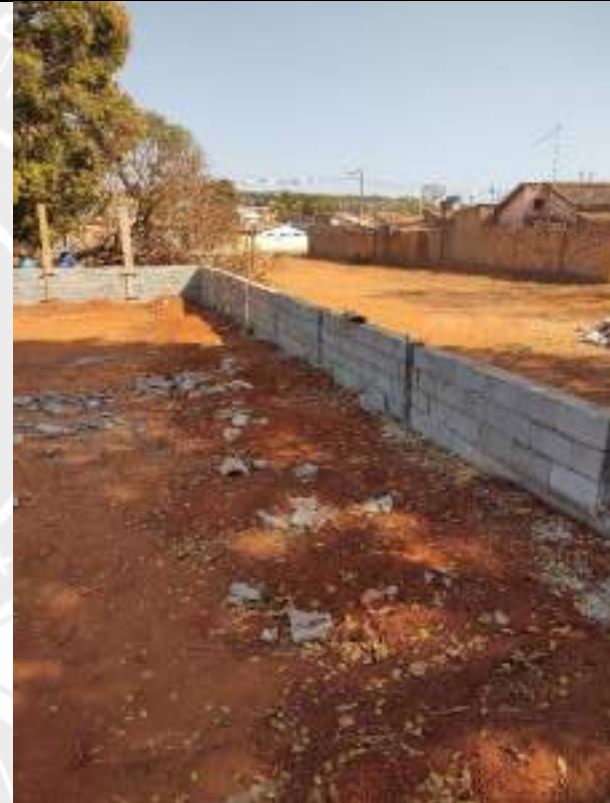
Foto 82 – Execução de muro de arrimo
