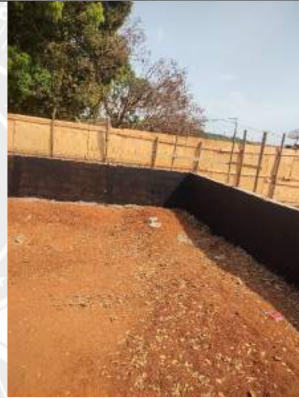
Foto 176 – Aplicação de impermeabilizante em muro de arrimo
