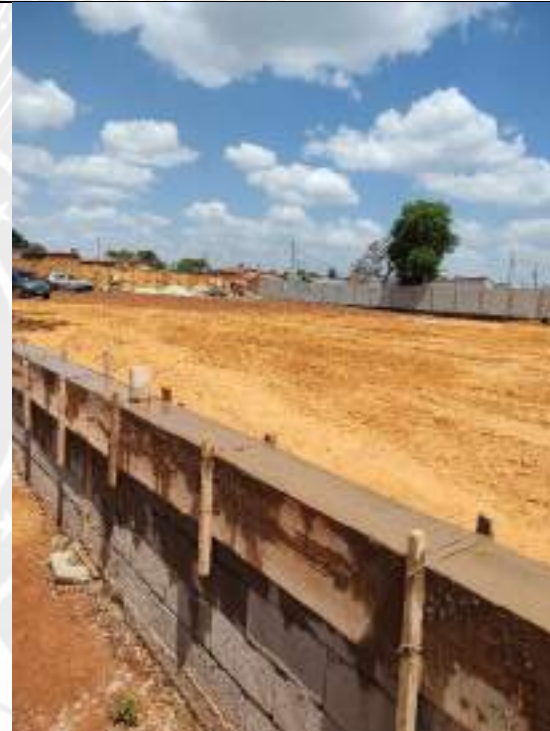
Foto 204 – Forma e concretagem de cintas
