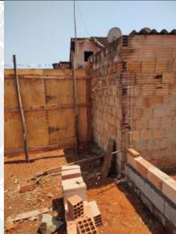
Foto 236 – Execução de muro de divisa
