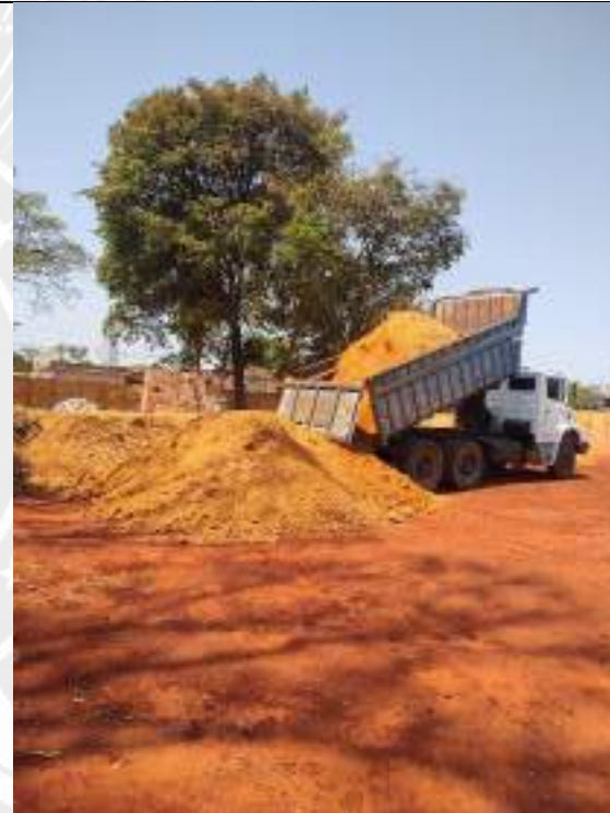
Foto 184 – Execução de aterro compactado da construção
