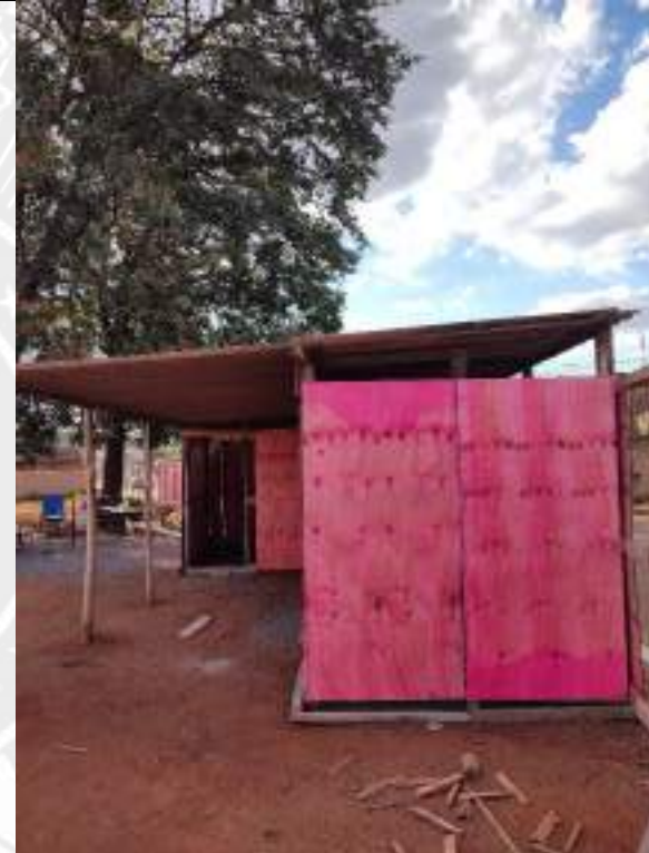
Foto 38 - Execução de telhado do barracão de obra
