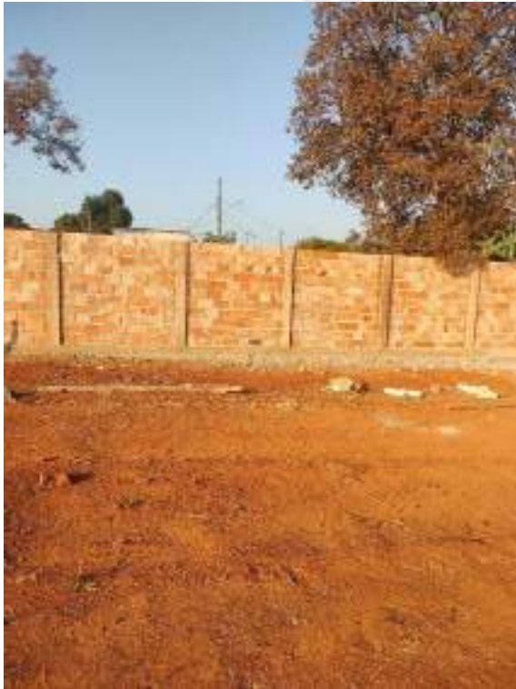
Foto 115 – Execução de muro de divisa
