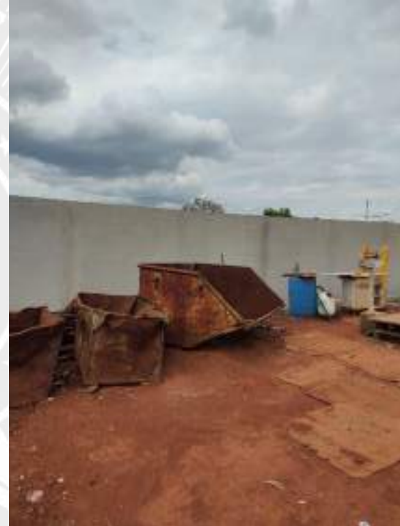
Foto 268 – Reboco dos muros de divisa
