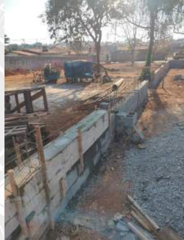
Foto 112 – Forma e concretagem de cintas e pilares
