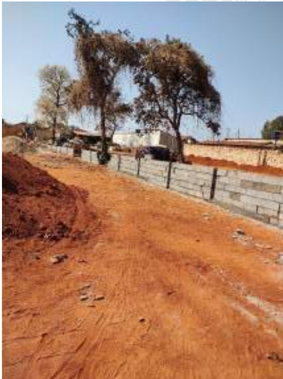
Foto 91 – Execução de muro de arrimo e concretagem de pilares
