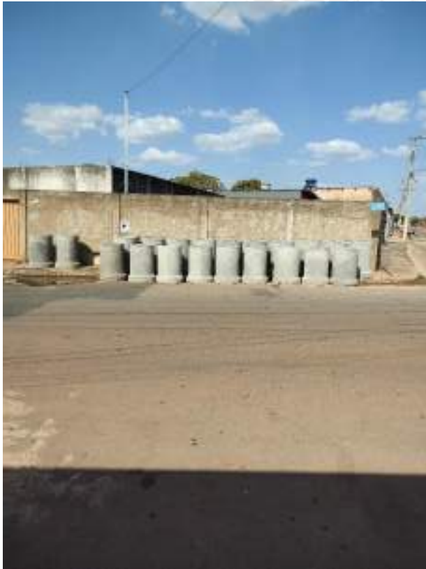
Foto 127 – Execução de rede de drenagem de 600mm
