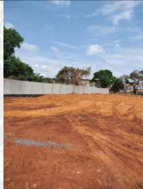
Foto 244 – Execução de aterro compactado
