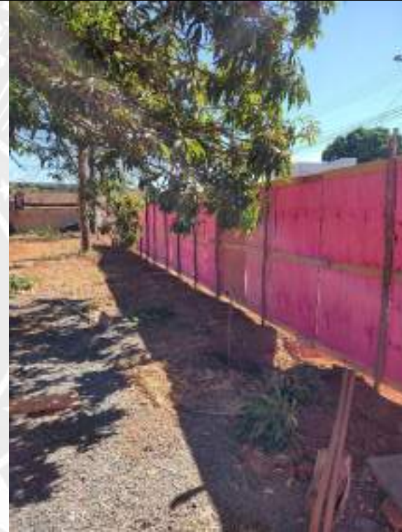
Foto 16 – Execução de tapume para fechamento de obra
