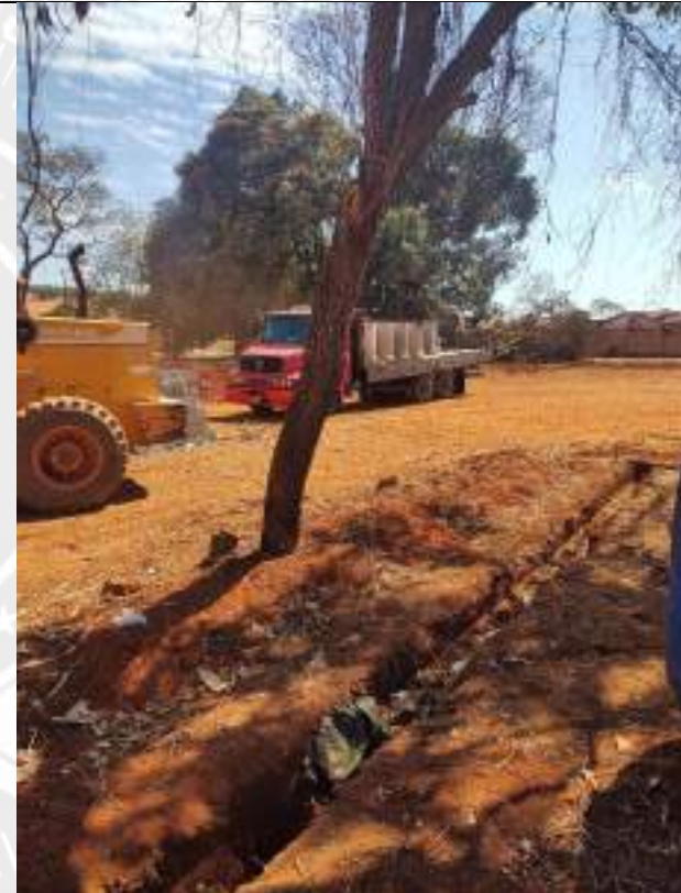
Foto 118 – Execução de rede de drenagem de 600mm
