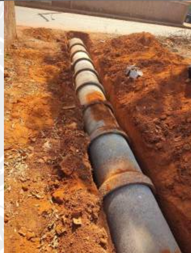
Foto 128 – Assentamento de manilhas de 600mm
