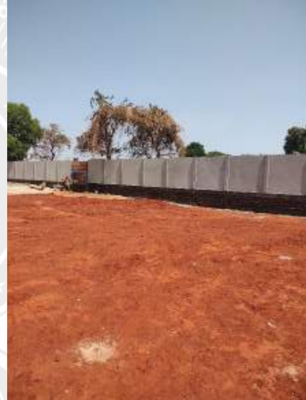
Foto 188 – Chapisco e reboco do muro de divisa
