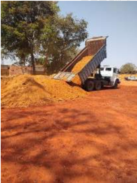
Foto 189 – Execução de aterro compactado da construção
