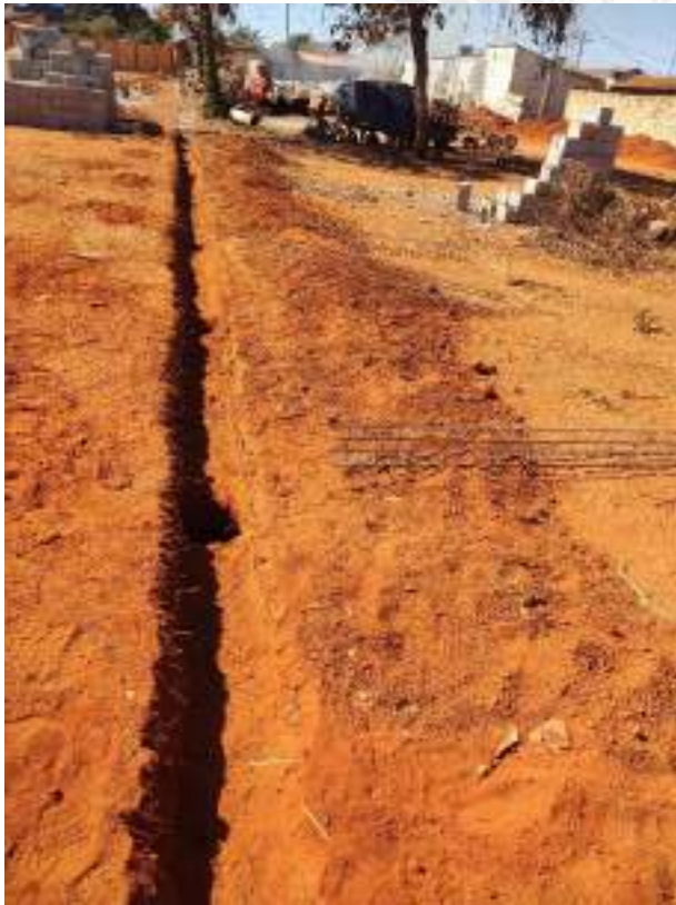
Foto 73 – Execução de fundação muro de arrimo
