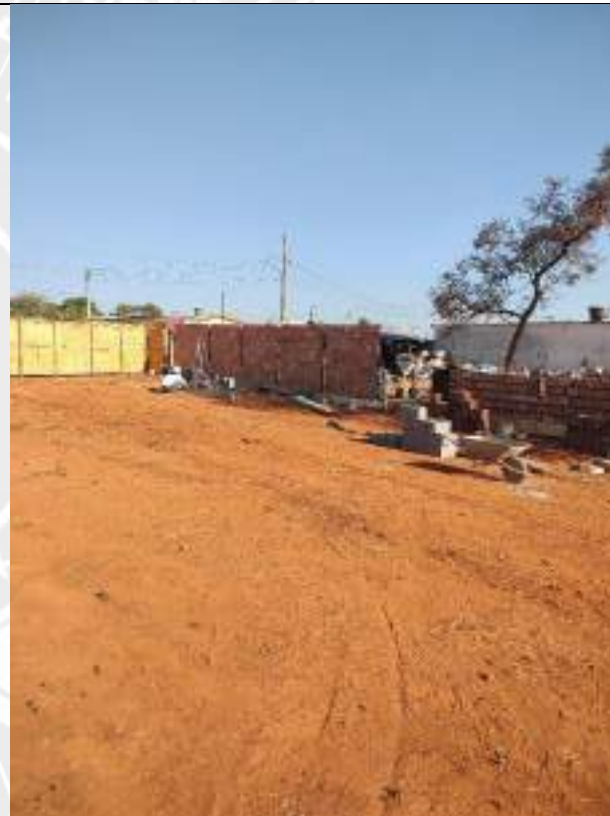
Foto 106 – Execução de muro de divisa
