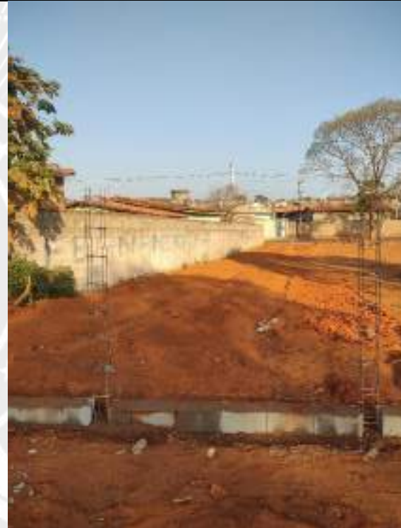
Foto 160 – Execução de fundação do muro de divisa
