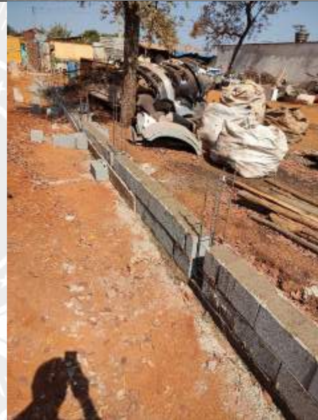
Foto 100 – Execução de muro de arrimo e concretagem de pilares
