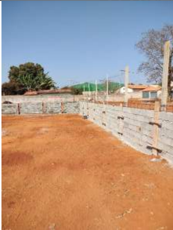
Foto 87 – Execução de muro de arrimo e concretagem de pilares
