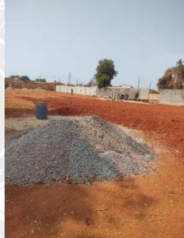
Foto 180 – Execução de chapisco e reboco do muro de divisa
