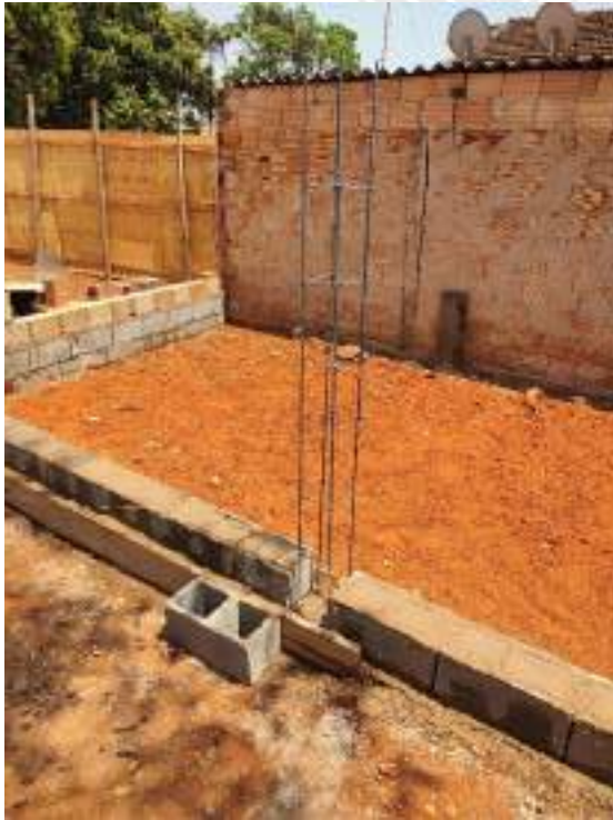
Foto 233 – Execução de muro de divisa
