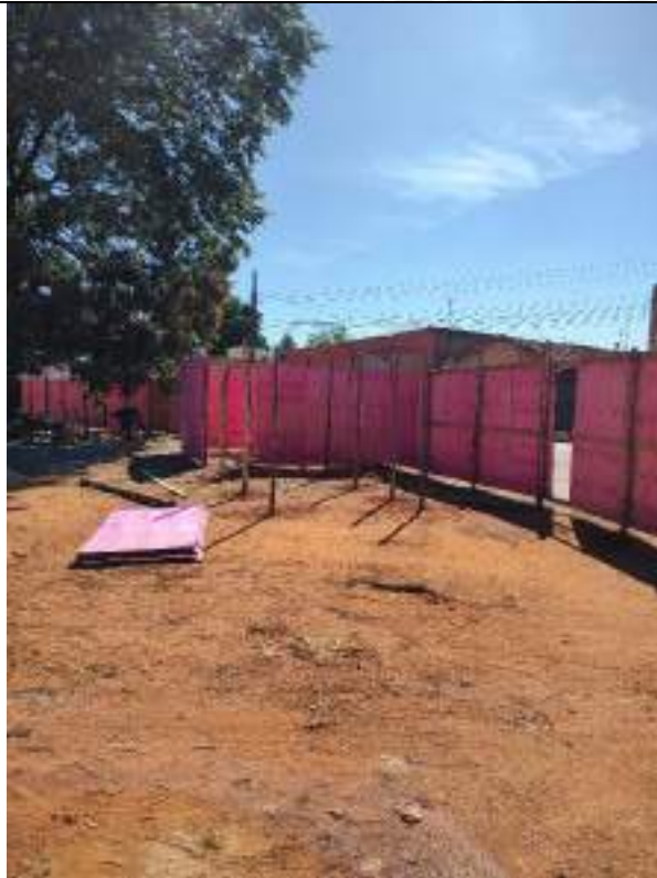
Foto 23 - Execução de barracão de obra
