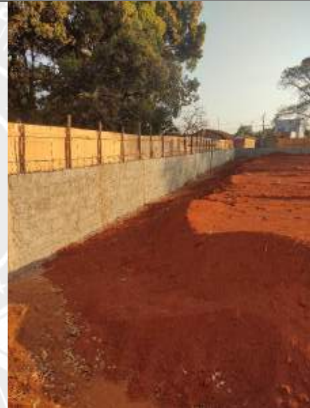
Foto 154 – Execução de aterro compactado da construção
