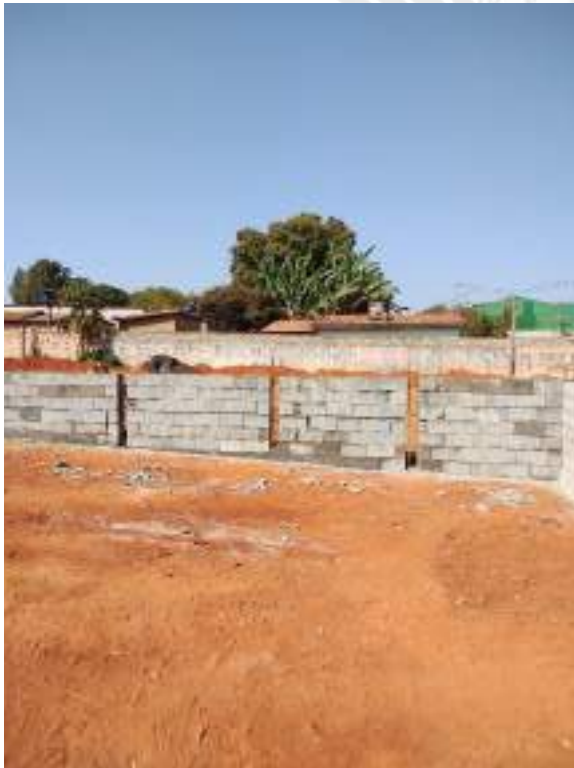
Foto 89 – Execução de muro de arrimo e concretagem de pilares
