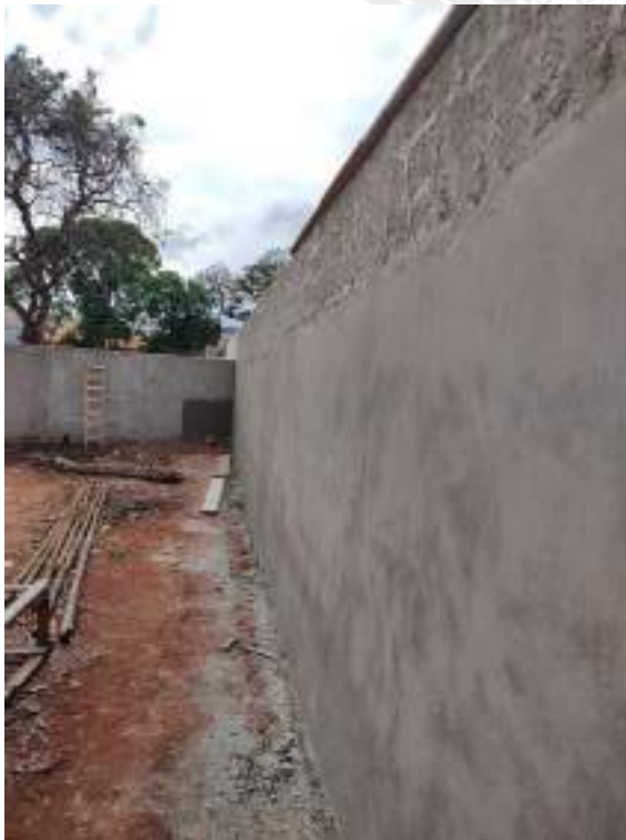
Foto 263 – Reboco dos muros de divisa
