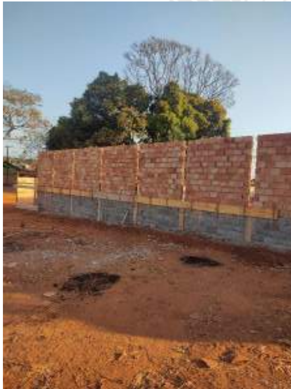
Foto 163 – Execução de muro de divisa
