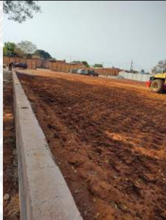
Foto 214 – Execução de compactação mecanizada do aterro da obra
