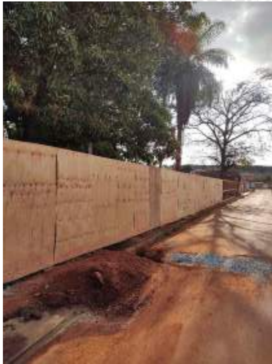
Foto 37 – Execução de tapume para fechamento de obra
