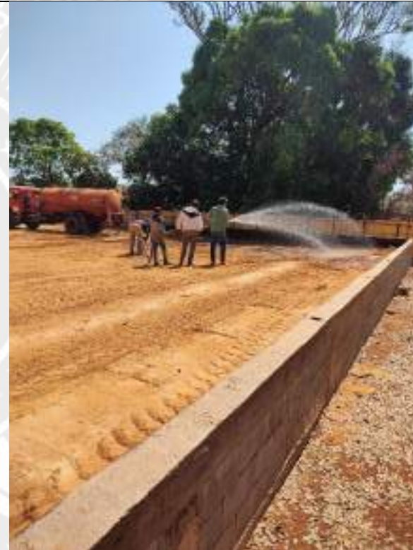
Foto 208 – Execução de umedecimento de aterro para compactação
