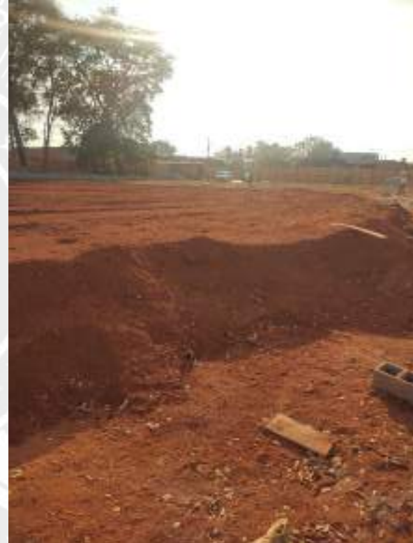
Foto 156 – Execução de aterro compactado da construção
