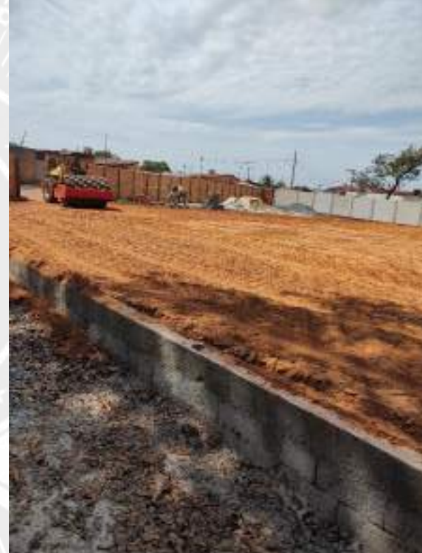
Foto 256 – Execução de aterro compactado
