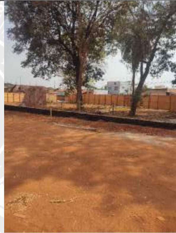
Foto 172 – Aplicação de impermeabilizante em muro de arrimo
