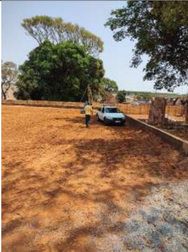
Foto 229 – Execução de furos de sondagem
