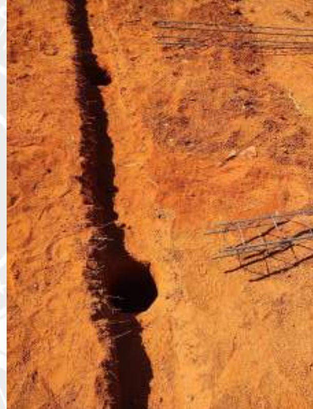
Foto 72 – Execução de fundação muro de arrimo
