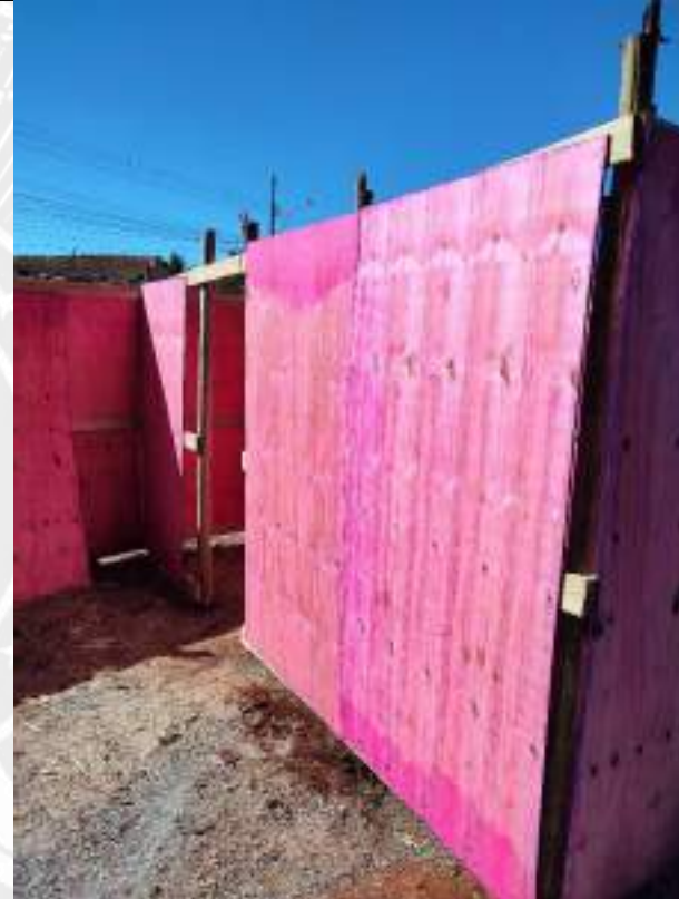
Foto 12 – Execução de barracão de obra com sanitário e depósito
