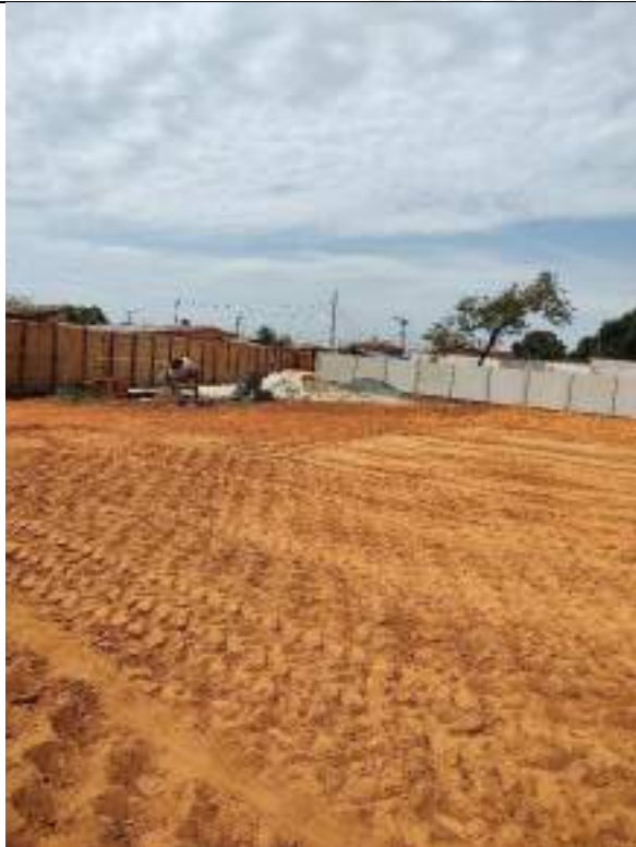
Foto 259 – Execução de aterro compactado
