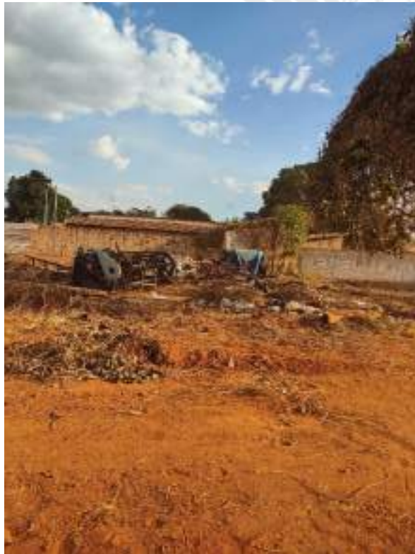
Foto 57 – Limpeza, corte e aterro para execução de terraplanagem
