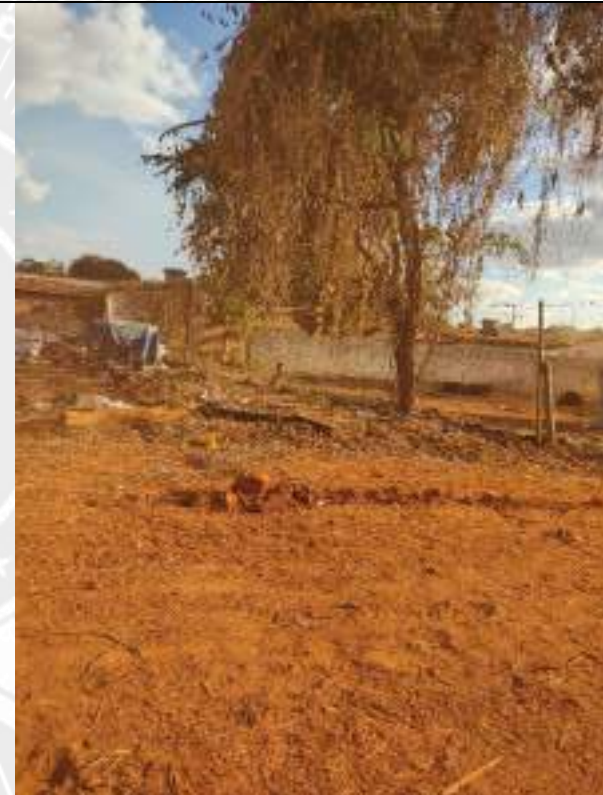
Foto 58 – Limpeza, corte e aterro para execução de terraplanagem
