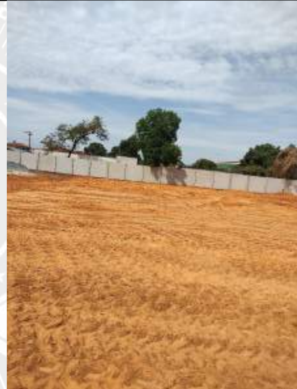
Foto 258 – Execução de aterro compactado
