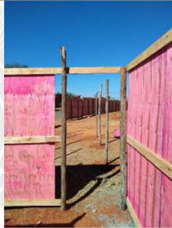
Foto 10 – Execução de barracão de obra com sanitário e depósito
