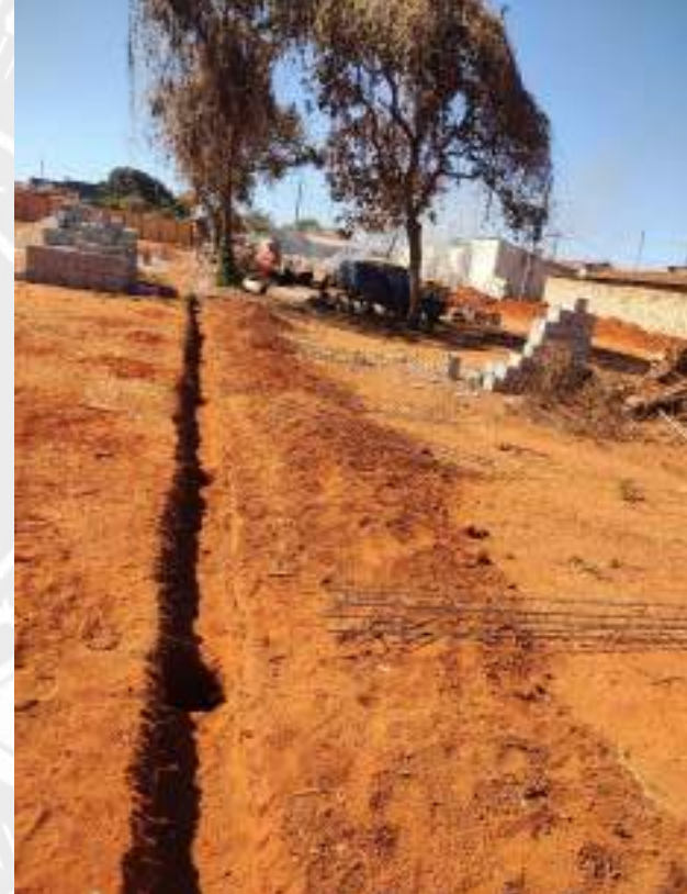
Foto 74 – Execução de fundação muro de arrimo
