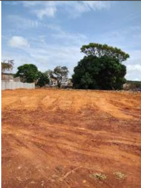
Foto 241 – Execução de aterro compactado
