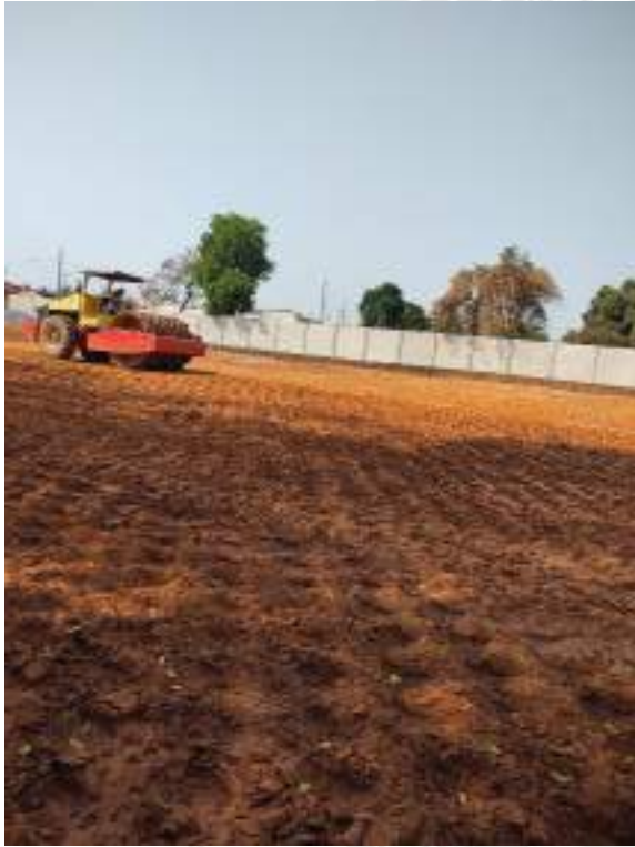
Foto 217 – Execução de compactação mecanizada do aterro da obra
