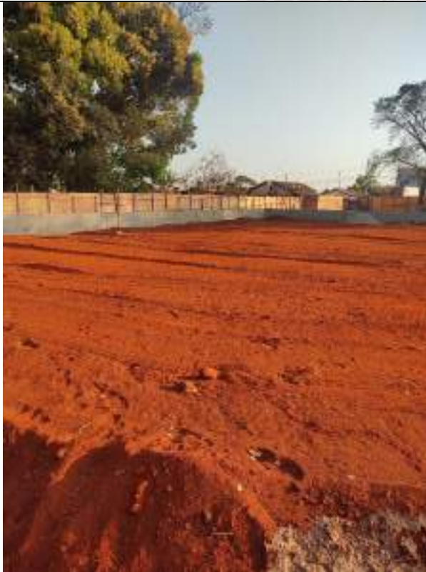
Foto 153 – Execução de aterro compactado da construção
