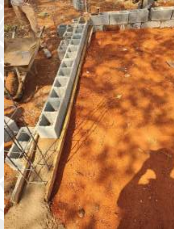
Foto 220 – Execução de fundação de muro de divisa
