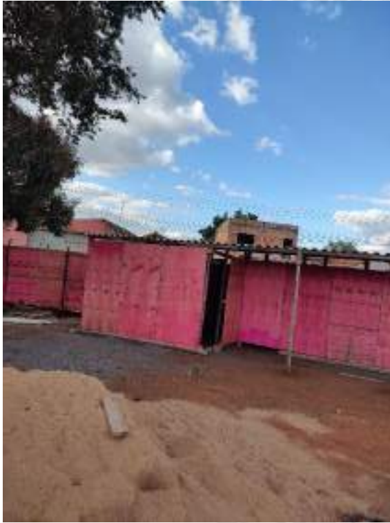
Foto 53 – Execução dos barracões de obra
