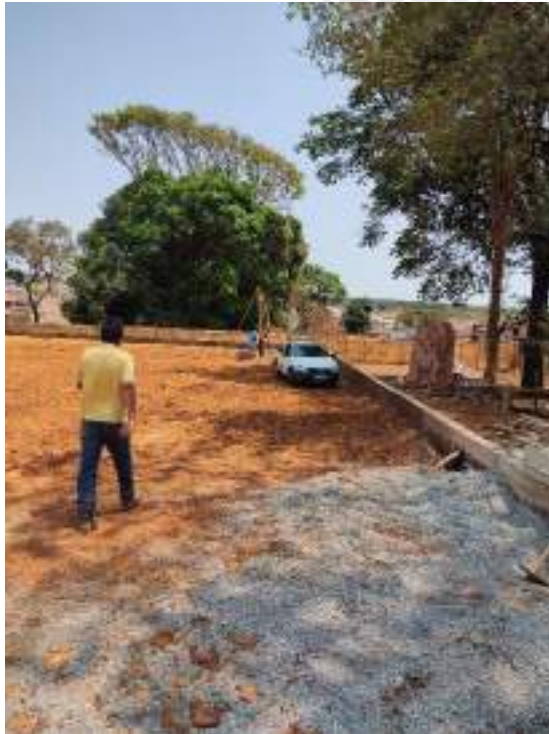
Foto 225 – Execução de furos de sondagem
