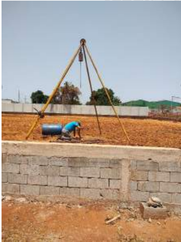
Foto 237 – Execução de furos de sondagem
