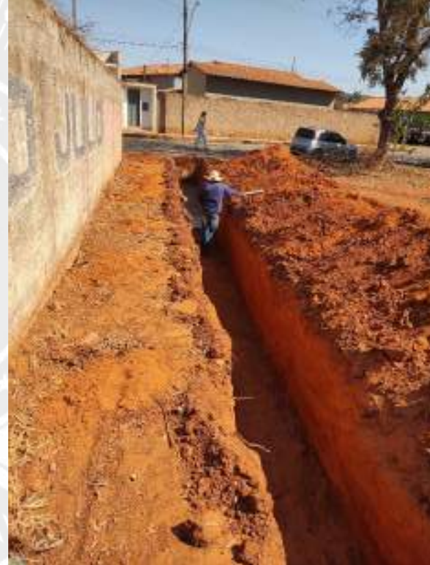
Foto 122 – Acerto de fundo de vala e concretagem de berço
