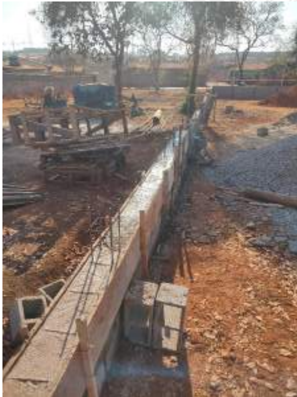
Foto 111 – Forma e concretagem de cintas e pilares
