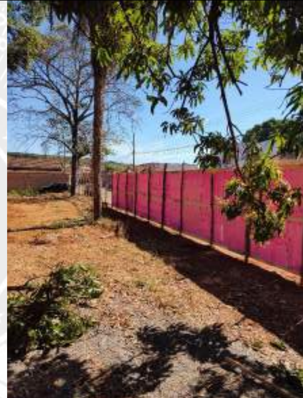
Foto 18 - Execução de tapume para fechamento de obra
