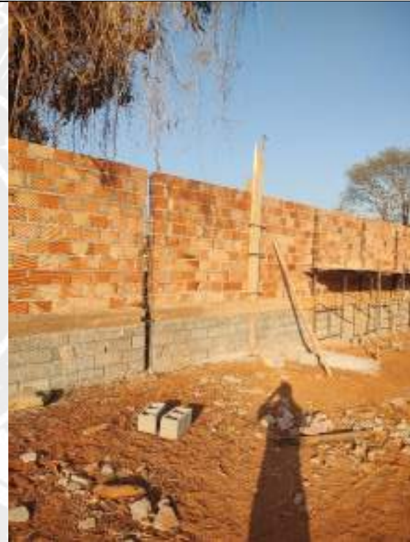
Foto 150 – Execução de muro de divisa
