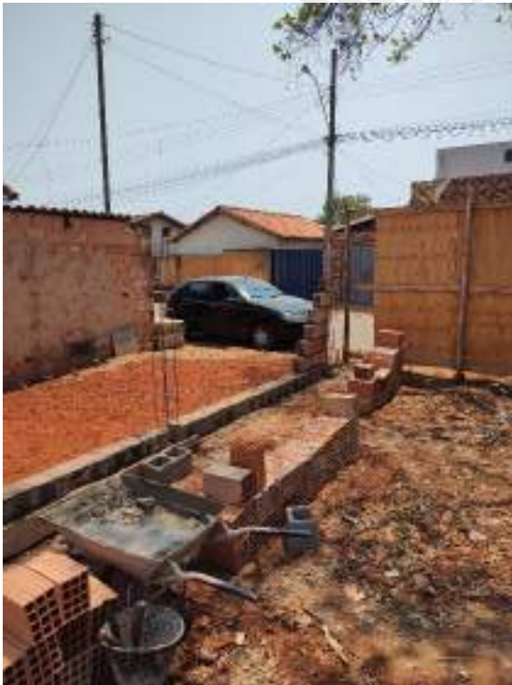
Foto 231 – Execução de muro de divisa
