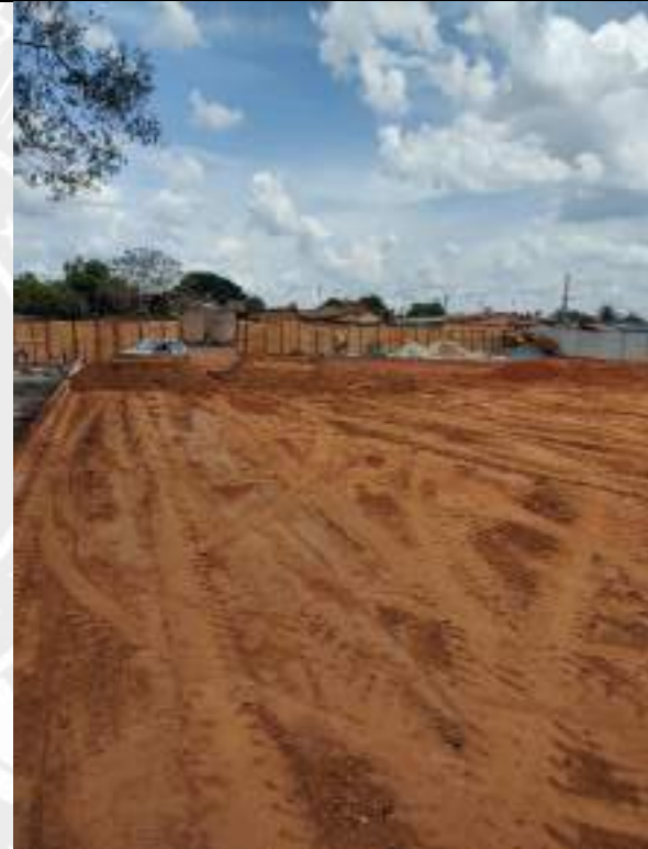
Foto 254 – Execução de aterro compactado
