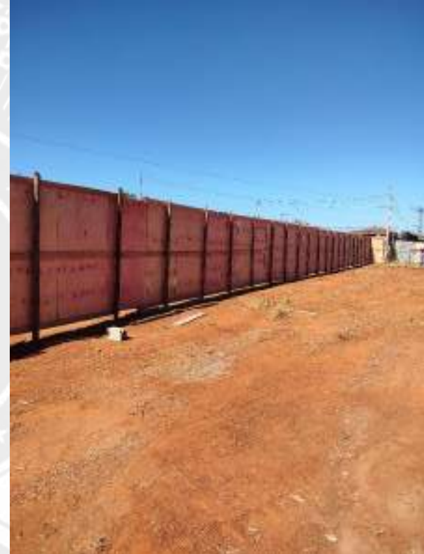
Foto 22 – Execução de tapume para fechamento de obra
