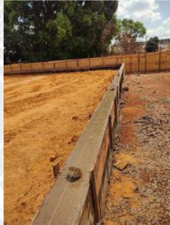
Foto 194 – Forma e concretagem de cintas
