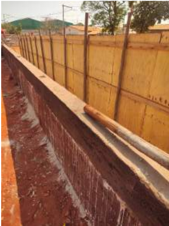
Foto 187 – Concretagem de cintas
