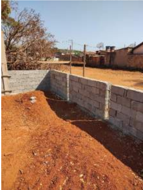
Foto 83 – Execução de muro de arrimo
