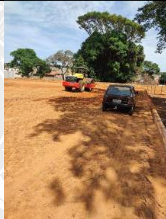
Foto 260 – Execução de aterro compactado
