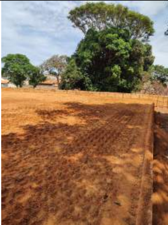
Foto 261 – Execução de aterro compactado
