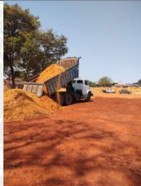
Foto 186 – Execução de aterro compactado da construção
