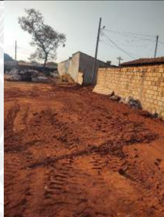
Foto 142 – Aterro compactado da rede de drenagem
