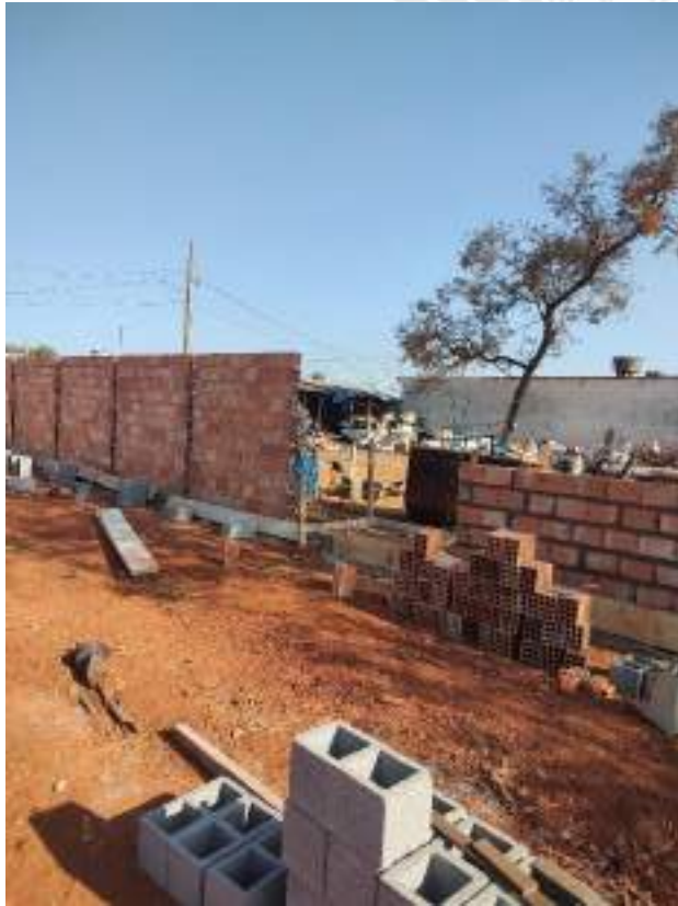
Foto 107 – Execução de muro de divisa
