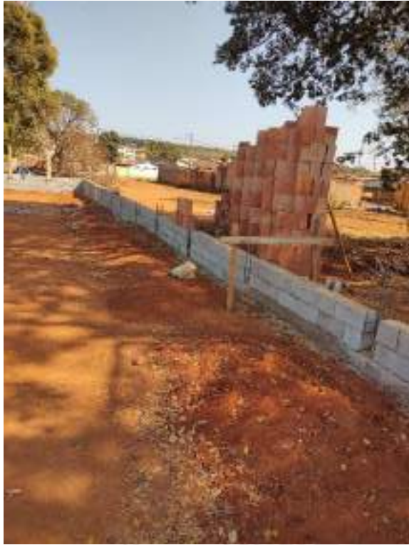
Foto 81 – Execução de muro de arrimo
