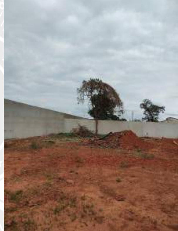
Foto 270 – Reboco dos muros de divisa
