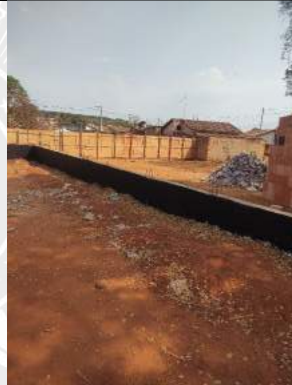
Foto 174 – Aplicação de impermeabilizante em muro de arrimo
