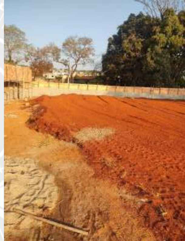
Foto 148 – Execução de aterro compactado da construção
