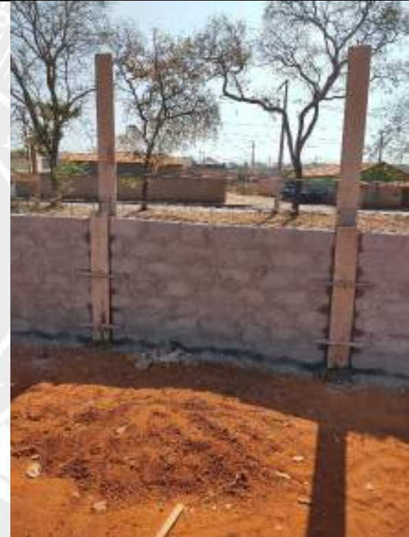
Foto 94 – Execução de rejunte em muro de arrimo
