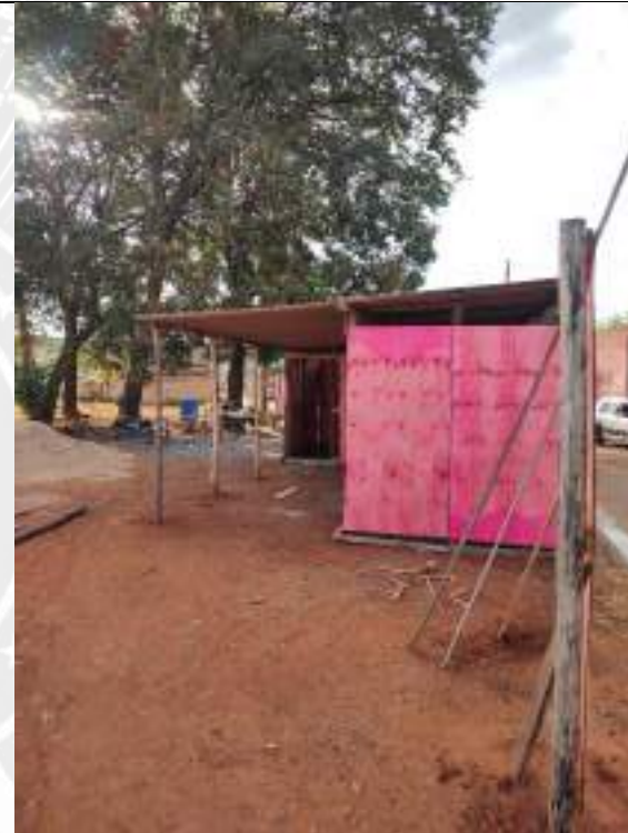
Foto 34 – Execução de telhado do barracão de obra
