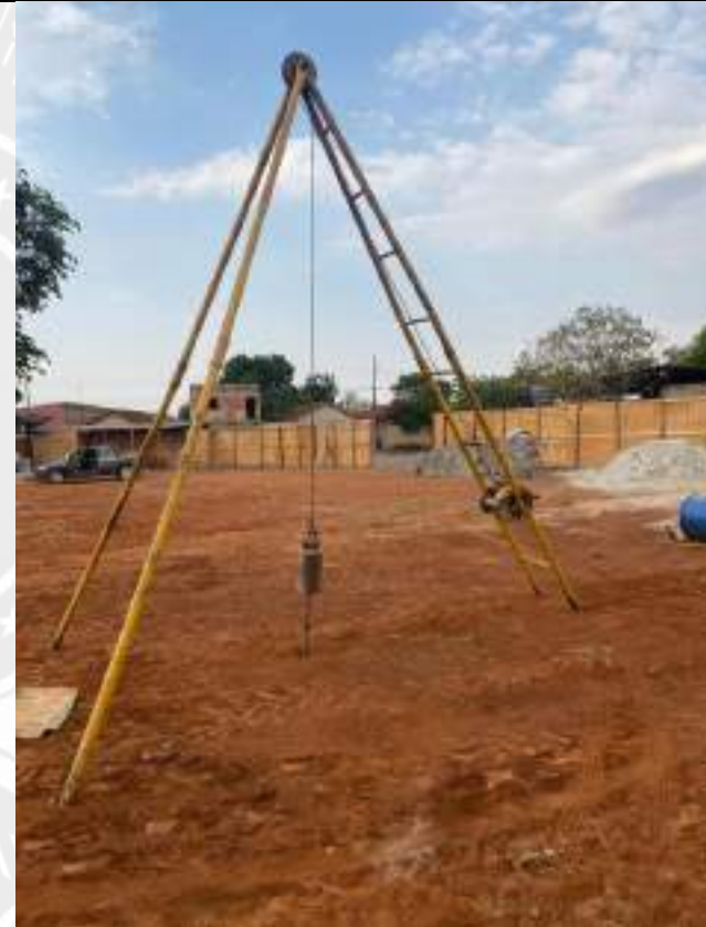
Foto 238 – Execução de furos de sondagem
