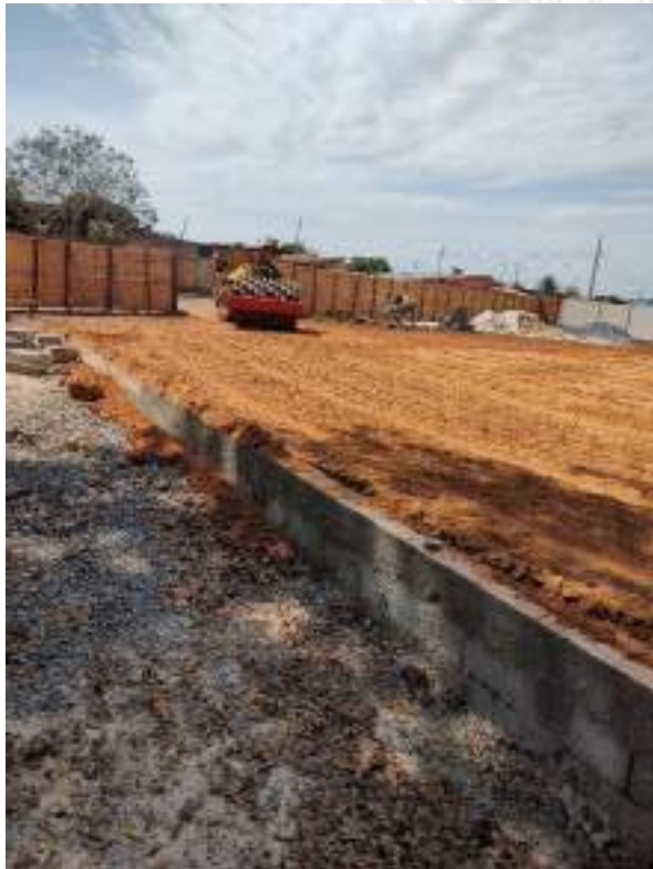
Foto 255 – Execução de aterro compactado
