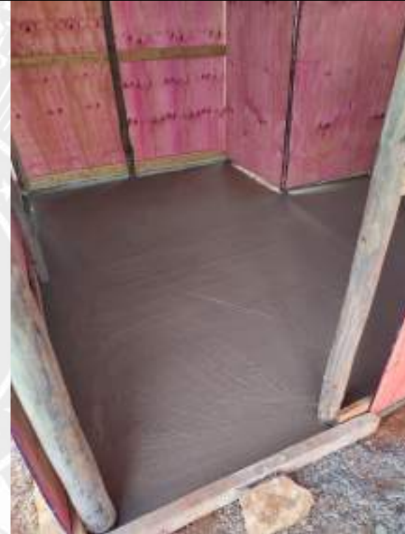
Foto 44 - Acerto e concretagem de piso dos barracões de obra
