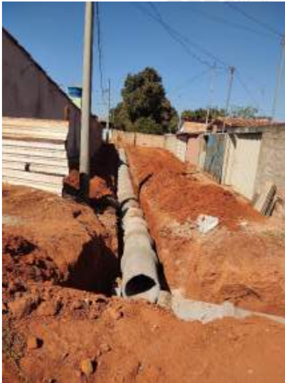
Foto 137 – Execução de rede de drenagem de 600mm
