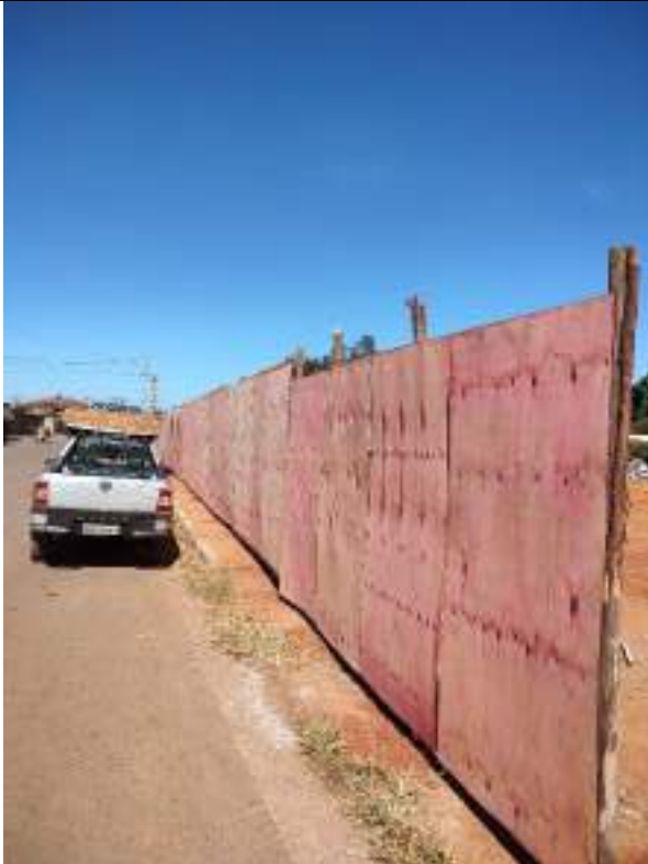
Foto 25 – Execução de tapume para fechamento de obra
