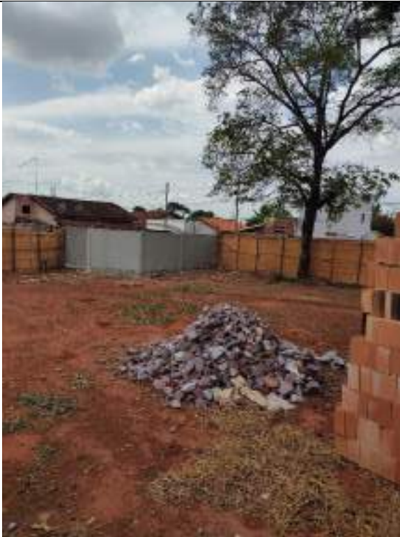
Foto 251 – Execução de muro de divisa
