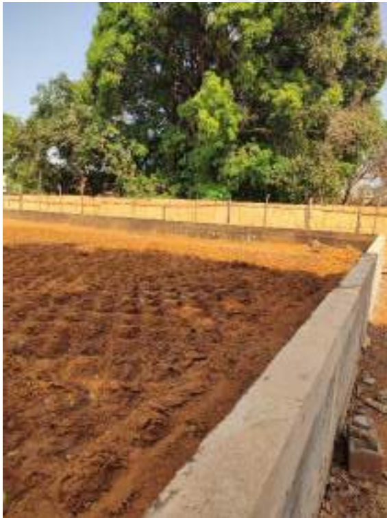
Foto 215 – Execução de compactação mecanizada do aterro da obra
