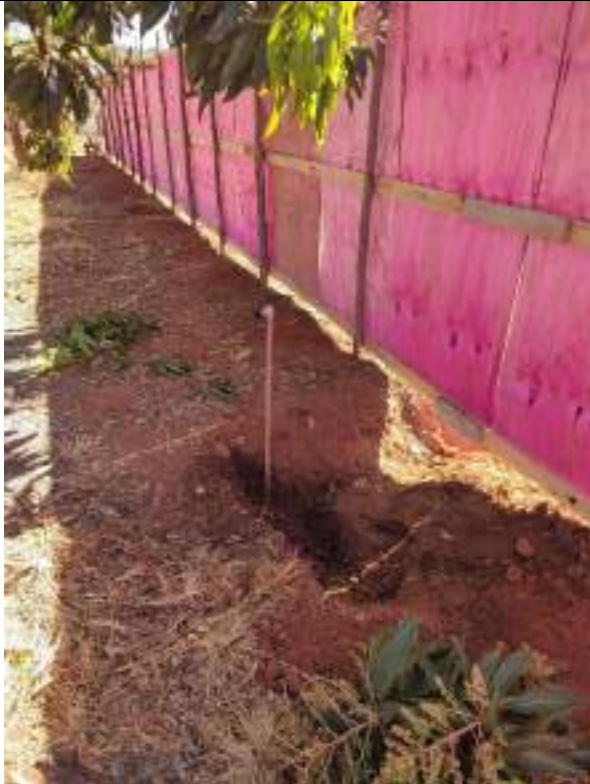
Foto 17 - Execução de ligação provisória de água
