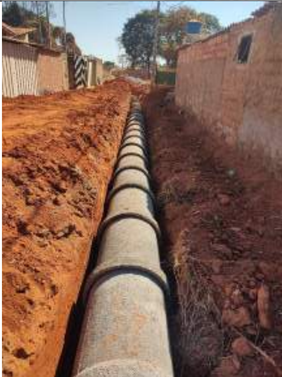
Foto 133 – Assentamento de manilhas de 600mm
