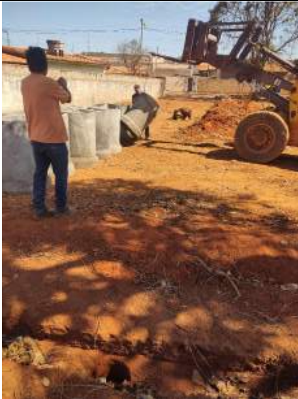
Foto 119 – Execução de rede de drenagem de 600mm
