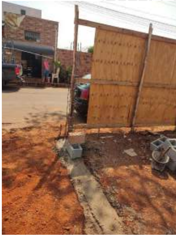
Foto 223 – Execução de fundação de muro de divisa
