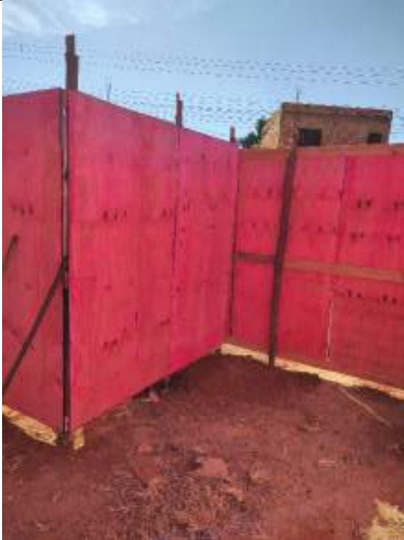
Foto 9 – Execução de barracão de obra com sanitário e depósito
