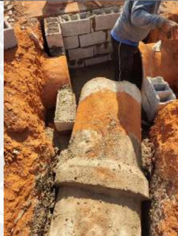
Foto 140 – Execução de caixa de drenagem
