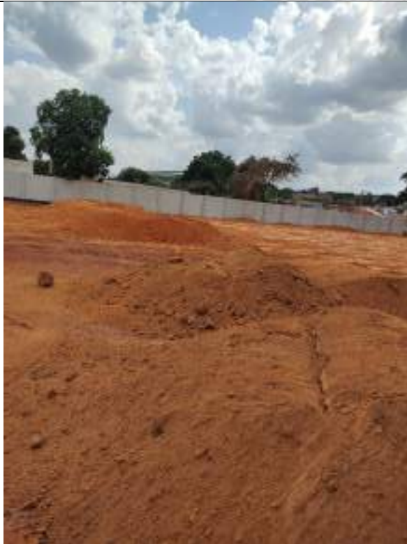
Foto 245 – Execução de aterro compactado
