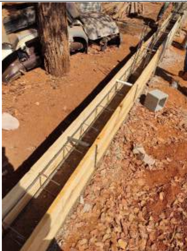
Foto 105 – Armação e concretagem de cintas
