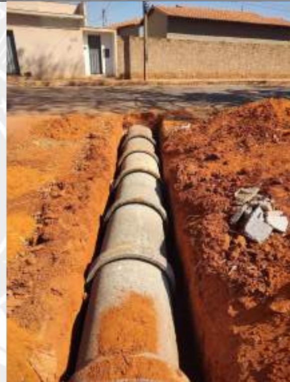
Foto 136 – Execução de rede de drenagem de 600mm
