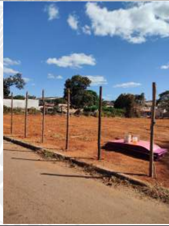
Foto 4 - Execução de tapume para fechamento de obra
