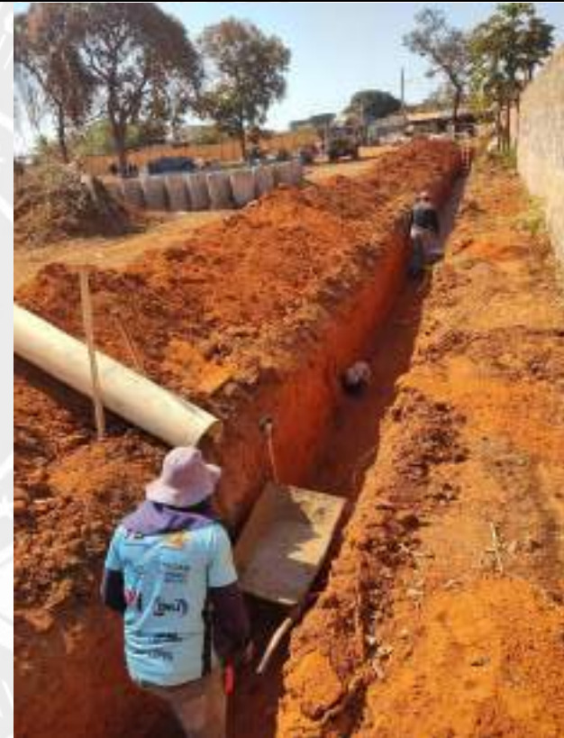
Foto 120 – Execução de rede de drenagem de 600mm
