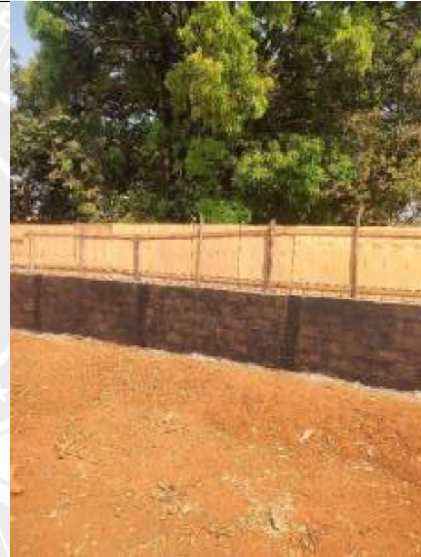
Foto 178 – Aplicação de impermeabilizante em muro de arrimo
