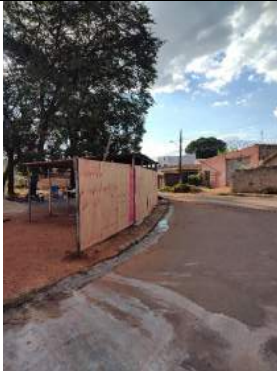
Foto 33 – Execução de tapume para fechamento de obra
