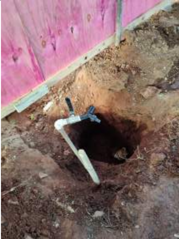
Foto 51 – Ligação provisória de água
