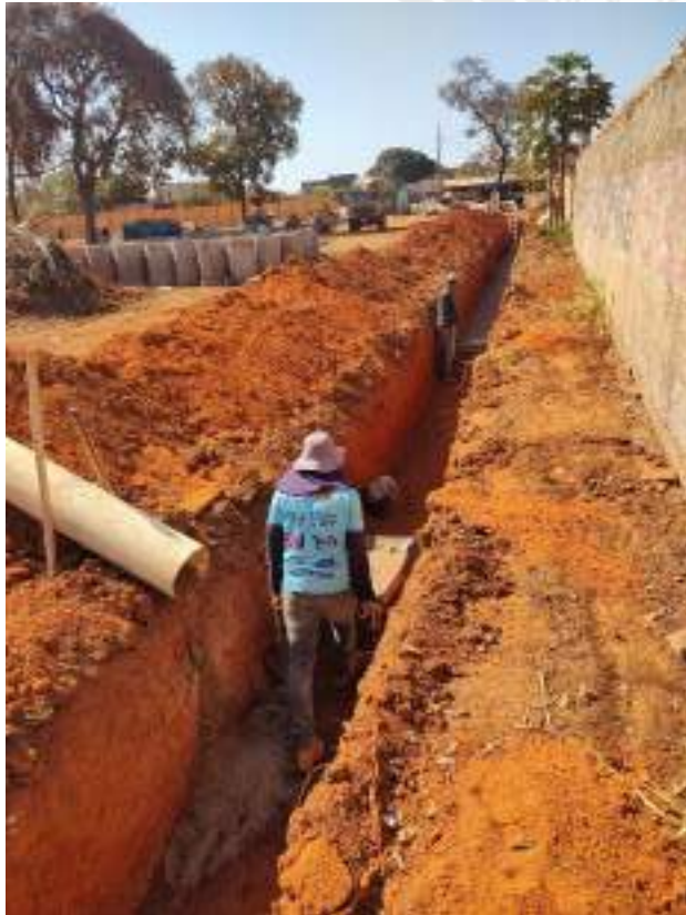
Foto 121 – Execução de rede de drenagem de 600mm
