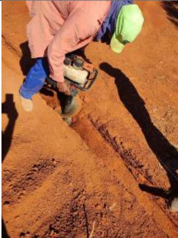
Foto 67 – Execução de fundação muro de arrimo
