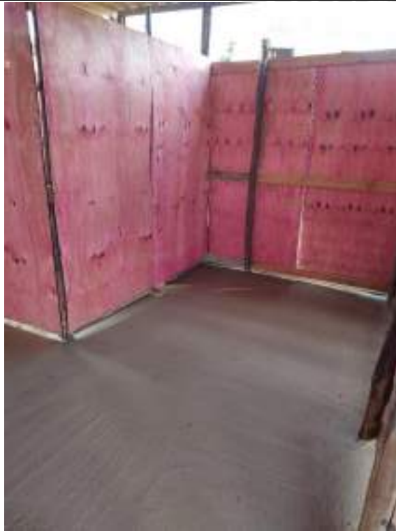
Foto 45 - Acerto e concretagem de piso dos barracões de obra
