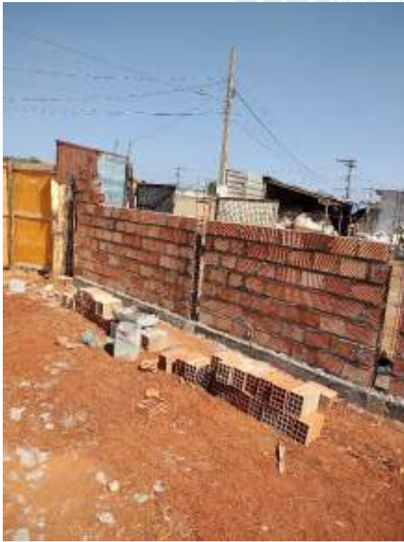
Foto 103 – Execução de muro de divisa
