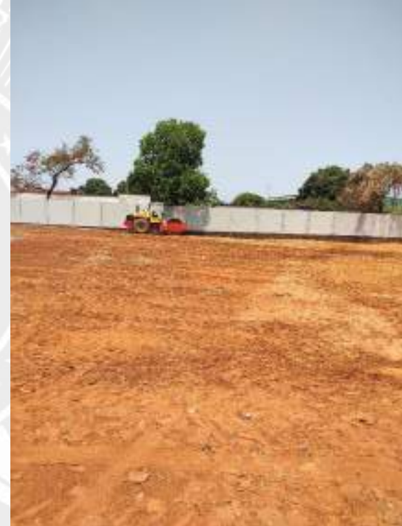
Foto 226 – Execução de compactação mecanizada do aterro da obra
