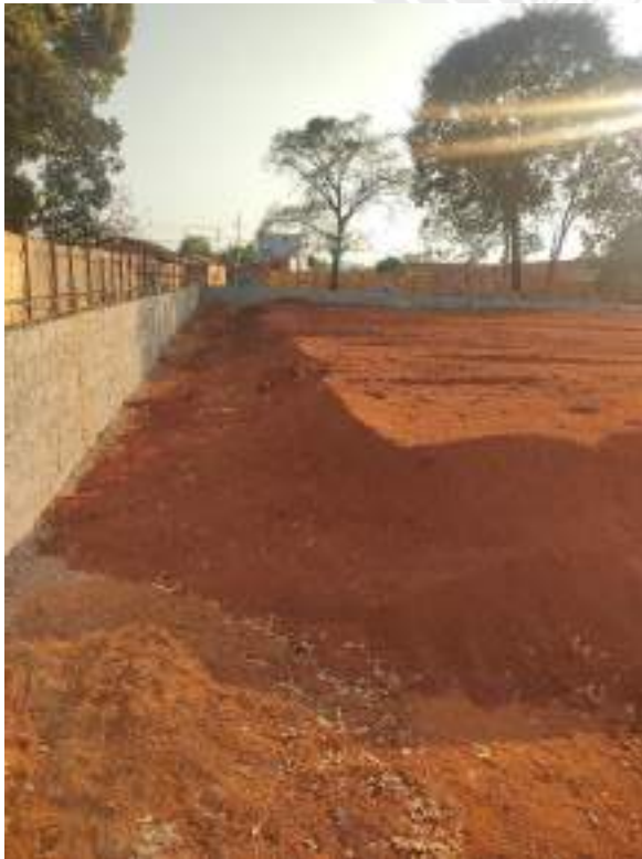
Foto 155 – Execução de aterro compactado da construção
