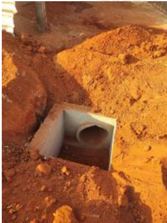
Foto 143 – Execução de caixa de drenagem
