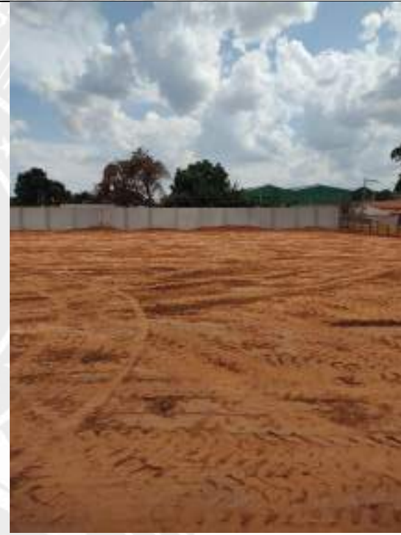
Foto 252 – Execução de aterro compactado
