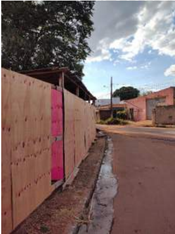
Foto 35 - Execução de telhado do barracão de obra
