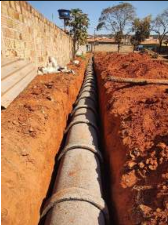
Foto 135 – Execução de rede de drenagem de 600mm
