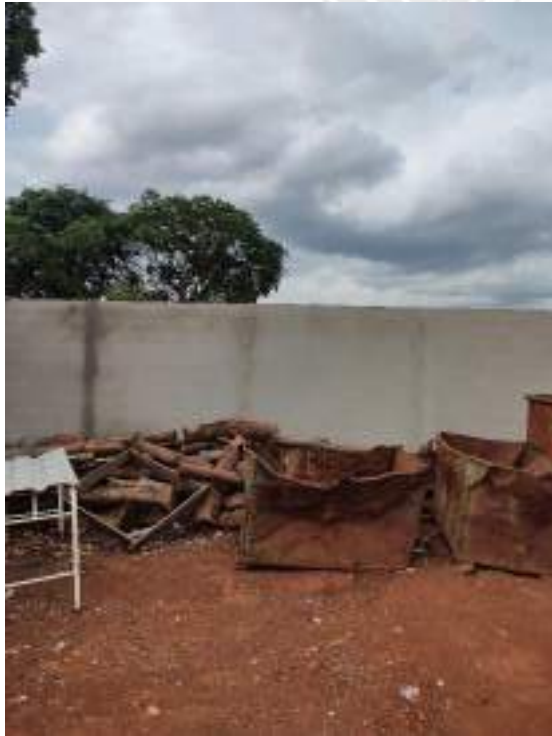
Foto 267 – Reboco dos muros de divisa
