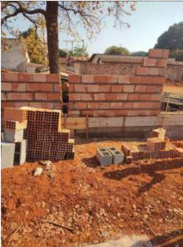
Foto 109 – Execução de muro de divisa
