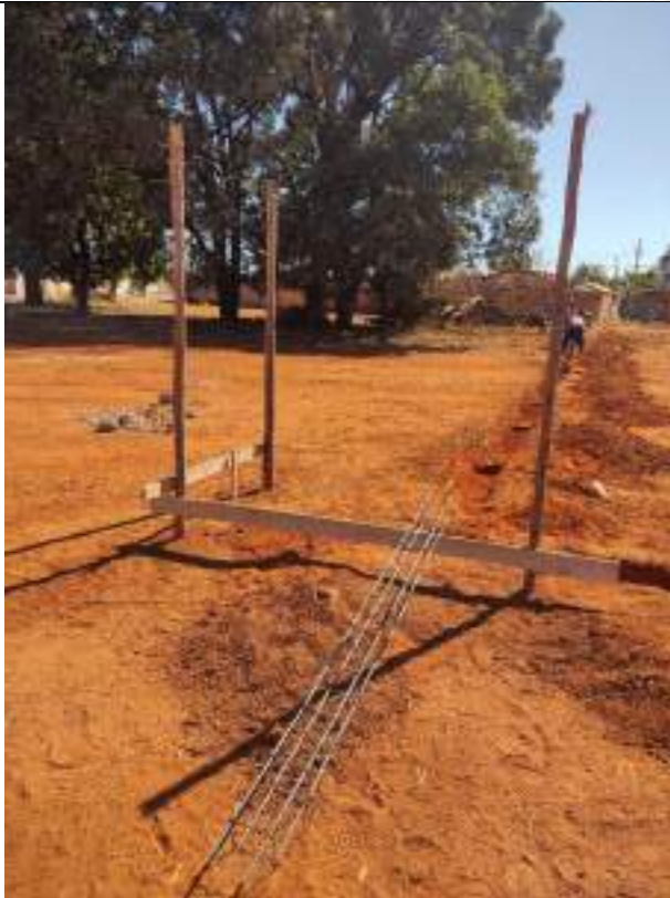
Foto 77 – Execução de gabarito de obra
