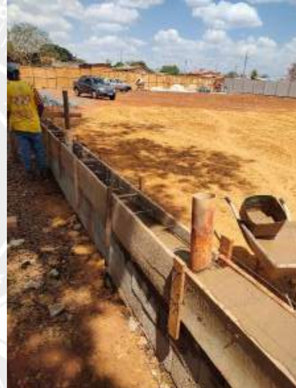
Foto 206 – Forma e concretagem de cintas
