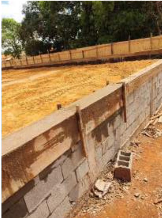
Foto 199 – Forma e concretagem de cintas
