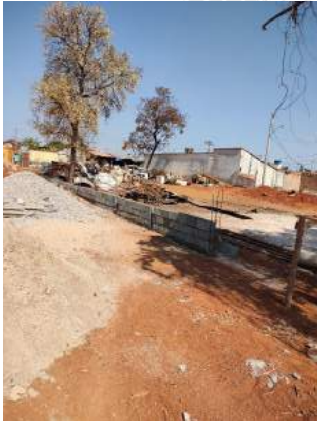
Foto 99 – Execução de muro de arrimo
