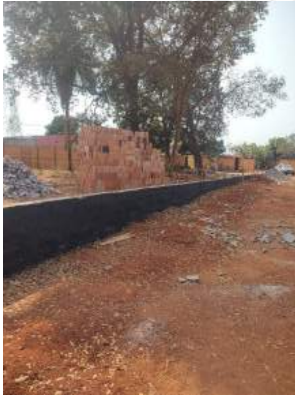
Foto 179 – Aplicação de impermeabilizante em muro de arrimo
