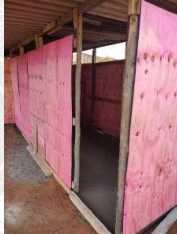
Foto 40 – Acerto e concretagem de piso dos barracões de obra
