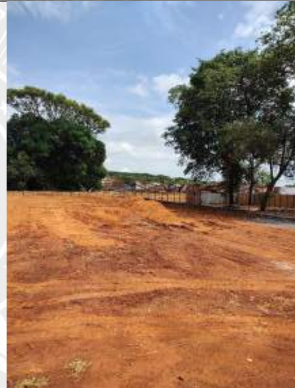
Foto 242 – Execução de aterro compactado
