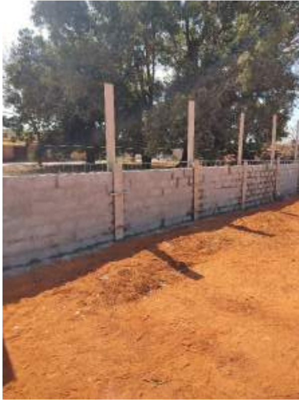
Foto 97 – Execução de rejunte em muro de arrimo
