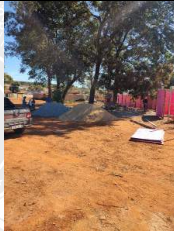
Foto 24 - Execução de tapume para fechamento de obra
