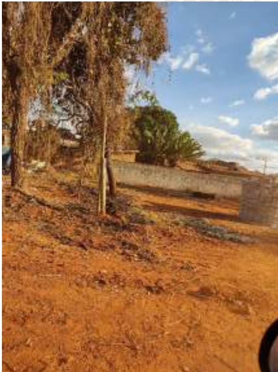
Foto 59 – Limpeza, corte e aterro para execução de terraplanagem
