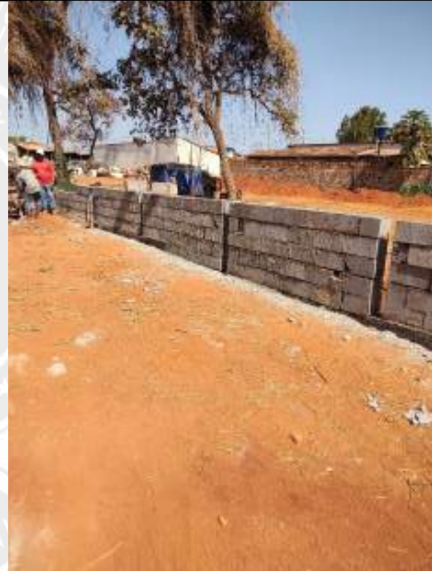
Foto 98 – Execução de muro de arrimo
