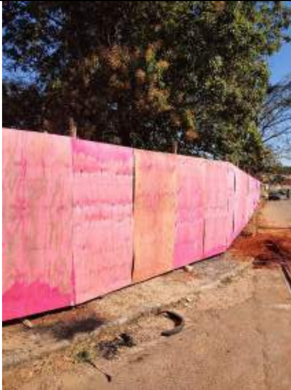
Foto 27 - Execução de tapume para fechamento de obra
