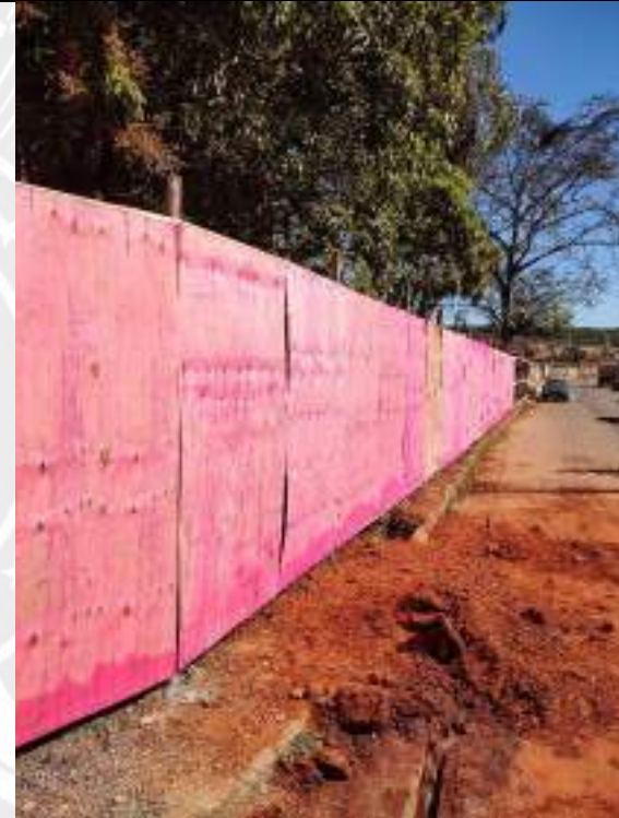
Foto 28 - Execução de tapume para fechamento de obra
