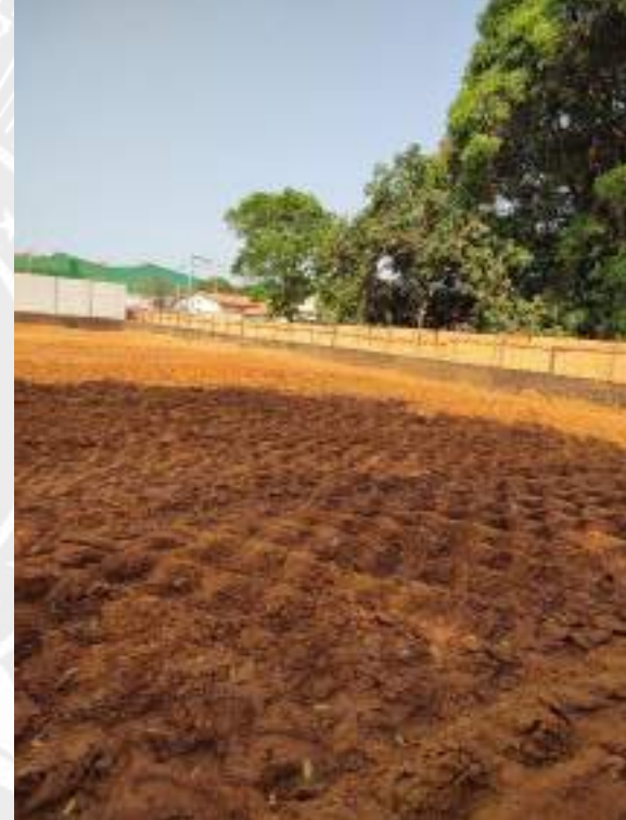
Foto 216 – Execução de compactação mecanizada do aterro da obra
