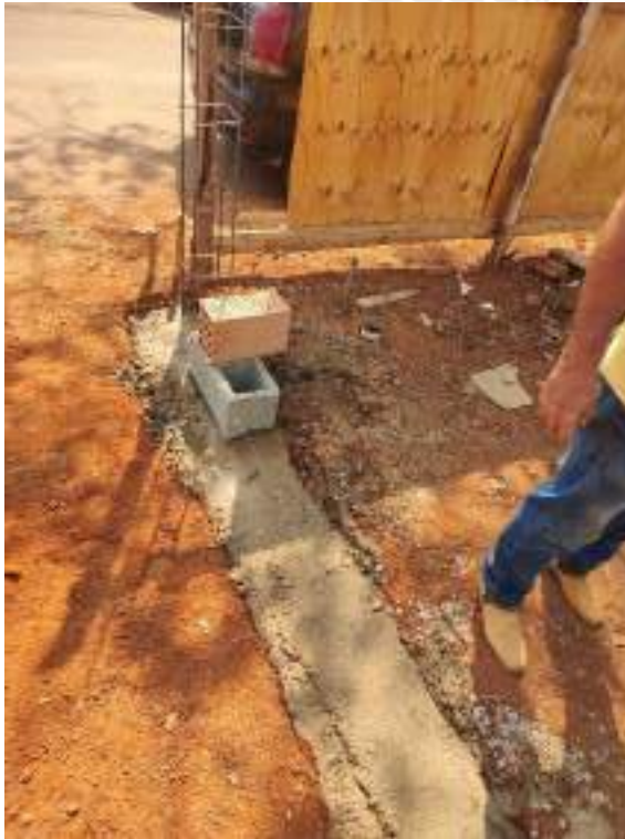
Foto 219 – Execução de fundação de muro de divisa
