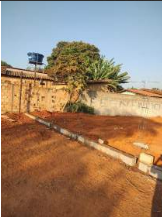
Foto 159 – Execução de fundação do muro de divisa
