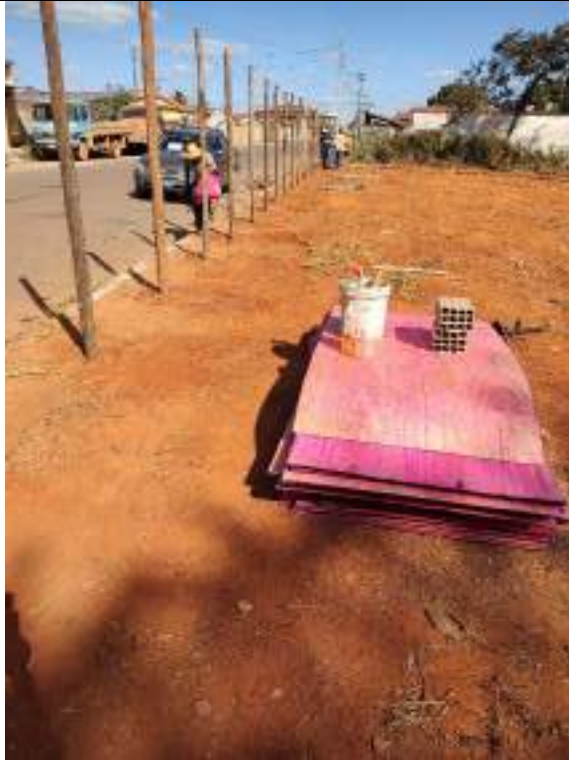
Foto 1 – Execução de tapume para fechamento de obra
