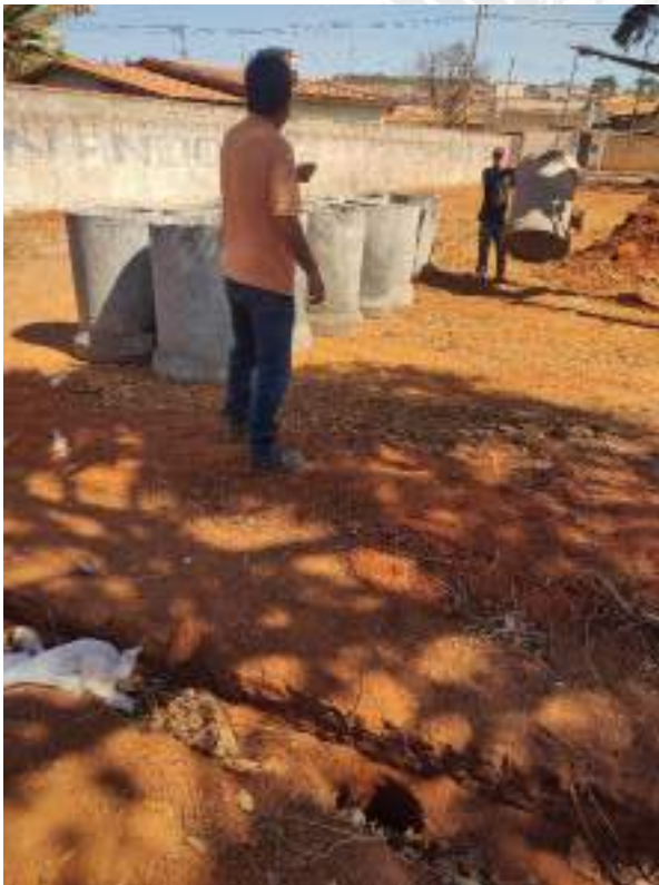
Foto 117 – Execução de rede de drenagem de 600mm
