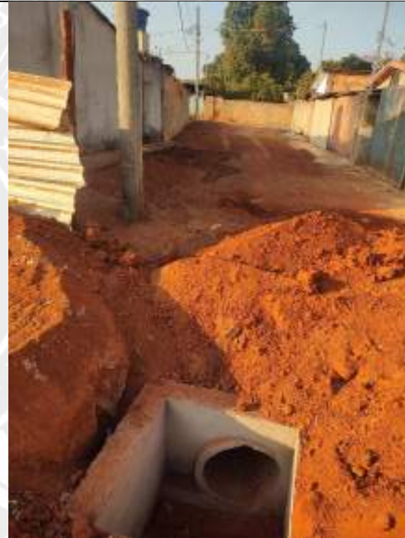
Foto 144 – Aterro compactado da rede de drenagem
