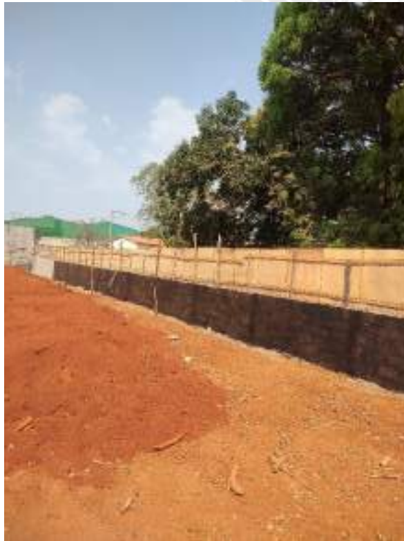
Foto 177 – Aplicação de impermeabilizante em muro de arrimo
