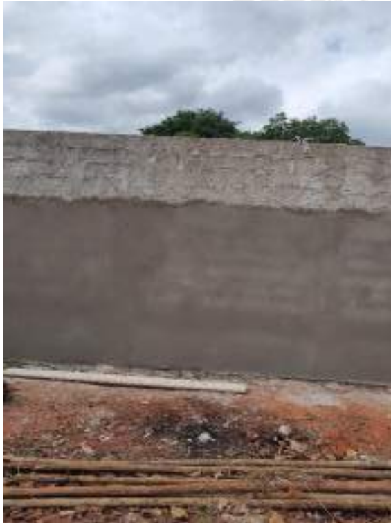
Foto 265 – Reboco dos muros de divisa
