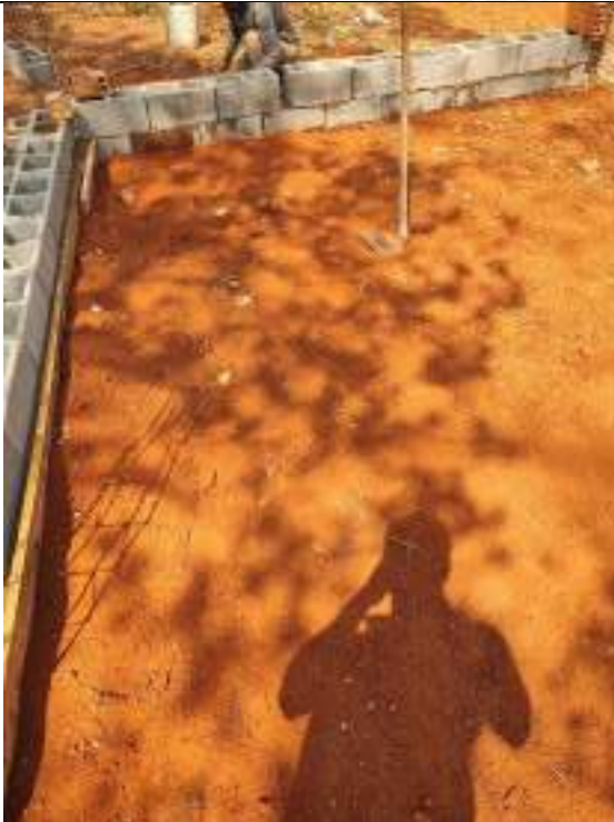
Foto 221 – Execução de fundação de muro de divisa
