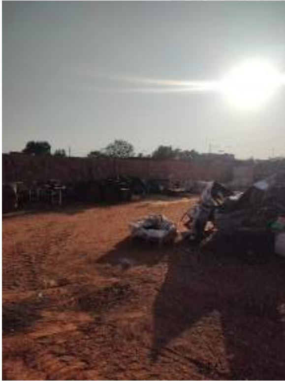
Foto 161 – Execução de muro de divisa
