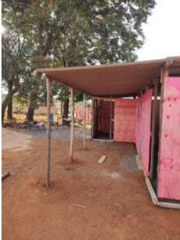
Foto 39 – Execução de telhado do barracão de obra
