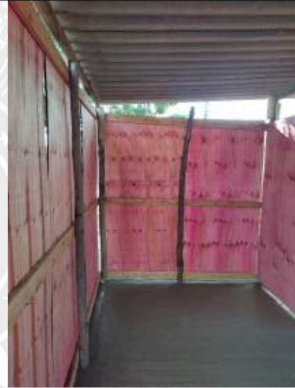
Foto 46 - Acerto e concretagem de piso dos barracões de obra
