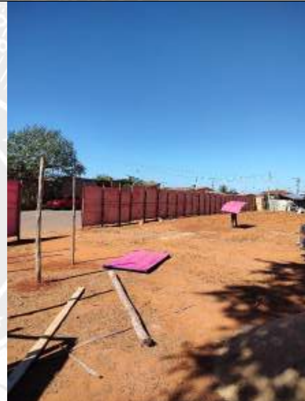
Foto 20 – Execução de tapume para fechamento de obra
