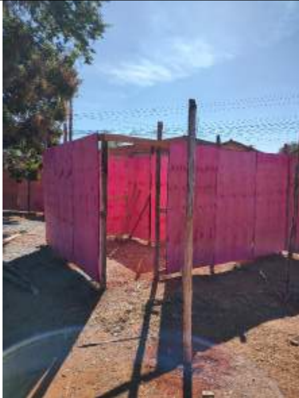
Foto 7 - Execução de barracão de obra com sanitário e depósito
