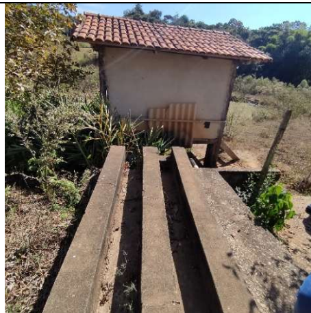
Foto 4: Em detalhe, condutores de água em alvenaria até a roda d'água do moinho. Alex Alves Pereira, 22 jul. 2025.
