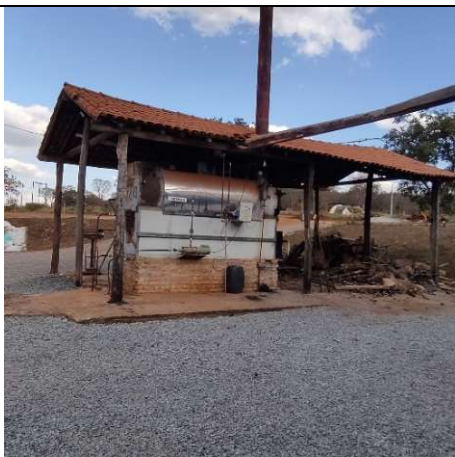
Figura 4: Detalhe da Caldeira a lenha e a vapor, utilizada para aquecer os alambiques. Alex Alves Pereira, 22 jul. 2025.
