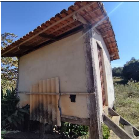
Foto 3: Vista em perspectiva do abrigo do moinho, ressaltando os pilares de madeira originais e a cobertura em telhas cerâmicas. Alex Alves Pereira, 22 jul. 2025.
